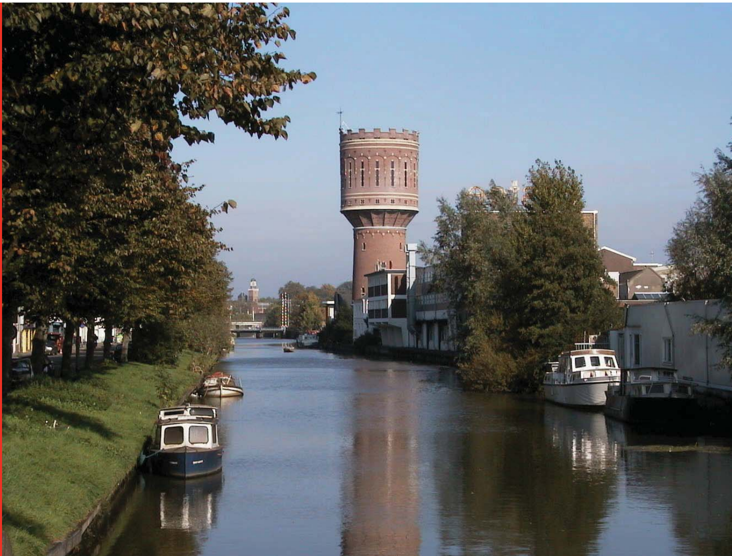
Watertoren Rotsoord. Een onderzoek naar de mogelijkheden van hergebruik
