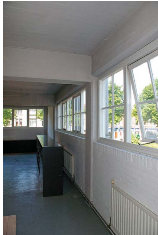
Afb. 75 Gebouw 11. Interieur van de eerste verdieping gezien in noordwestelijke richting. Zichtbaar zijn de borstweringen van wit gesausd metselwerk, afgesloten door een rollaag, en vensterstroken met 4-ruits ramen, geplaatst binnen de kolommen van de betonnen constructie.
