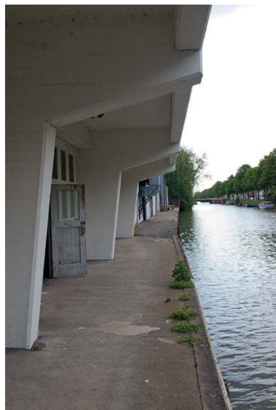
Afb. 69 Gebouw 11. Extérieur van het fabrieksgebouw naar een ontwerp van P. van der Wart uit 1950/51 gezien vanuit het noorden. Zicht op de boemerangvormige betonnen kolommen op de begane grond die de uitkragende bovenverdiepingen ondersteunen.
