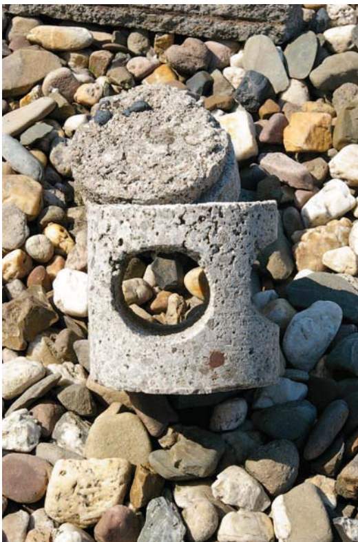
Afb. 82 Gebouw 12. Op het dak aangetroffen boorkernen, afkomstig van de platen van bimsbeton van het plafond op de tweede verdieping (dak).
