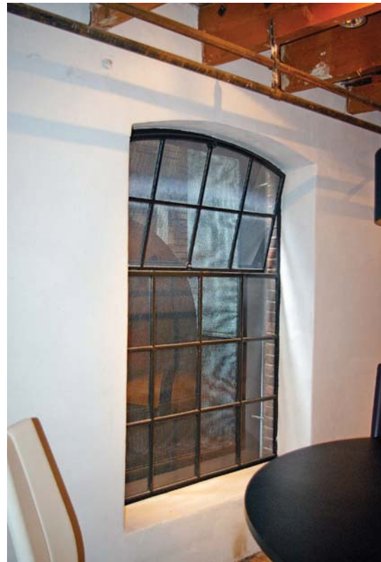
Afb. 48 Gebouw 3. Een van de gietijzeren ramen op de eerste verdieping.
