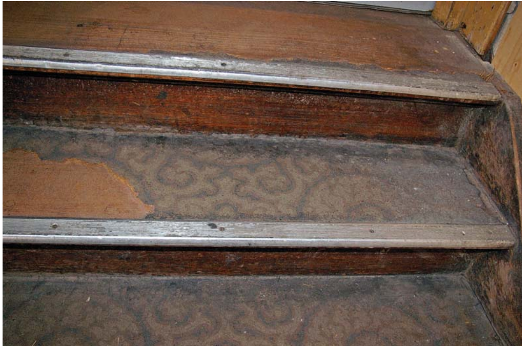
Afb. 33 Gebouw 1. Bedekking van de trap met sjabloonlinoleum, gelegd bij de inbouw - mogelijk rond 1906 of in 1918 - van de trap van gebouw 1 naar gebouw 3. Het linoleum is belangrijk omdat uit deze tijd en in deze vorm vrijwel geen voorbeelden nog in situ aanwezig zijn.
