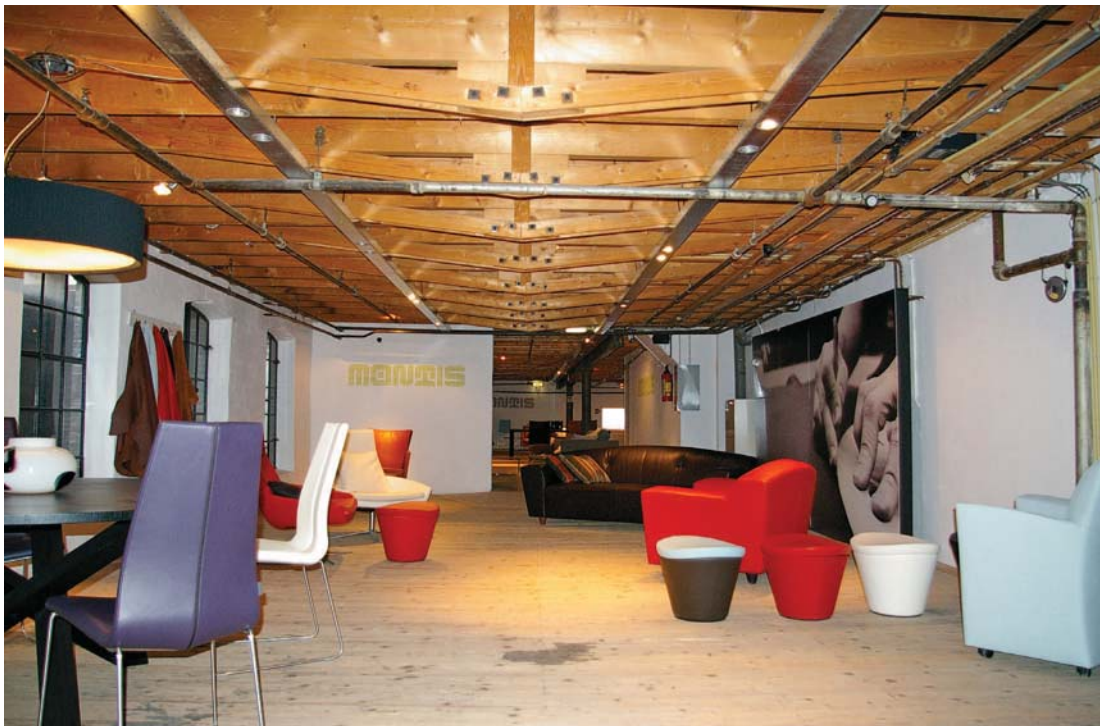
Afb. 47 Gebouw 3. Interieur van de eerste verdieping. De houten balklaag van het plafond is ca. 1950 versterkt met een houten onderslagconstructie ten behoeve van de vloer van de tweede verdieping. Op de achtergrond is gebouw 4 zichtbaar. De muur tussen gebouw 3 en 4 is op de verdieping weggebroken.
