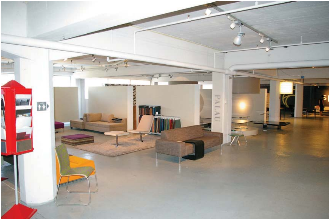
Afb. 81 Gebouw 12. Interieur van de eerste verdieping. Het plafond (verdiepingsvloer tweede verdieping) bestaat uit betonplaten waarop de bekistingsporen zichtbaar zijn.
