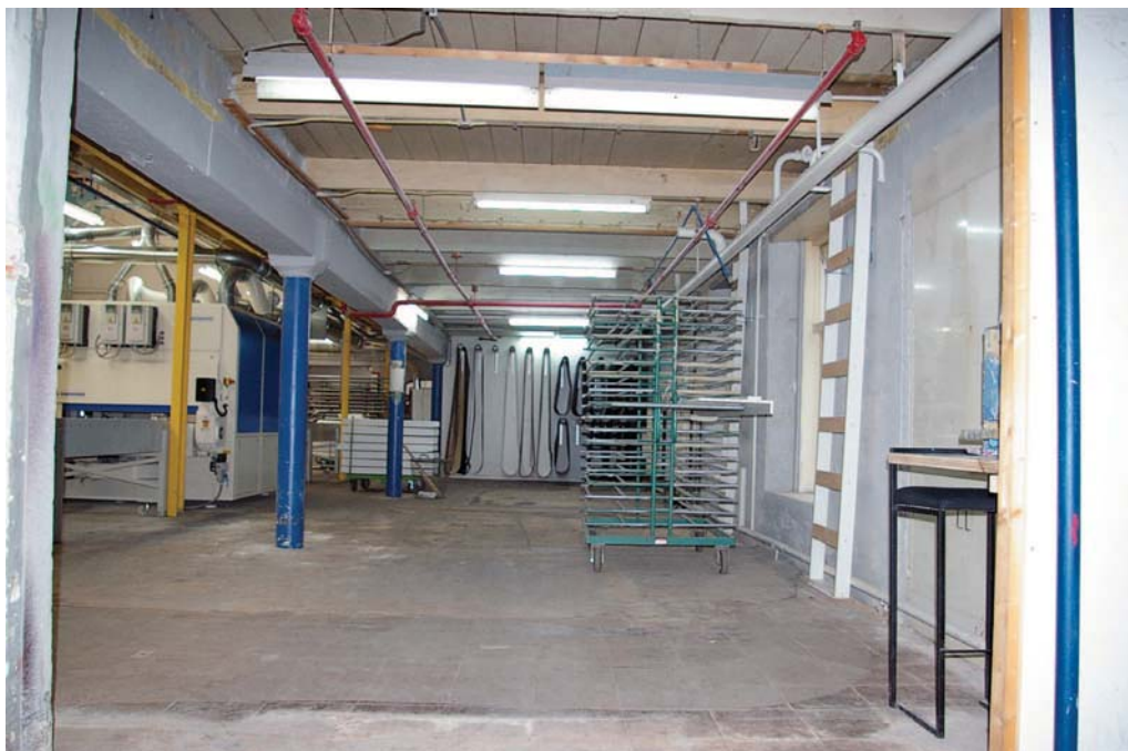
Afb. 34 Gebouw 1. Interieur op de begane grond gezien naar het zuiden. De oostelijke muur (links op de foto) is weggebroken en wordt opgevangen door een betonnen balk op stalen kolommen. Het plafond bestaat uit een enkelvoudige balklaag met daarop deels nog de brede, laat-17de-eeuwse vloerdelen van de verdiepingvloer. Op de vloer liggen pantsertegels uit de jaren twintig.
