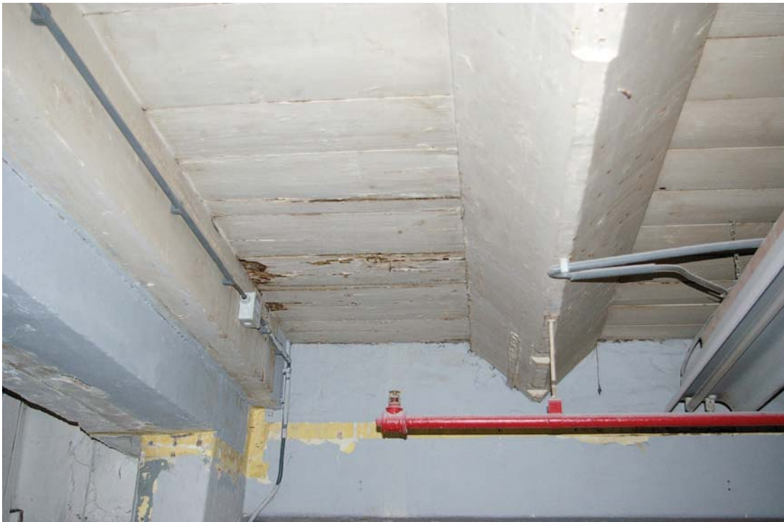
Afb. 22 Gebouw 1, overhoeks geplaatste balken behoren bij de eerste fase van het gebouw, eind 17de eeuw. De linkerbalk is de randbalk van het gebouw. De overhoekse balk is met een anker in de muur bevestigd. De vloerplanken dateren uit dezelfde tijd als de balken.
