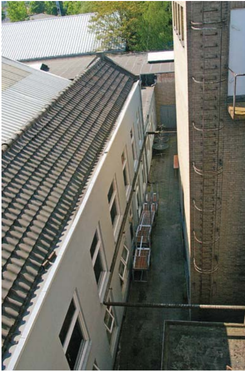
Afb. 29 Gebouw 1. Het in oorsprong laat-17de-eeuwse, smalle en langgerekte tweelaags gebouw heeft een tuitgevel aan de zuidzijde. Het zadeldak is gedekt met nieuwe gesmoorde pannen. Ook het houtwerk van de vensters is vernieuwd en de gevels zijn opnieuw gepleisterd.
