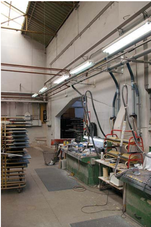
Afb. 40 Gebouw 2. Doorbraak in de oostelijke zijmuur op de begane grond als verbinding met naastgelegen hal (gebouw 13).
