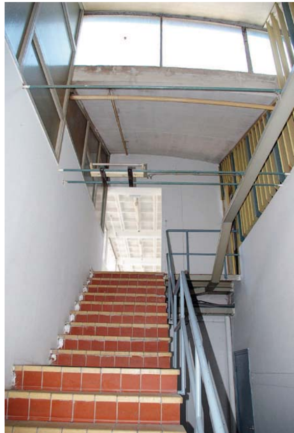
Afb. 87 Gebouw 13. Interieur van het aan de noordoostzijde van de productiehal uit 1957 ingebouwde trappenhuis. Het gebogen plafond in het trappenhuis is een segment van een van de schelpsheddaken. De afwerking dateert uit de bouwtijd, evenals het lamellengordijn rechtsboven.
