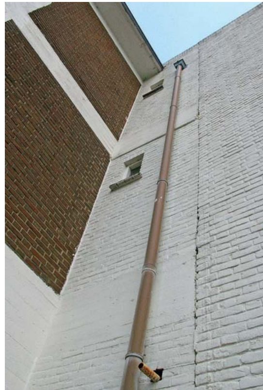
Afb. 70 Gebouw 11. Extérieur van het trappenhuis van het in 1952 voltooide fabrieksgebouw, ingeklemd in de wigvormige ruimte tussen de gebouwen 11 en 8.
