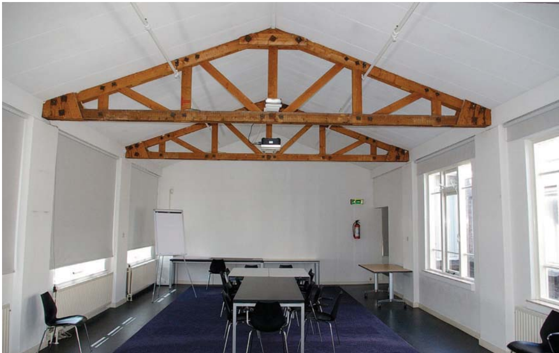
Afb. 46 Gebouw 3. Interieur van de tweede verdieping uit ca. 1950 met hergebruikte vakwerkspantconstructie uit 1893.
