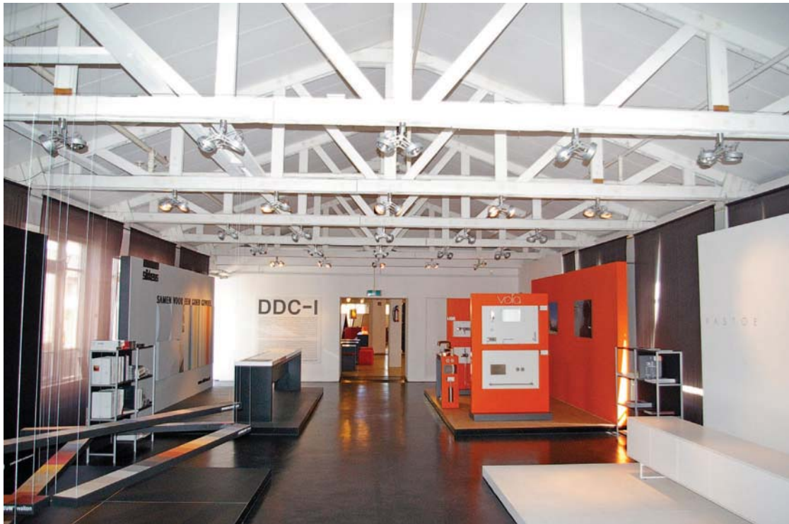
Afb. 50 Gebouw 4. Interieur van de tweede verdieping uit ca. 1950 met hergebruikte houten vakwerkspantconstructie uit 1893.
