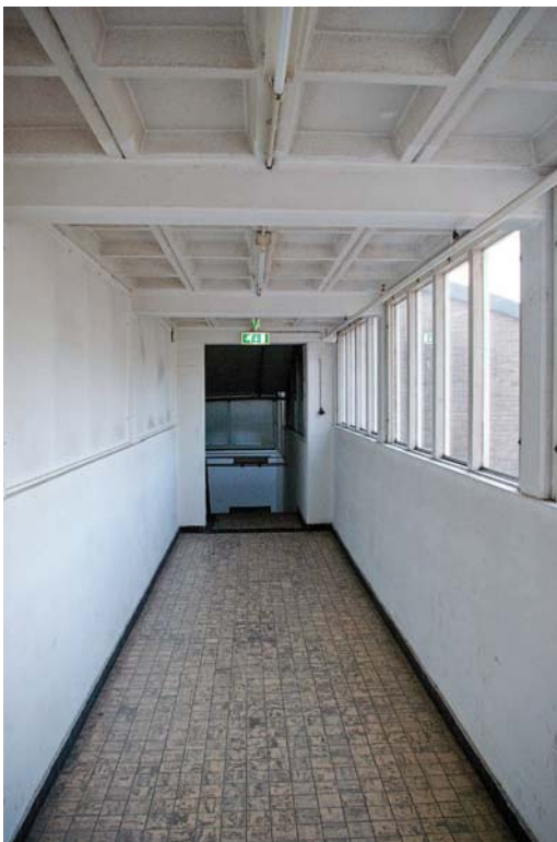
Afb. 93 Gebouw 17. Interieur van de verbindingsgang op de eerste verdieping tussen de gebouwen 12 en 13 uit 1957 gezien in zuidelijke richting. De gang is voorzien van een grijswit gemarmerde tegelvloer en bimsbetonplaten met cassetten uit de bouwtijd.
