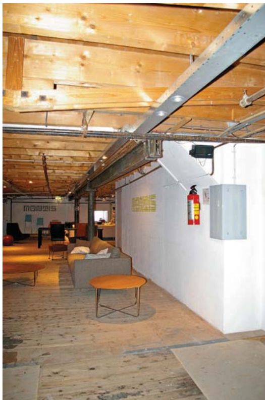
Afb. 51 Gebouw 4. Interieur van de eerste verdieping. De houten balklaag van het plafond is versterkt met een ijzeren ligger op kolommen ter ondersteuning van de vloer op de tweede verdieping. Op de voorgrond de overgang tussen gebouw 3 naar gebouw 4. De vloer van gebouw 4 ligt zo'n 10 cm hoger dan die van gebouw 3.
