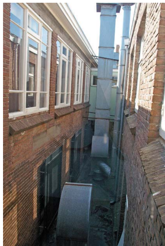
Afb. 49 Gebouw 4. Links is de westelijke zijgevel van gebouw 4 zichtbaar met de eerste en tweede verdieping. Bij de bouw van de tweede verdieping ca. 1950 is hier geen betonnen balk in de gevel aangebracht zoals bij gebouw 3. Op de eerste verdieping bevinden zich nog de originele gietijzeren ramen. Die op de tweede verdieping zijn van hout. Rechts is de zijgevel van gebouw 8 te zien. Op de begane grond is de ruimte tussen beide gebouwen overdekt.
