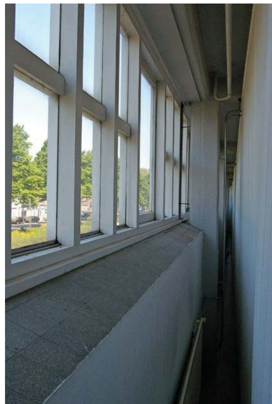
Afb. 63 Gebouw 8. Interieur van het gebouw uit 1926 met detail van de vernieuwde pui met een vensterstrook boven een met tegels afgedekte betonnen borstwering.
