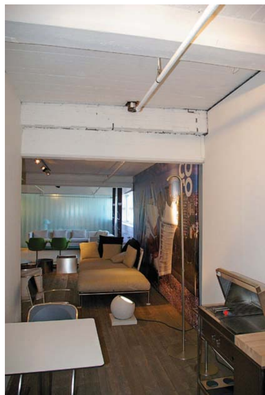
Afb. 74 Gebouw 11 (doorbraak tussen gebouw 11 en 8). Interieur met zicht in zuidelijke richting op de eerste verdieping van gebouw 8 vanuit gebouw 11. De scheidingsmuur tussen beide gebouwen is hier weggebroken ten behoeve van de huidige toonzaal.
