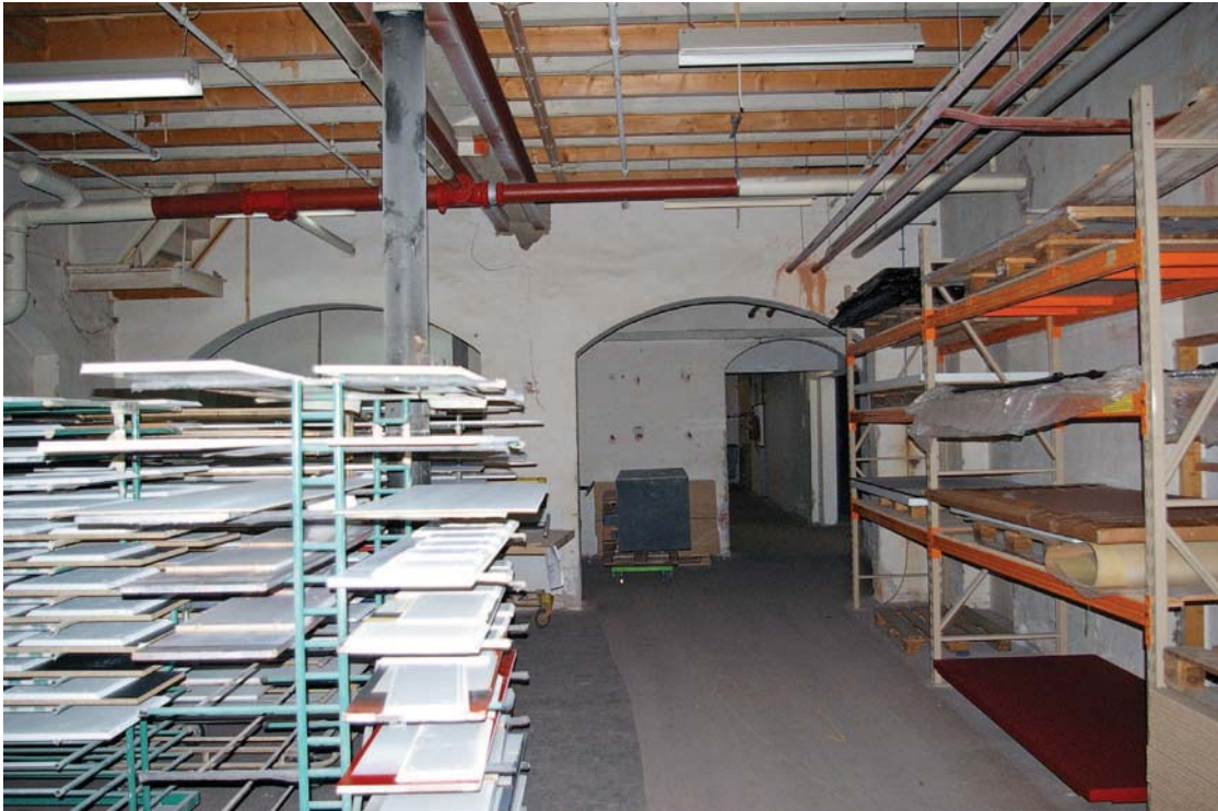
Afb. 52 Gebouw 4. Interieur van de begane grond gezien naar het zuiden. De gemetselde wanden met brede doorgangen zijn gepleisterd.
