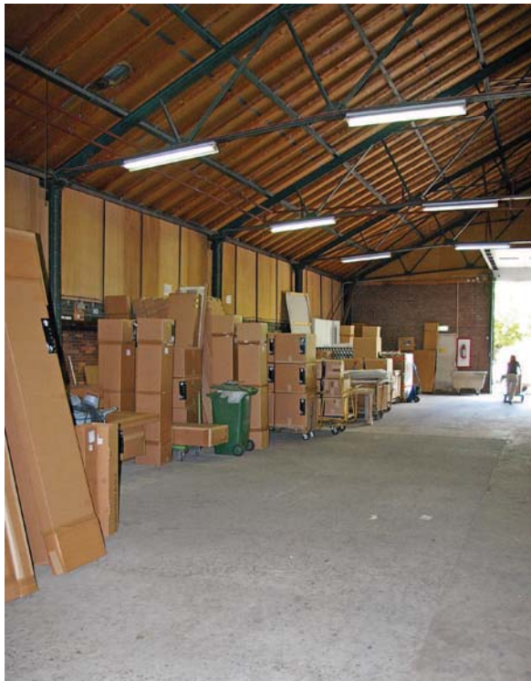
Afb. 95 Gebouw 18. Interieur van de loods voor (hout)opslag opgetrokken ca. 1960 gezien naar het oosten met een draagconstructie uit ca. 1915 van geklonken kolommen van kwadrantijzer op betonnen voet en een geklonken ijzeren vakwerkspantconstructie.
