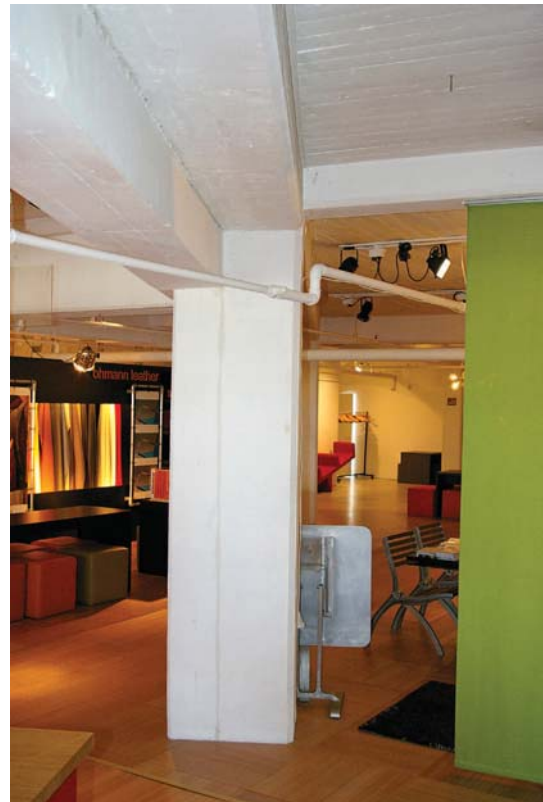
Afb. 73 Gebouw 11. Interieur van de eerste verdieping. Op alle verdiepingen staan op de aansluiting tussen de delen uit 1952 en 1957 van het gebouw dubbele vierkante kolommen waarop een dubbele balk, geplaatst in de schuine lijn van de voormalige rooilijn van het Rotsoord zoals die hier tot 1955 lag. In het plafond zijn de bekistingsporen zichtbaar.
