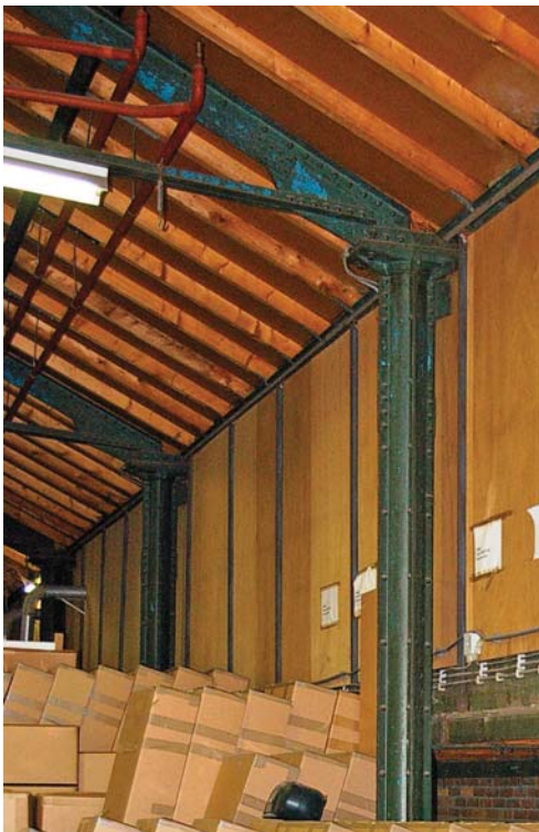
Afb. 23 Gebouw 18, kolom van kwadrantijzer. Deze kolom is als secundaire constructie toegepast in de als tijdelijk bedoelde loods.
