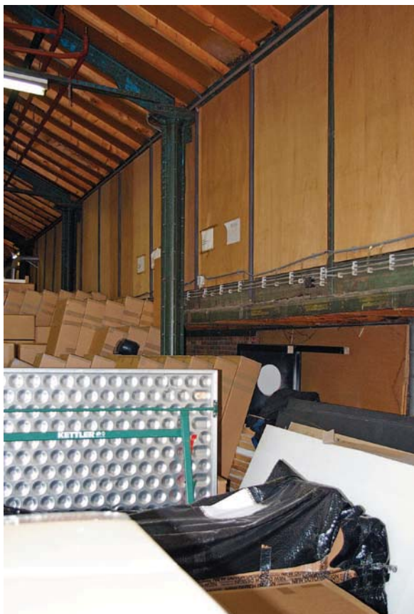
Afb. 96 Gebouw 18. Interieur met detail van een kolom van geklonken kwadrantijzer uit ca. 1915.
