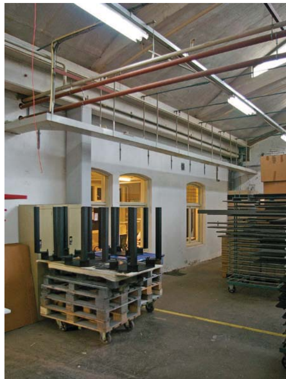
Afb. 88 Gebouw 13. Interieur van de productiehal gezien naar het noordwesten. Zichtbaar is dat de betonconstructie van kolommen en liggers, die het sheddak ondersteunen, tegen de zijgevel van gebouw 2 uit 1893 is aangezet.
