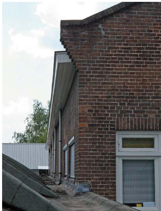
Afb. 55 Gebouw 5. De gevels van de tegelmakerij met kantoren zijn op de verdieping (buiten) niet gepleisterd. De noordgevel is ca. 1950 gemoderniseerd en voorzien van nieuwe samengestelde vensters.
