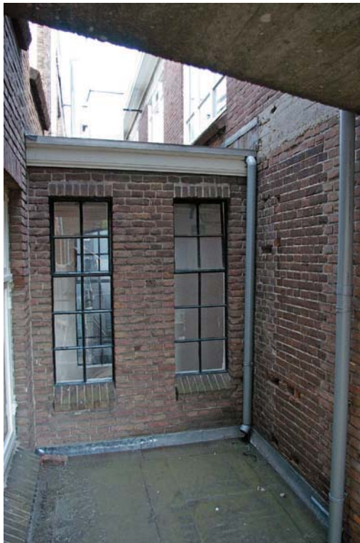
Afb. 45 Gebouw 3. Verbinding (overdekte luchtbrug) tussen gebouw 3 en 8 op de eerste verdieping.
