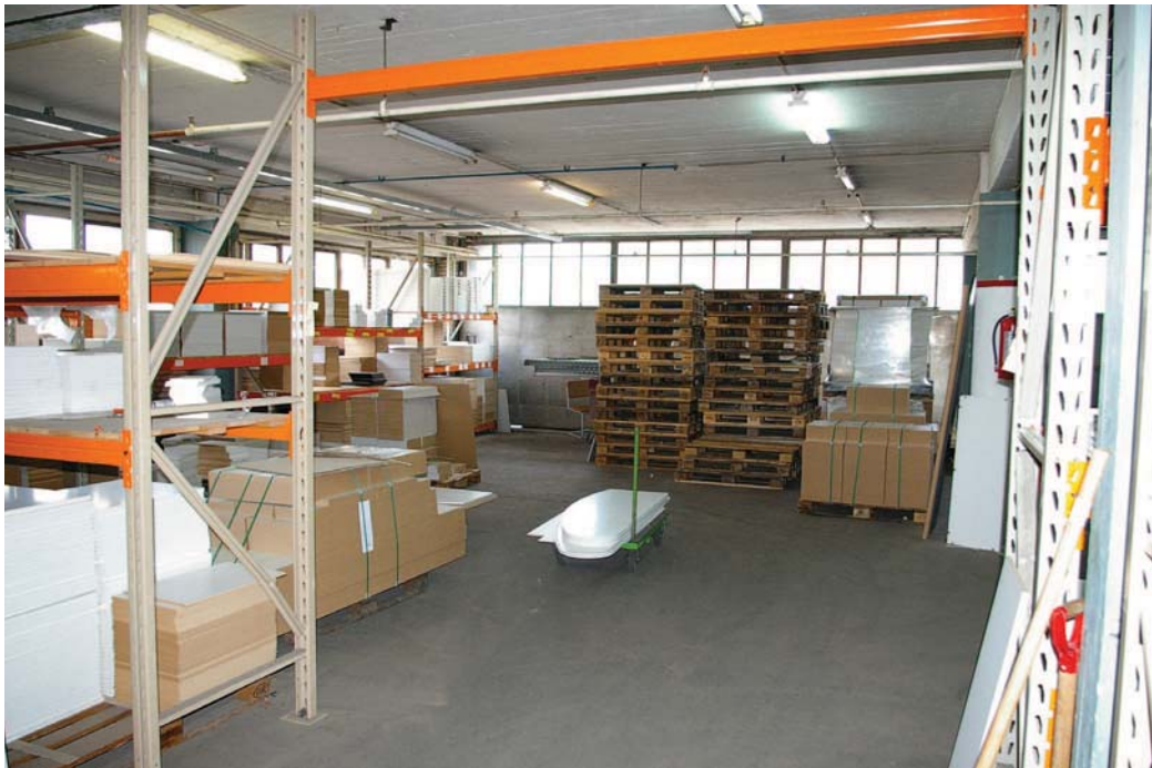
Afb. 83 Gebouw 12. Interieur van het magazijn op de begane grond gezien naar het oosten. In de oostgevel (gevel aan de zijde van het Rotsoord) zitten grote kanteeldeuren. Tussen de twee voorste balkvakken ontbreekt de plafondbalk in verband met de benodigde inrijhoogte.
