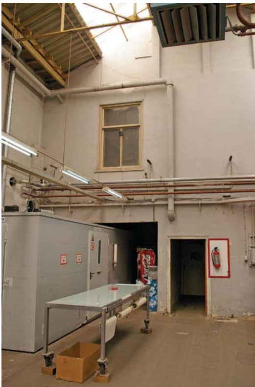
Afb. 53 Gebouw 5. De gepleisterde zuidgevel van de tegelmakerij met kantoren aan de noordzijde van de hal uit 1893 met op de verdieping een T-venster. De gevelindeling op de begane grond is gewijzigd.
