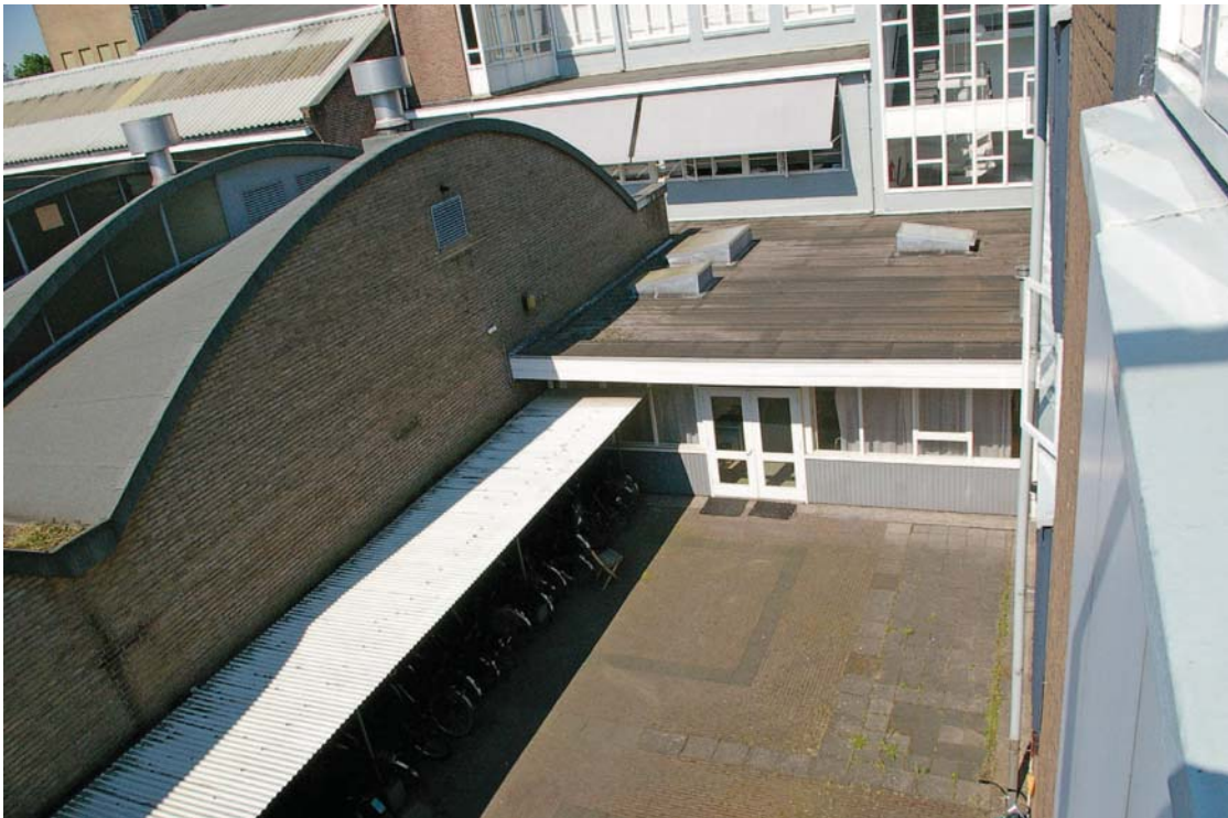
Afb. 92 Gebouw 16. Zicht op het aan de westzijde van de binnenplaats in ca. 1957 opgetrokken eenlaags bouwdeel, oorspronkelijk met een aan een gang gelegen portiersloge en wachtkamer en thans in gebruik als kantoor. Het bestratingpatroon op de binnenplaats dateert voor een groot deel ook nog uit ca. 1957.
