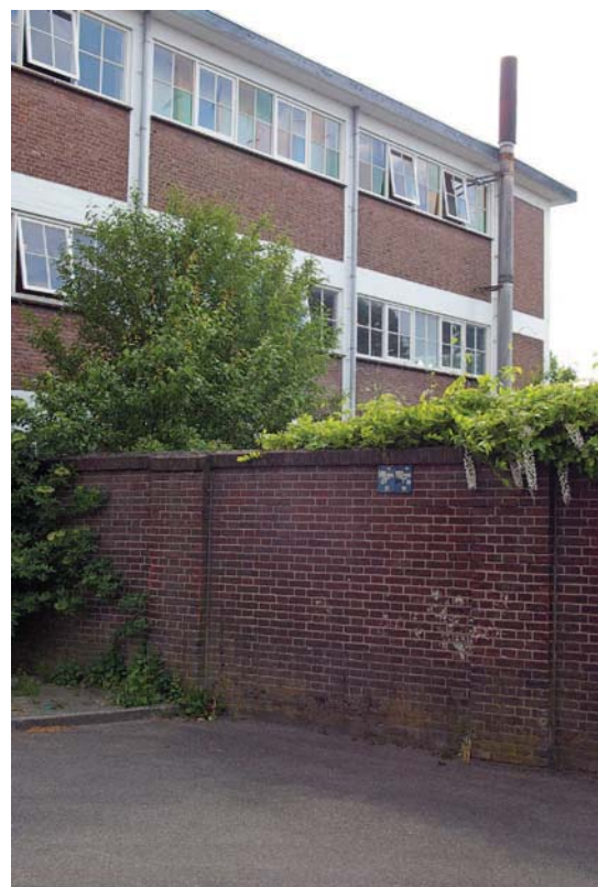
Afb. 71 Gebouw 11. Het in 1952 voltooide fabrieksgebouw, gezien vanuit het noorden. De betonnen constructie is gevuld met metselwerk en horizontale vensterstroken.
