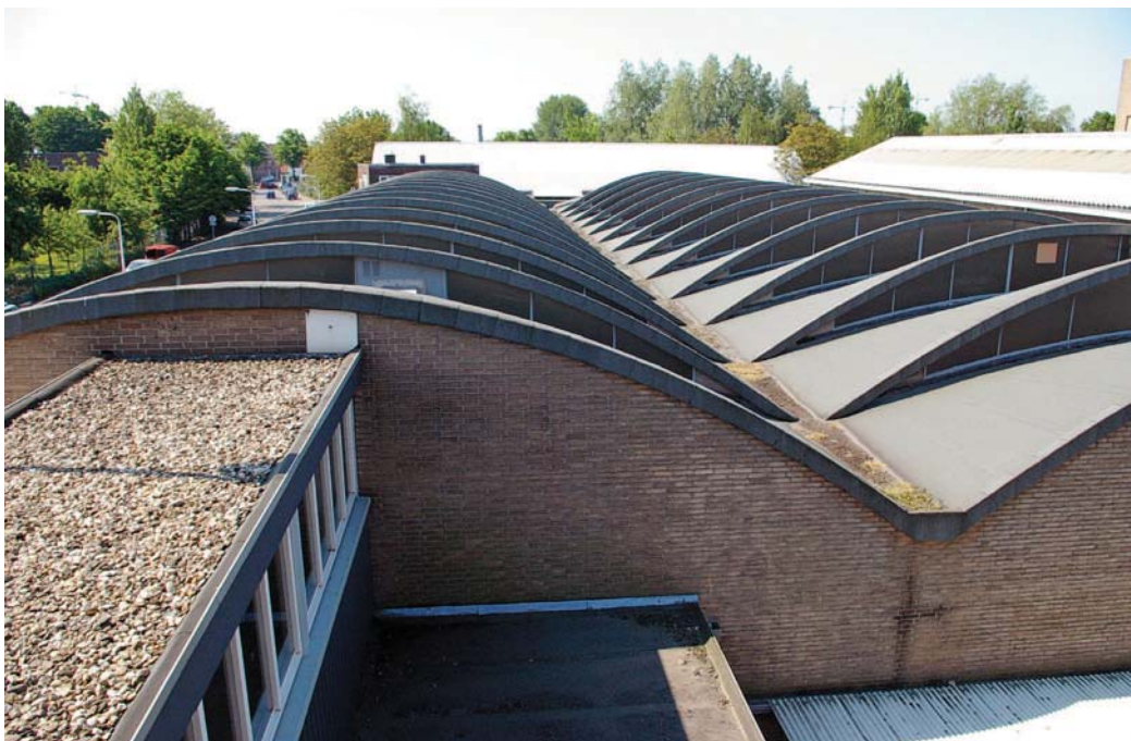
Afb. 84 Gebouw 13. Zicht vanuit het noordoosten op de productiehal met schelpsheddak uit 1957. De vorm van het dak volgt de tweebeukige indeling van de hal. De lichtinval in de hal is vanuit het noorden. De gevels zijn opgetrokken van gele baksteen in klezorverband. Op de voorgrond links is de gang op de eerste verdieping zichtbaar die de verbinding vormt tussen de gebouwen 12 en 13.
