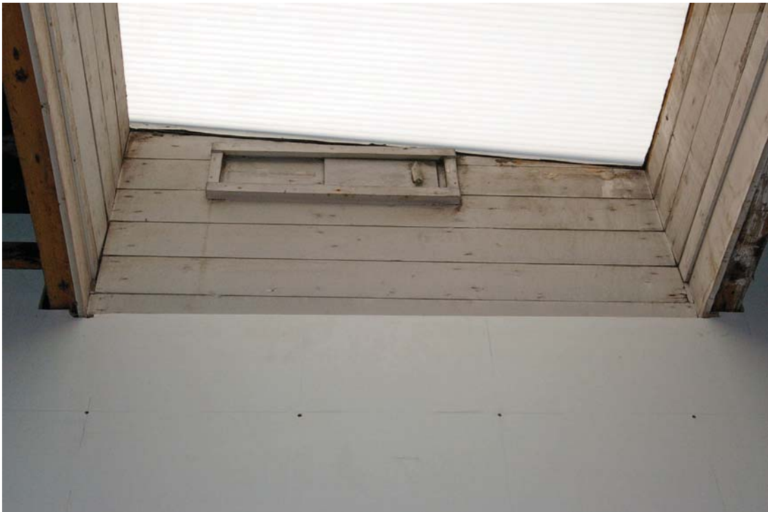
Afb. 60 Gebouw 7. Houten opbouw van de lichtkoepel, met ventilatieschuif.
