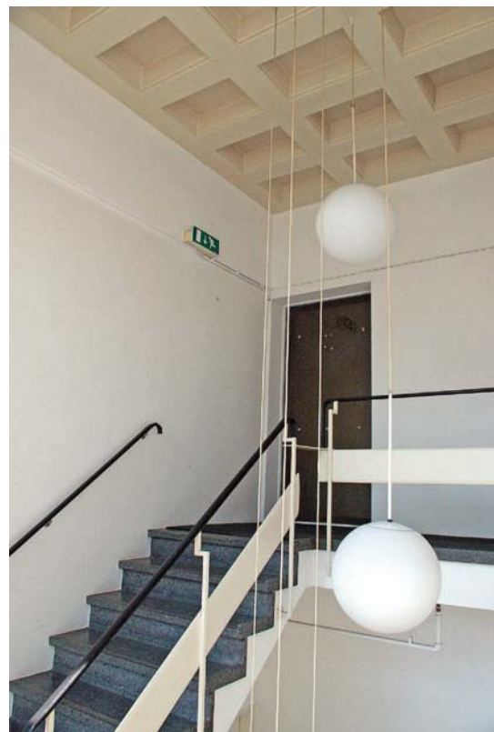
Afb. 91 Gebouw 15. Het in beton uitgevoerde trappenhuis uit 1957 heeft gestucte wanden en een cassetteplafond. De vloer en de trap zijn met granito bekleed.
