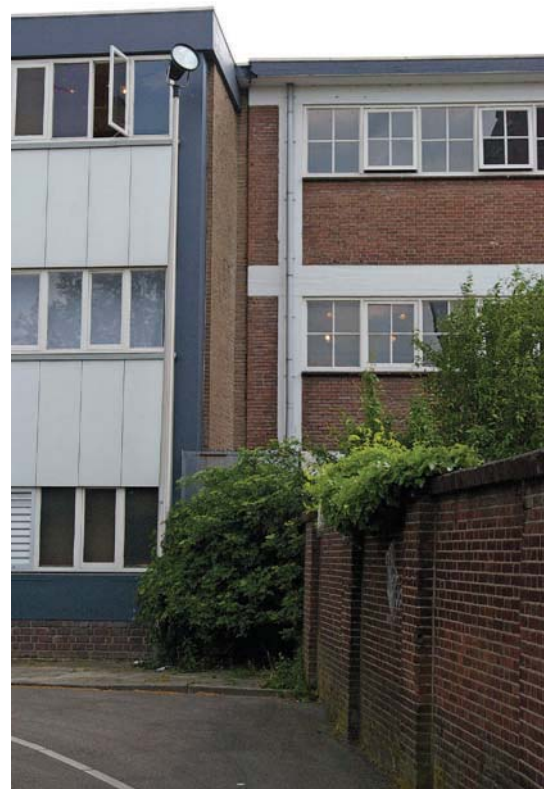
Afb. 78 Gebouw 11 en 12. Zicht op de noordgevel van het bouwdeel uit 1957 (links op de foto) en het deel uit 1952 (rechts). Opvallend is het verschil in afwerking. Bij het deel uit 1952 is de binnen de betonconstructie gemetselde borstwering in het zicht gelaten met daarboven horizontale vensterstroken voorzien van vierruits ramen. Bij het gedeelte uit 1957 is het metselwerk aan de buitenzijde bekleed met kunststofplaten waardoor het metselwerk en de feitelijke betonconstructie grotendeels aan het zicht zijn onttrokken. Ook de ramen van de vensterstroken wijken af.
