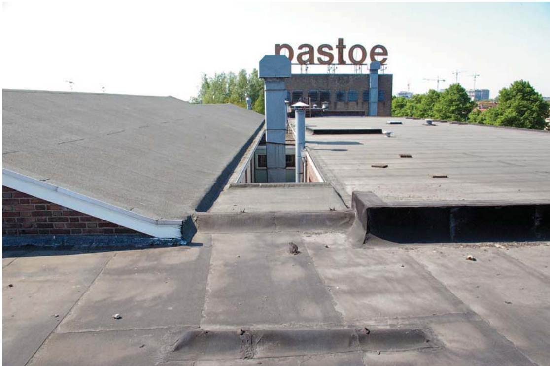
Afb. 44 Gebouw 3 en 4. Daklandschap met links het doorlopende dak van de gebouwen 3 en 4 en rechts het platte dak van gebouw 8. Op de voorgrond het platte dak van gebouw 11.
