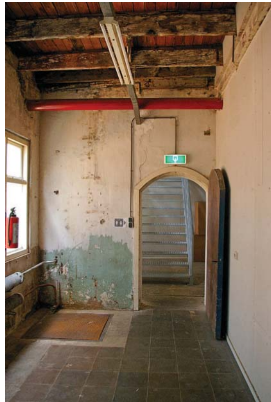
Afb. 58 Gebouw 7. Interieur van het westelijk deel van het van oorsprong laat-19de-eeuwse gebouw dat thans fungeert als gang naar gebouw 1. Het plafond bestaat uit een enkelvoudige balklaag met houten delen. De balken lopen door boven de scheidingsmuur rechts op de foto. De deur op de achtergrond is mogelijk een oude, met platen betimmerde buitendeur.
