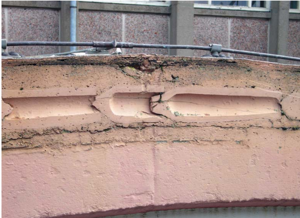
Afb. 26 Arnhem, treinstation uit 1954. Detail van de doorgesneden constructie van het fuséedak, waarbij zowel halve als hele fusées zijn toegepast. (Foto R. Stenvert, 2007)
