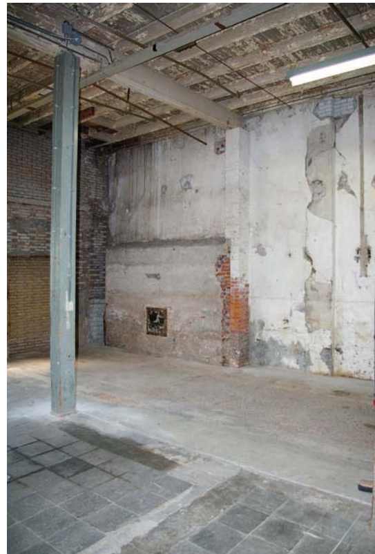
Afb. 68 Gebouw 10. Interieur van de loods uit 1927. Rechtsachter in het westelijk deel (aan de zijde van de Vaartsche Rijn) bevindt zich een voormalig stookgat, vermoedelijk een restant van het oude ketelhuis uit 1918 en aangebouwde mothokken.
