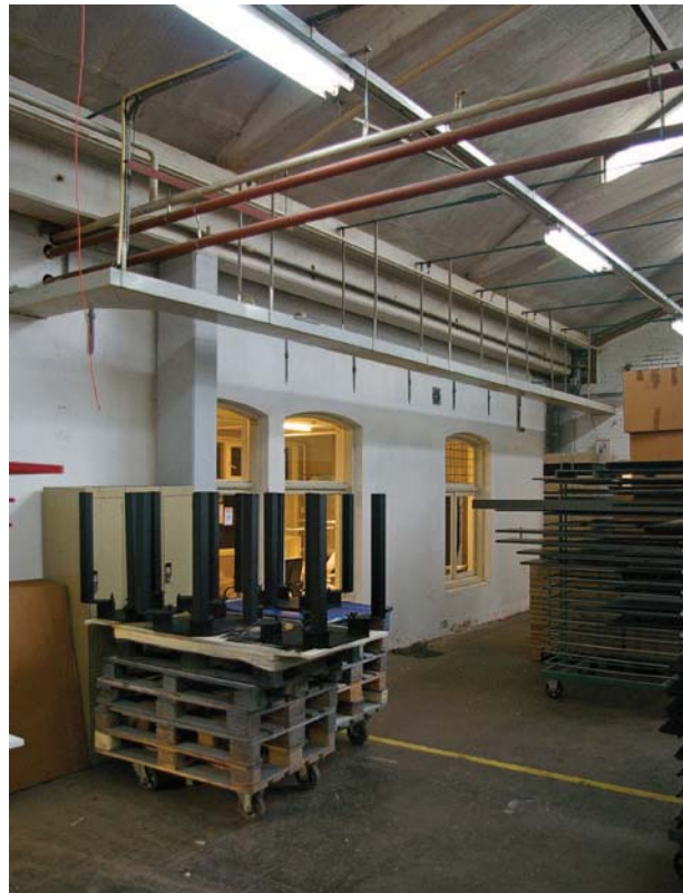
Afb. 54 Gebouw 5. De gepleisterde oostelijke zijgevel (oorspronkelijk buitengevel) van de tegelmakerij met kantoren uit 1893 met op de begane grond een drietal getoogde vensternissen met gemoderniseerde schuiframen.
