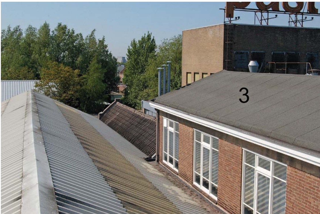
Afb. 41 Gebouw 3. De tweede verdieping, met grote samengestelde vensters uit ca. 1950, is gebouwd op het uit ca. 1893 daterende gebouw. De oorspronkelijke kapconstructie is hergebruikt.
