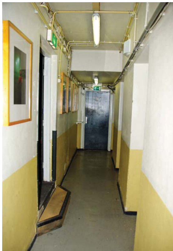
Afb. 141 Gang (0.10) tussen het Weeshuisdeel (links) en de het deel aan het pandhof dat vroeger priorwoning en comptoir is geweest en later tot kleedkamers werd verbouwd, gezien naar het zuiden. De deur met trede geeft toegang naar de hall. Rechts daarnaast is vaag nog de aftekening van een dichtgezette opening zichtbaar maar de voormalige keuken op de binnenplaats.
