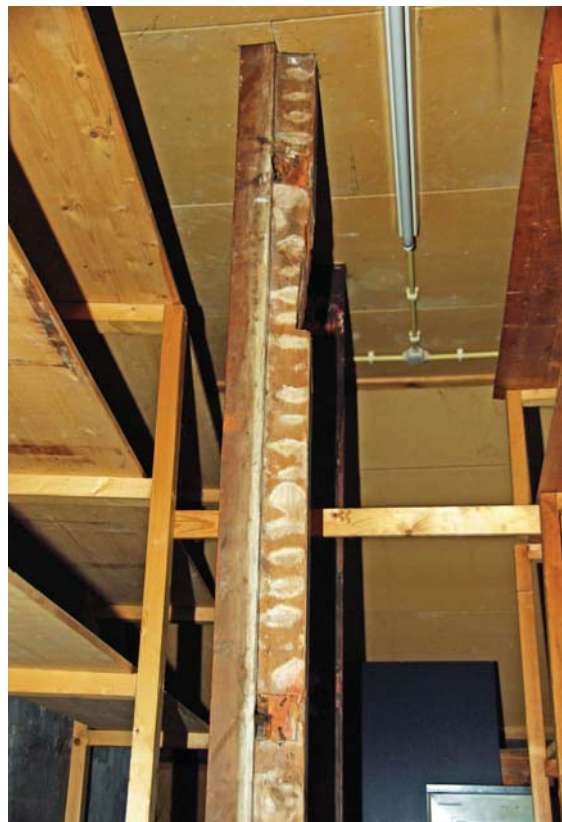
Afb. 160 Detail van de hoekbalken van het zuidelijke schoorsteenkanaal. Het muurwerk van de schoorsteen benedendaks is gesloopt. De sporen van de specie op het hout zijn nog zichtbaar.
