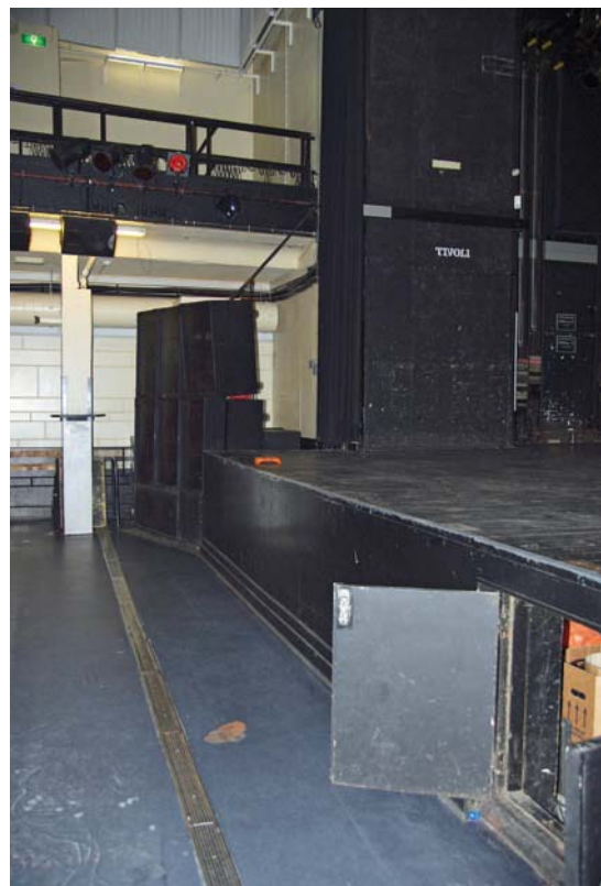
Afb. 66 Ruimte 0.21. Overgang zaal naar podium. Na 1980 is het podium iets in de zaal uitgebouwd. Oorspronkelijk liep de voorzijde gelijk aan de zijwanden.
