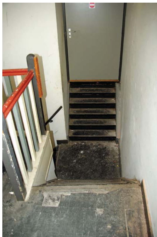
Afb. 80 Ruimte 3.07, verbindende trap naar de zolder van de kloostervleugel en de oude ruimten van de luchtbehandeling boven de Grote Zaal.
