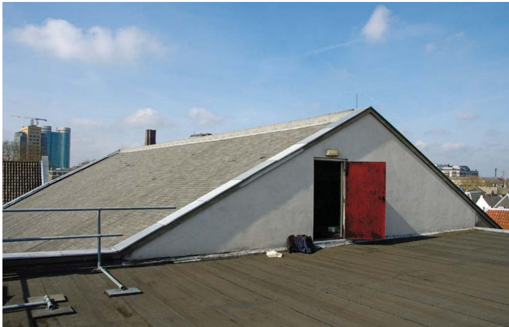
Afb. 49 Dak van de Grote Zaal in de vorm van een flauw hellend zadeldak tussen gepleisterde puntgevels. De dakvlakken zijn gedekt met asfaltshingels.
