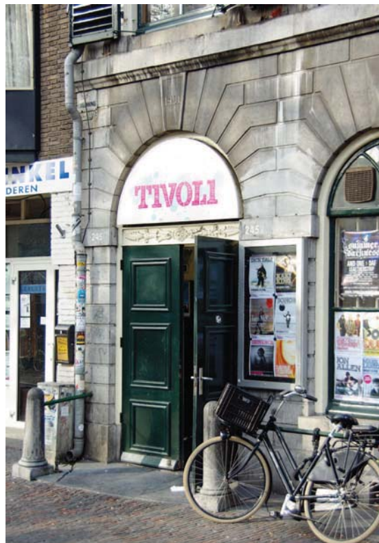
Afb. 42 Rechter ingang van het Weeshuis met boven de deur het opschrift 'TIVOLI'. Bij de regenpijp is nog het emaille bord zichtbaar met 'TAP-VER-GUNNING' en daaronder 'HET N.V.HUIS'. Het jaartal 1491 betreft de stichting van het Weeshuis.
