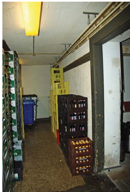
Afb. 86 Ruimte 0.32 met rechts de toegang tot ruimte 0.36, die in 1936 werd aangebouwd om wc's onder te brengen. Links achter de bierkatten bevindt zich de toegang tot de kelder van de kloostervleugel.
