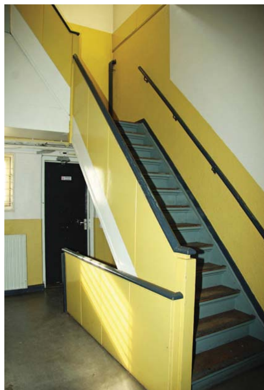
Afb. 144 Secundair trappenhuis in de westelijke vleugel (pandhof) van het Weeshuis (0.32/1.17). De deur geeft toegang tot de in 1951 aangebouwde uitbreiding van de kantoren.
