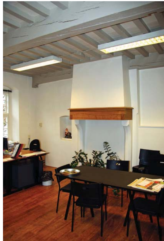
Afb. 123 Kamer (2.31) met (deels) gereconstrueerde schouw en samengestelde balklaag op de tweede verdieping aan de noordzijde van het Roghmuscaethuis. Het schoorsteenkanaal van de schouw in de hieronder gelegen kamer 0.48 loopt recht achter deze schouw.
