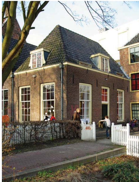
Afb. 58 Het meisjesvertrek, gebouwd in de achttiende eeuw en opgetrokken in kruisverband onder schilddak.
