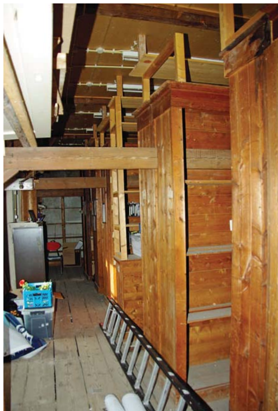
Afb. 158 Kapconstructie van het Weeshuisdeel aan de Oudegracht met in 1926 ingebouwde kastenstellingen. De middelste kast was oorspronkelijk lager en als aflegtafel in gebruik en bood tevens de mogelijkheid om de vlag uit te steken.
