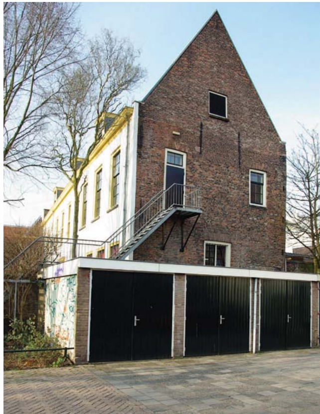
Afb. 56 Zuidelijke topgevel van de kloostervleugel met herbouwde top en later ingebroken vensters en vluchtdeur.
