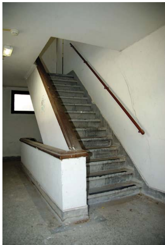
Afb. 78 Het in 1926 gebouwde noodtrappenhuis dat van de Grote Zaal via een tussenbalkon op de begane grond uitkomt.
