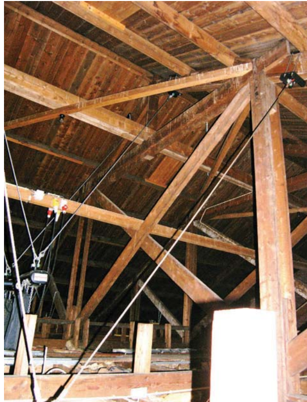
Afb. 81 Middendeel van de kap boven de Grote Zaal met een deel van een hangspant met twee hangers waartussen een verstijvingskruis is aangebracht.
