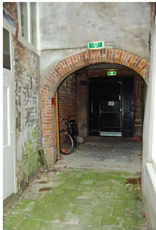
Afb. 39 Zakkendragerspoort, gezien vanuit de Zakkendragersgang richting Oudegracht.
