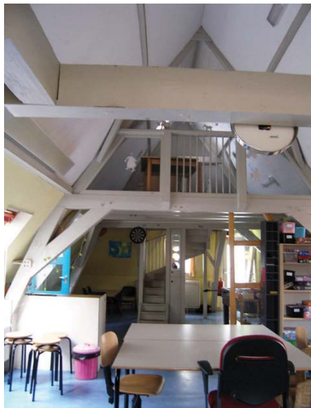
Afb. 129 Kapconstructie van het meisjesvertrek (2.26), gebouwd in de achttiende eeuw.
