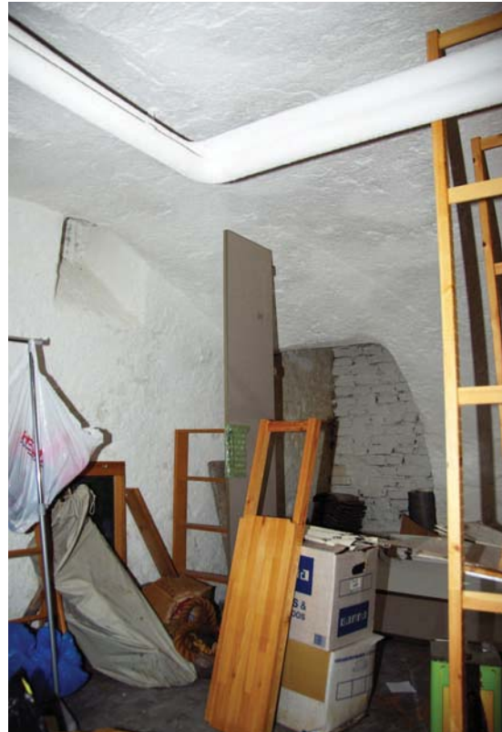
Afb. 113 Noordoostelijke hoek van de kelder van het Roghmuscaethuis (-1.07) met een dichtgezet kelderlicht aan de noordgevel en een dichtgezette toegang in de oostelijke wand.
