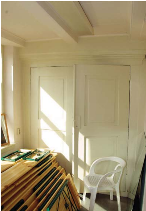
Afb. 106 Ruimte 2.22 in het uitgebouwde achttiende- eeuwse bouwdeel met ingebouwde kast.
