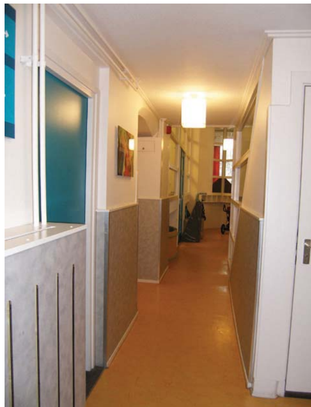
Afb. 119 Gang aan de oostzijde van het hoofdhuis (0.51) naar het zuiden. Rechts is de deur van de toegang tot de kelder zichtbaar.
