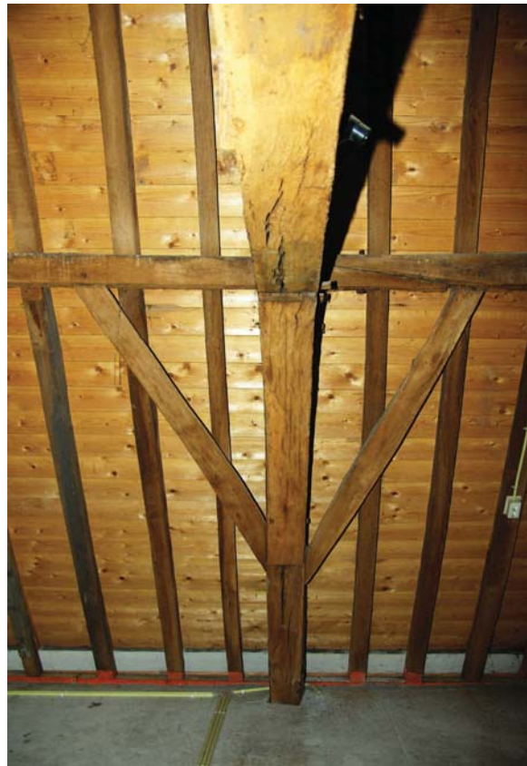
Afb. 130 Kapconstructie van het hoofdhuis, met zicht op één spantbeen, flieringen, sporen en windschoren. Het houtwerk is vijftiende-eeuws, het kapbeschoot recent.
