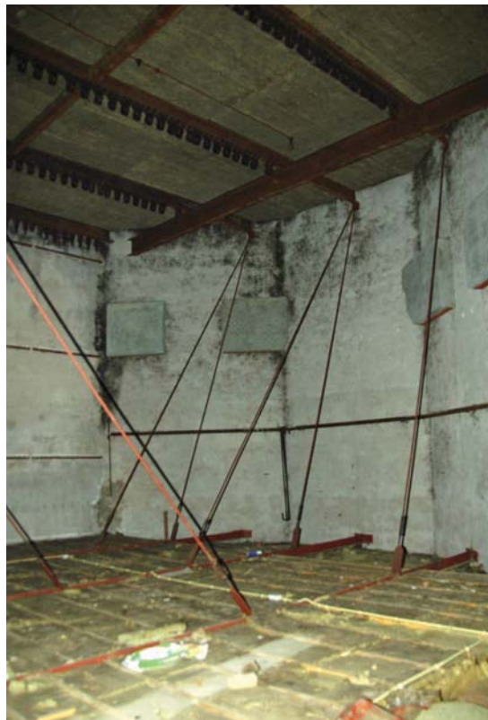
Afb. 76 Toneeltoren met afgeschuinde achterwand, dichtgezette vensters en katrollen van de trekkenwand.
