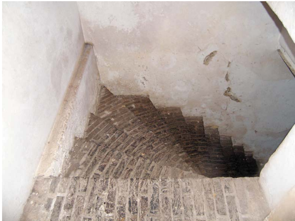
Afb. 89 Trap vanuit ruimte 0.32 naar de kelder in de kloostervleugel.
