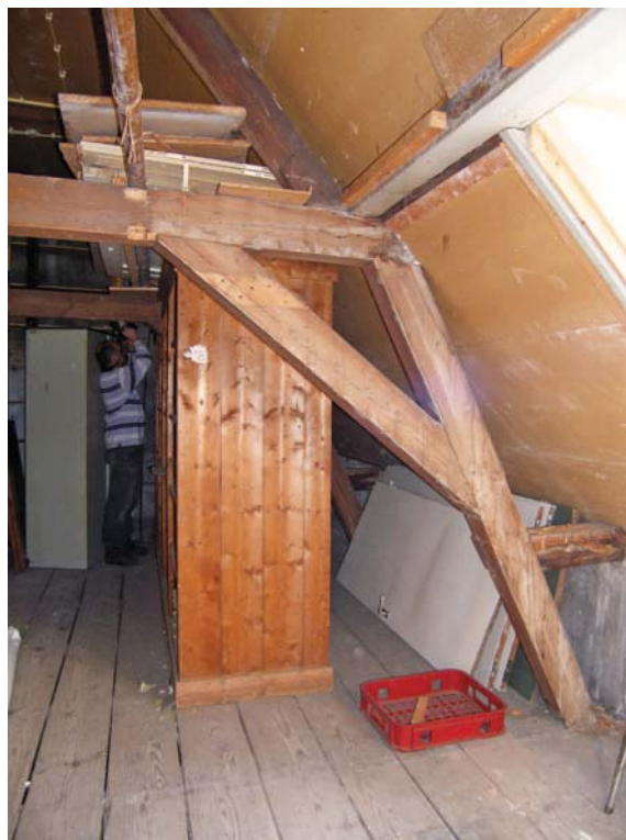
Afb. 157 Deel van de spantconstructie van de kap uit 1839.
