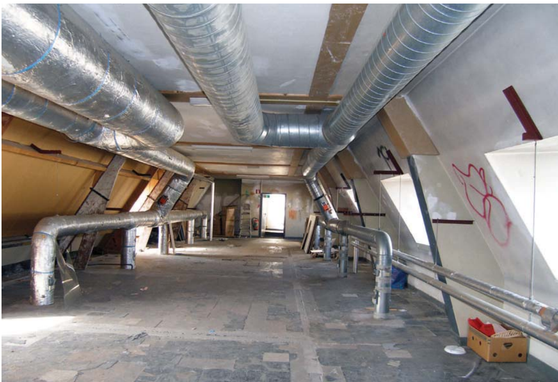
Afb. 107 De kap van de kloostervleugel naar het noorden. De kapconstructie dateert uit 1926. Op de vloer is de aftekening nog zichtbaar van de verdeling in kamers uit de jaren vijftig van de twintigste eeuw. Ook de coloviny vloertegels dateren uit die periode.
