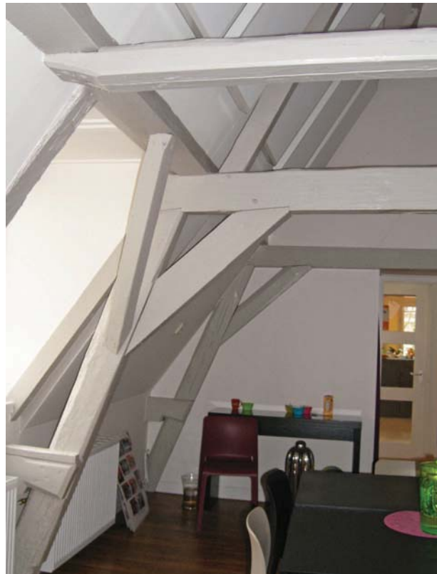
Afb. 128 Kapconstructie van het deel dat ooit als bakkerij in gebruik was. Ruimte 2.28 gezien naar het westen. De kapconstructie met tussenhangbalken kan mogelijk nog uit de zeventiende eeuw dateren.
