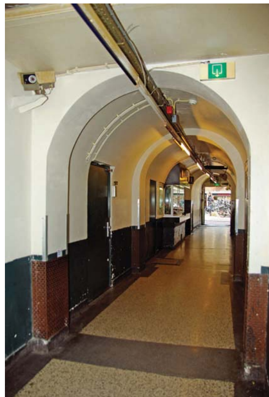
Afb. 84 Voorste deel van de lange gang (0.01), oorspronkelijk het zuidelijke pandhof, richting de Oudegracht met een overwelfing in de vorm van een tongewelf.
