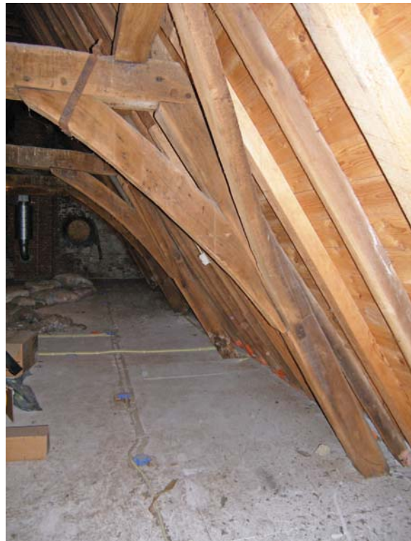
Afb. 131 Detail van één van de vijftiende-eeuwse spantbenen van de kapconstructie van het hoofdhuis.
