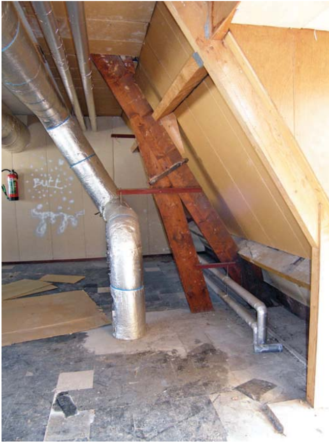
Afb. 108 Detail van de kapvoet van één van de spanten in de kap van de kloostervleugel.
