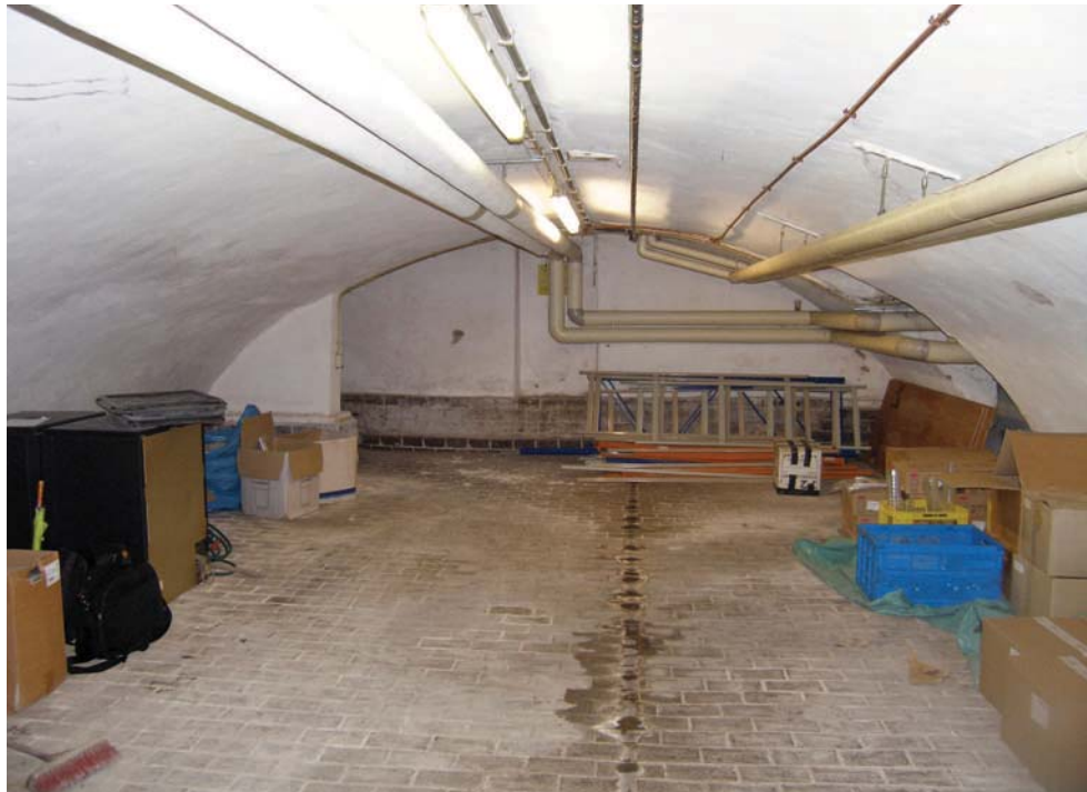
Afb. 91 Zuidelijk deel van de kelder onder de kloostervleugel (-1.02) naar het zuiden met daarin de sporen van een dichtgezette toegang.
