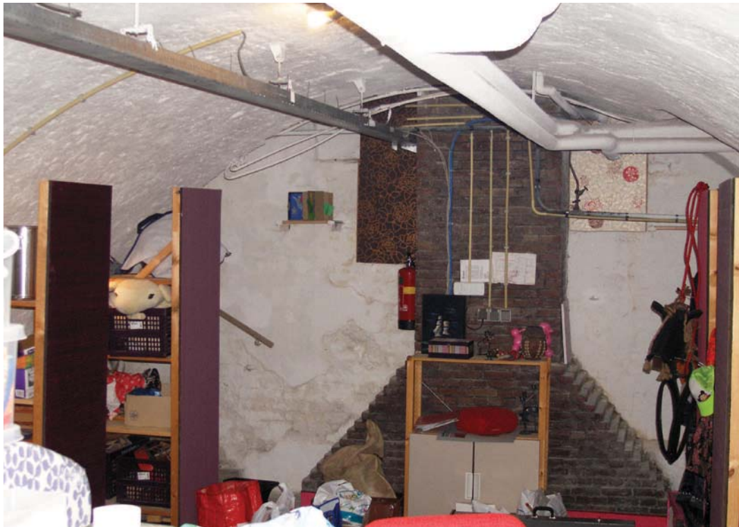
Afb. 111 Kelder van het Roghmuscaethuis (-1.06) naar het zuiden met zichtbaar de versneden voet en opgaand werk van de schoorsteen.
