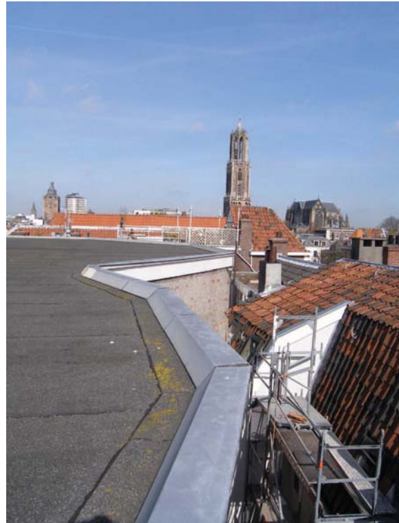
Afb. 50 Platte dak van de koorsluiting, gezien richting de Dom (noordoosten).
