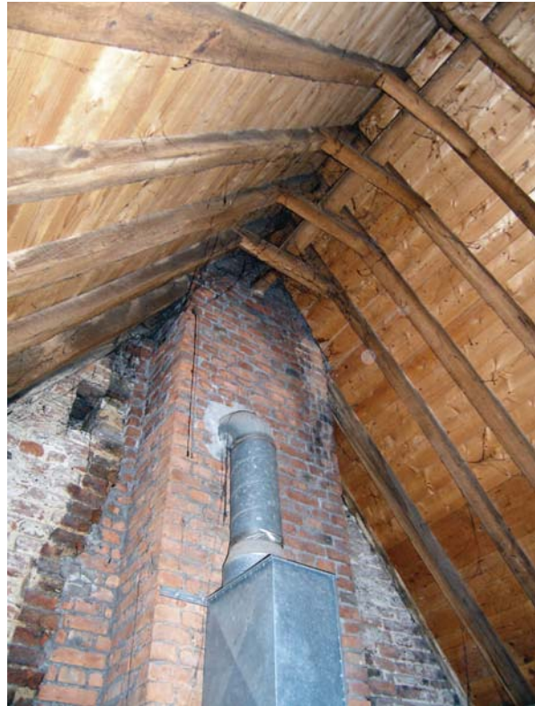
Afb. 132 Detail van de zuidelijke topgevel met een recent schoorsteenkanaal ten behoeve van de centrale verwarming.. De haanhouten van de buitenste zes sporenparen aan beide zijden zijn gekoppeld door een balk.
