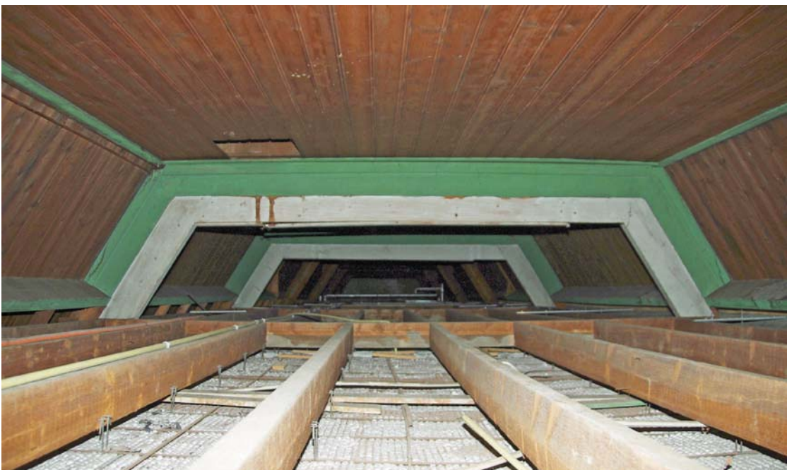
Afb. 109 Blik boven het verlaagde plafond waar een aftimmering van schroten zichtbaar is van de verbouwing uit 1926.
