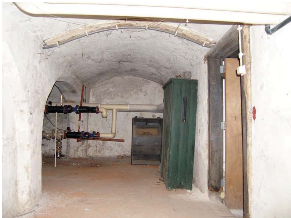
Afb. 92 Noordelijk deel van de kelder onder de kloostervleugel (-1.03) naar het oosten met zichtbaar het segmentgewelf aan de linkerzijde, rustend op een gordelboog die overgaat in een kolom.
