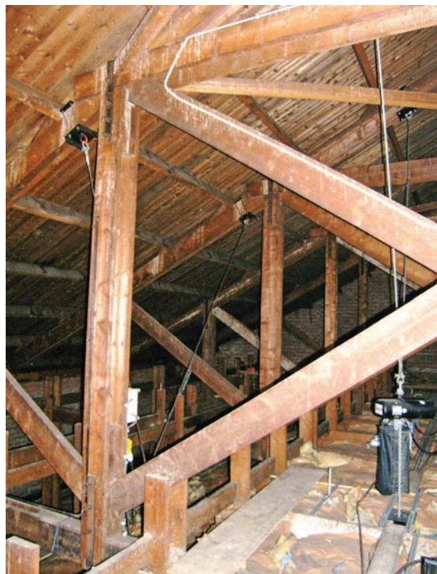
Afb. 82 Zuidelijk zijdeel van de kap boven de Grote Zaal met op de beide knooppunten van de hanger een ijzeren beugel met daarin bouten geborgd door moeren.
