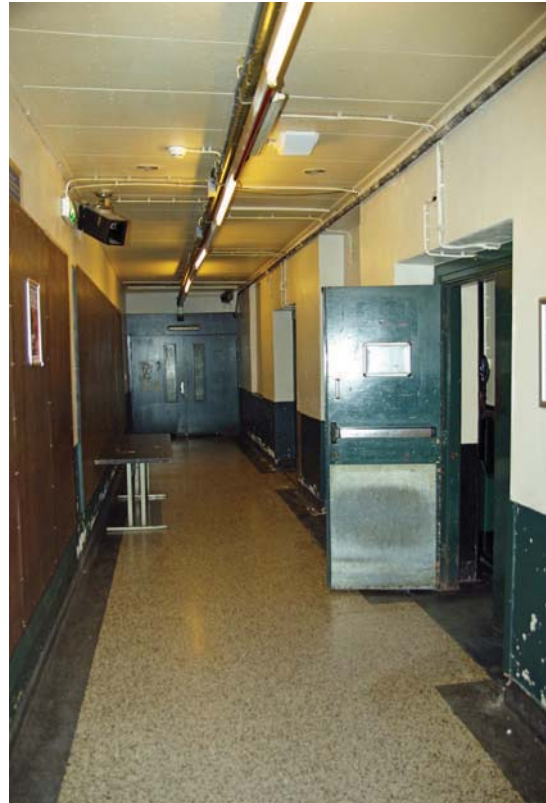
Afb. 85 Achterste deel van de lange gang (0.01) richting het westen. De vlakke afdekking met gipsplaten is recent aangebracht.
