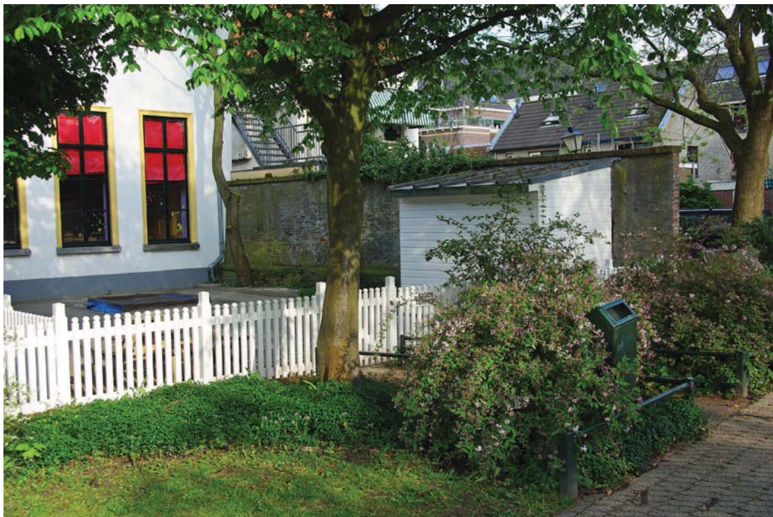
Afb. 55 De grotendeels opnieuw opgetrokken tuinmuur op de plaats waar zich vroeger de keukenvleugel bevond.
