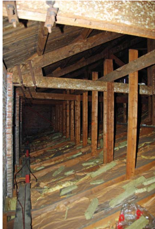
Afb. 83 Overgang van de hangspanten van de Grote Zaal op het muurwerk.
