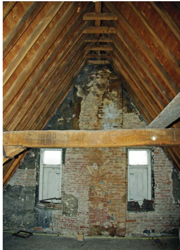
Afb. 133 De topgevel aan de noordzijde met schoorsteenkanaal geflankeerd door twee kloostervensters.
