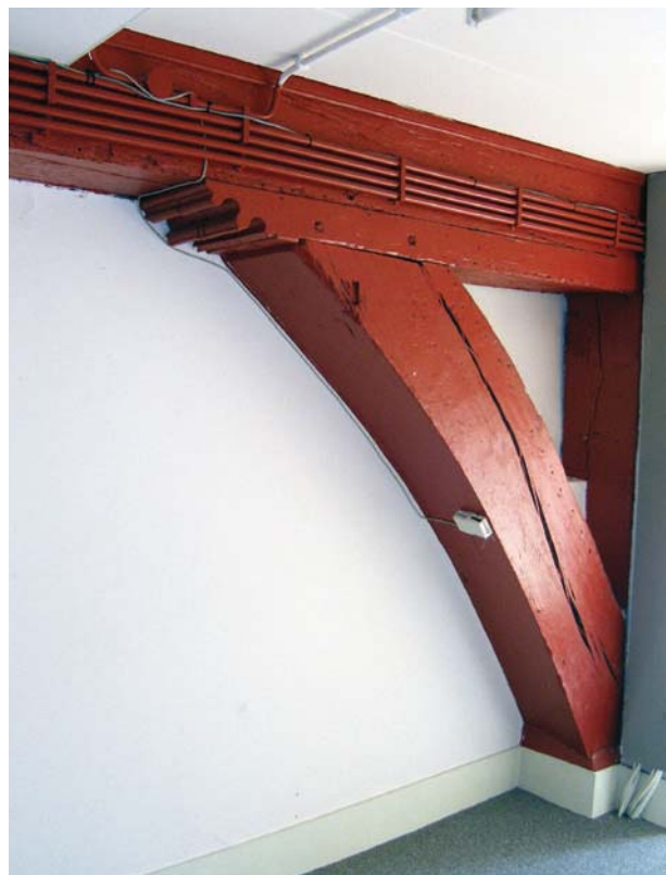
Afb. 101 Ruimte 1.20 met het rechterdeel van het enige overgebleven korbelsel van de kloostervleugel.
