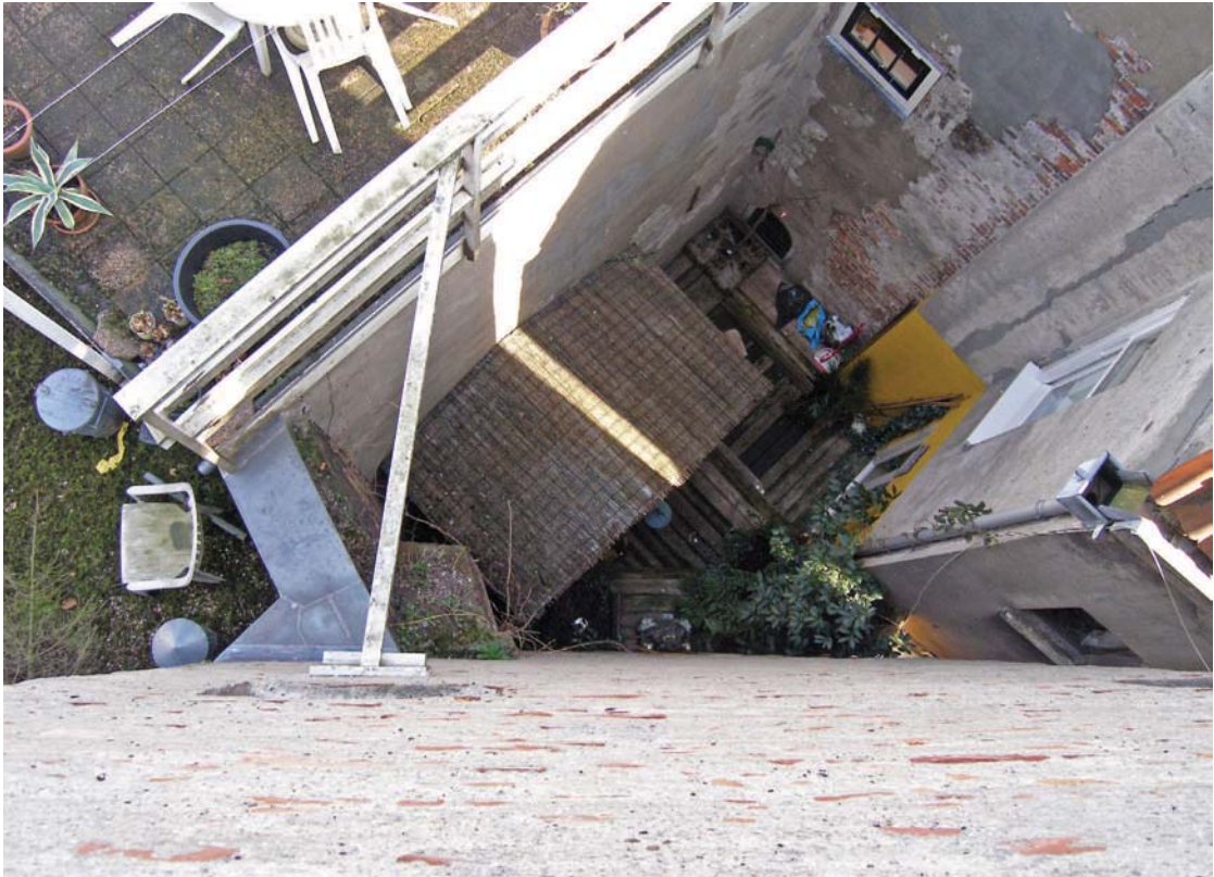
Afb. 52 Tuintje tussen de koorsluiting en Oude Gracht 239 met eveneens een deel van een oorspronkelijk steunbeer zichtbaar.
