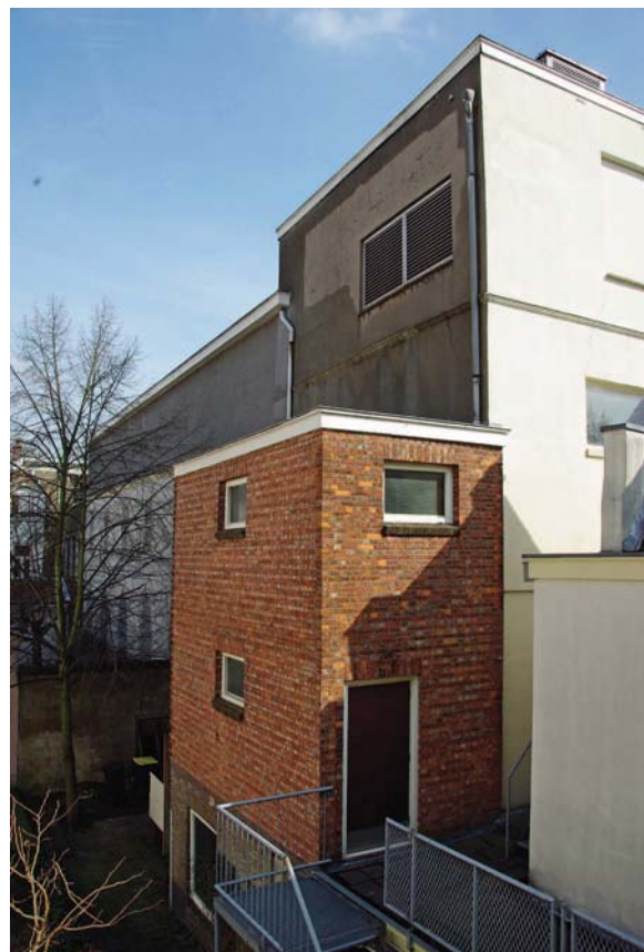
Afb. 47 Westzijde van de Grote Zaal met een drielaagse aanbouw achter het noodtrappenhuis. Gezien de waterlijst zal de derde bouwlaag in 1926 zijn toegevoegd.
