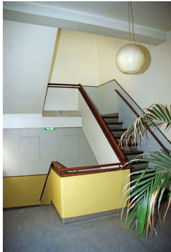
Afb. 143 Trap van de eerste naar de tweede verdieping in het trappenhuis uit 1939 (1.11).
