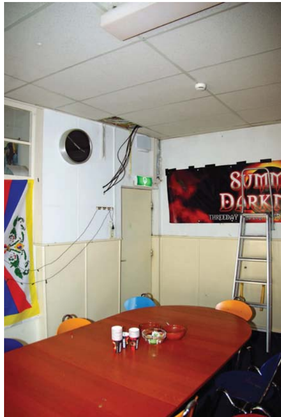
Afb. 145 Ruimte 1.06, aangebouwd in 1951 boven- op de voormalige werkplaats van de jongens.
