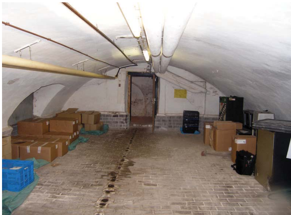
Afb. 90 Zuidelijk deel van de kelder onder de kloostervleugel (-1.02) naar het noorden.
