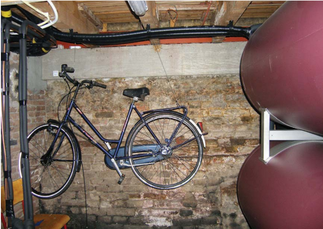
Afb. 73 Deel van de noordmuur van de oorspronkelijke koorsluiting, met rechts de biertanks.
