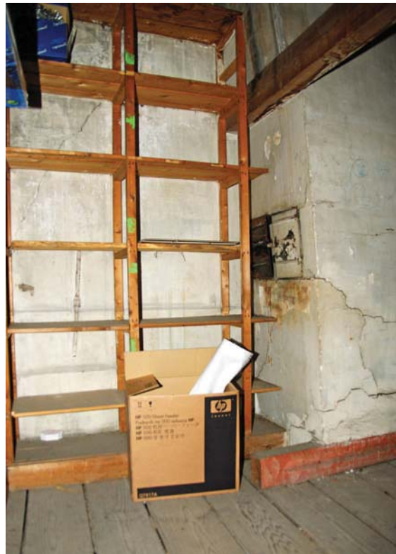
Afb. 159 De noordgevel in de kap, met achter de stelling een muuranker zichtbaar van het pand Oudegracht 243. Rechts de noordelijke schoorsteen van het Weeshuisdeel.
