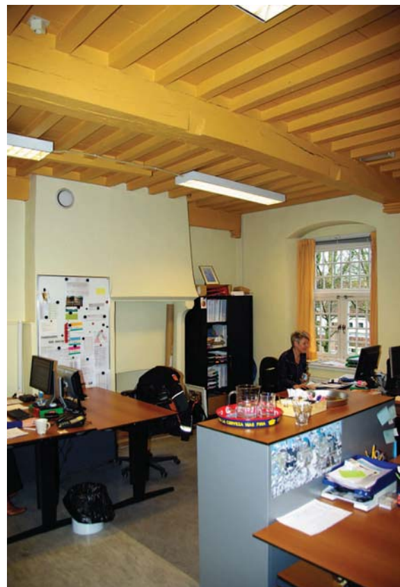
Afb. 126 Kamer (2.29) met schouw en samengestelde balklaag op de tweede verdieping aan de zuidzijde van het Roghmuscaethuis. Naast de schouw met slechts één 'schouwwang' is het schoorsteenkanaal van de schouw beneden (niet meer aanwezig) zichtbaar.
