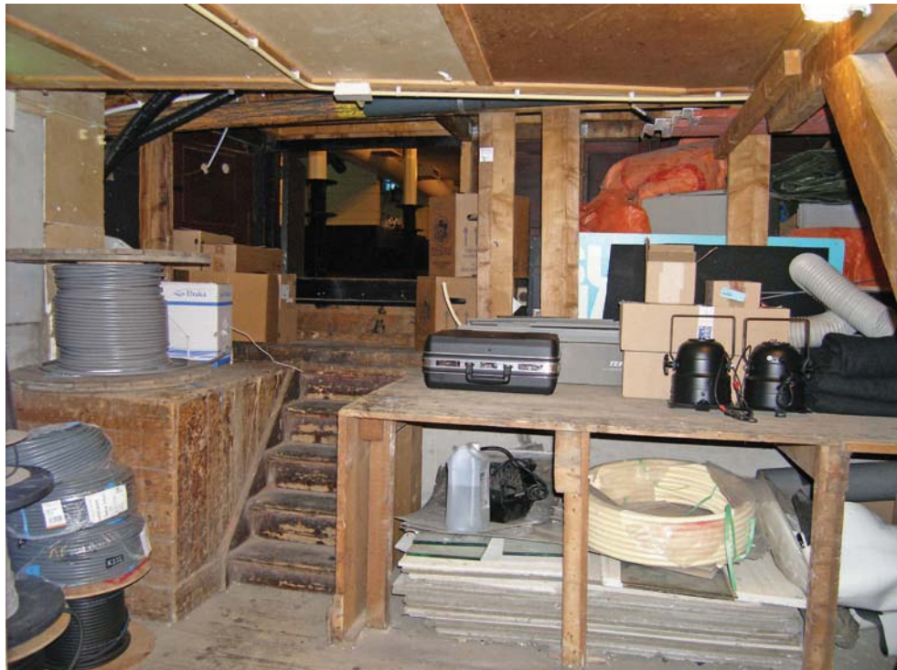
Afb. 68 p323006 Ruimte onder het voorpodium (0.22) met trapje van de orkestbak naar de zaal. De voorzijde van het podium was bij orkestuitvoeringen open en kon mogelijk ook met luiken dicht gemaakt worden.
