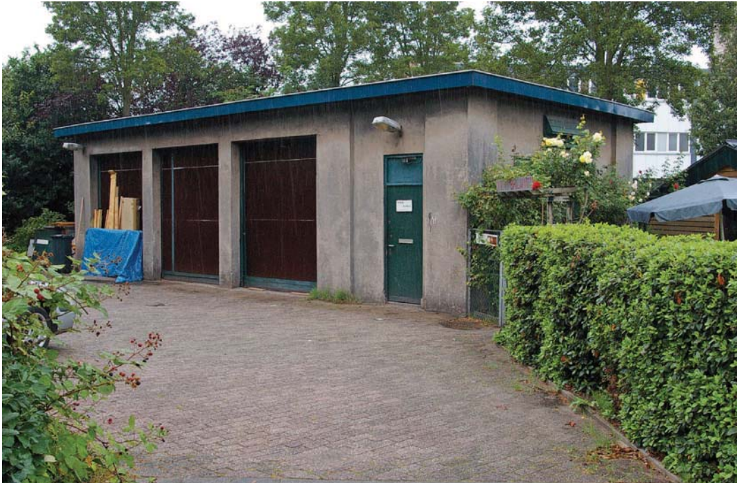
Afb. 44 Garage met drie garageboxen op het terrein van de voormalige Wasserij Staatsen, gebouwd eind jaren twintig van de vorige eeuw. Het is een bakstenen gebouw, afgewerkt met cementpleister.
