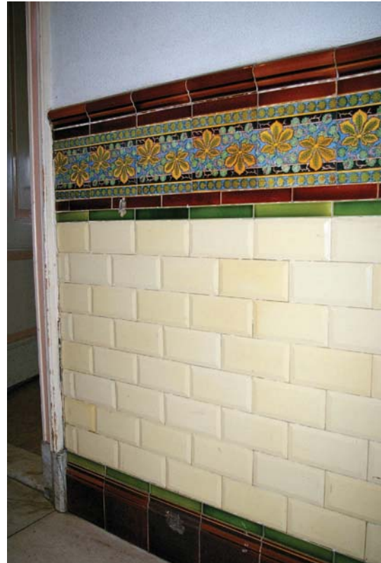
Afb. 33 Directeurswoning van Wasserij Staatsen. Interieur van de gang met detail van de tegellambrisering uit de bouwtijd, bestaande uit een plint van bruin geglazuurde tegels, rechthoekige crèmekleurige facettegels bekroond door een fries met het motief van een kastanjeblad met bolsters.
