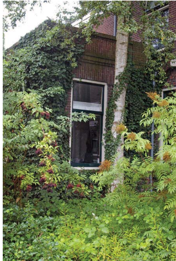
Afb. 30 Directeurswoning van Wasserij Staatsen. De aanbouw tegen de noordgevel is bij een verbouwing eind jaren twintig van de vorige eeuw tot stand gekomen. Karakteristiek voor die tijd is het decoratieve metselwerk van de bekroning.
