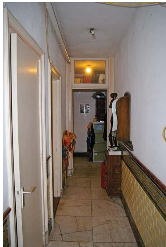
Afb. 34 Directeurswoning van Wasserij Staatsen. Interieur van de gang met tegellambrisering en marmeren plavuizen vloer gezien in oostelijke richting. De oorspronkelijke deurkozijnen in de gang staan op marmeren neuten. De moderne deur links op de voorgrond is een kastdeur, geplaatst in het kozijn van een voormalige doorgang naar een van de kamers links van de gang (hier bevindt zich thans de keuken). Aan het eind van de gang bevindt zich het restant van een tochtdeur vlak voor de trap naar boven.
