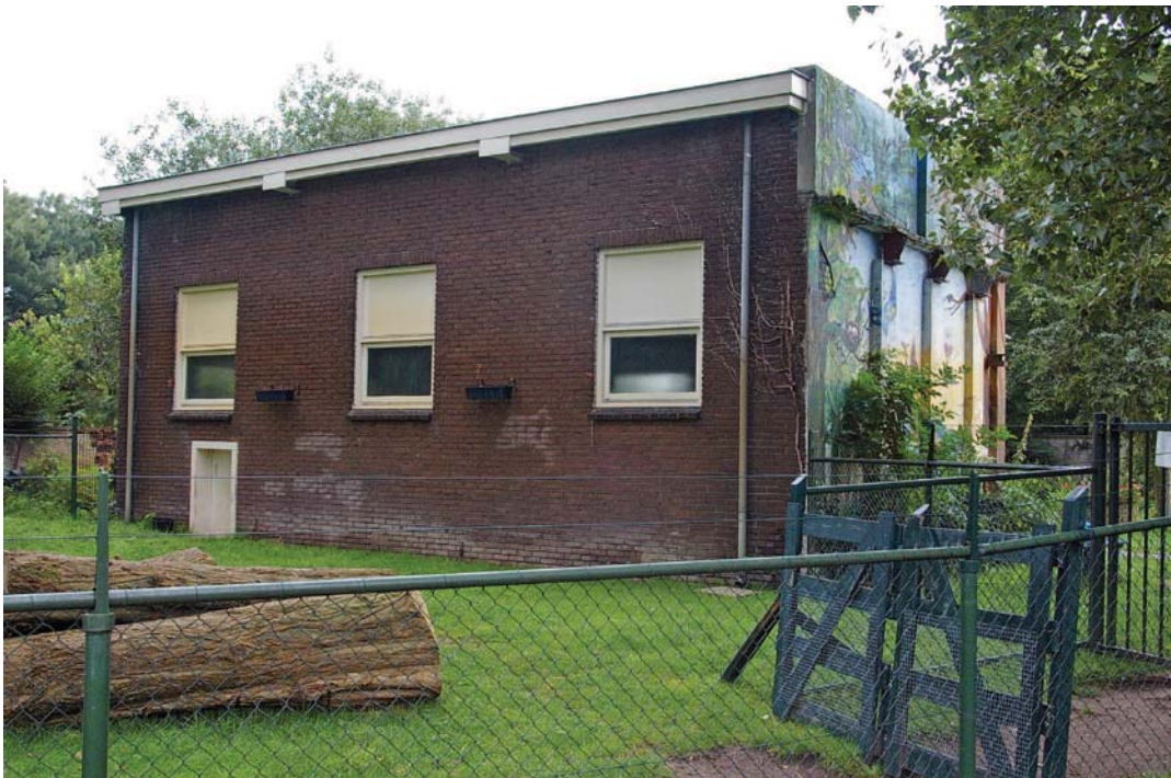
Afb. 45 Wasserijgebouw aan de oostzijde van het terrein van de voormalige Wasserij Staatsen gezien vanuit het noordoosten. De bakstenen loods uit circa 1950 sloot aan de noordzijde aan op een thans afgebroken bouwdeel. De uiteinden van de stalen liggers van de constructie van dit gesloopte bouwdeel zijn als kapitelen op de pilasters gehandhaafd.
