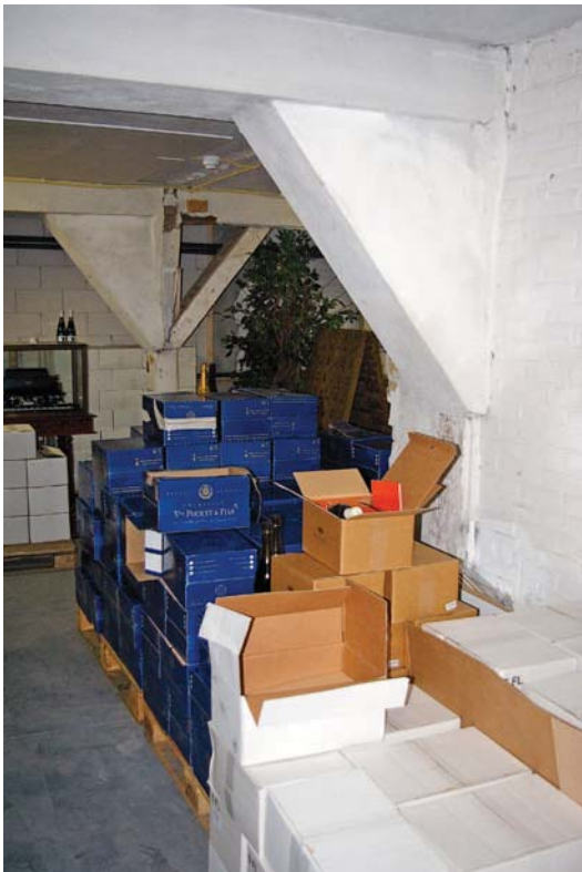
Afb. 21 Het gebouw Ondix (Rotsoord 13). Interieur van de begane grond van het voormalige fouragemagazijn. In de jaren zestig zijn de houten kolommen (standvinken) en balken van de constructie omtimmerd, zijn scheidingsmuren geplaatst en zijn de plafonds met cementpleister afgewerkt. De standvinken staan op gemetselde poeren.
