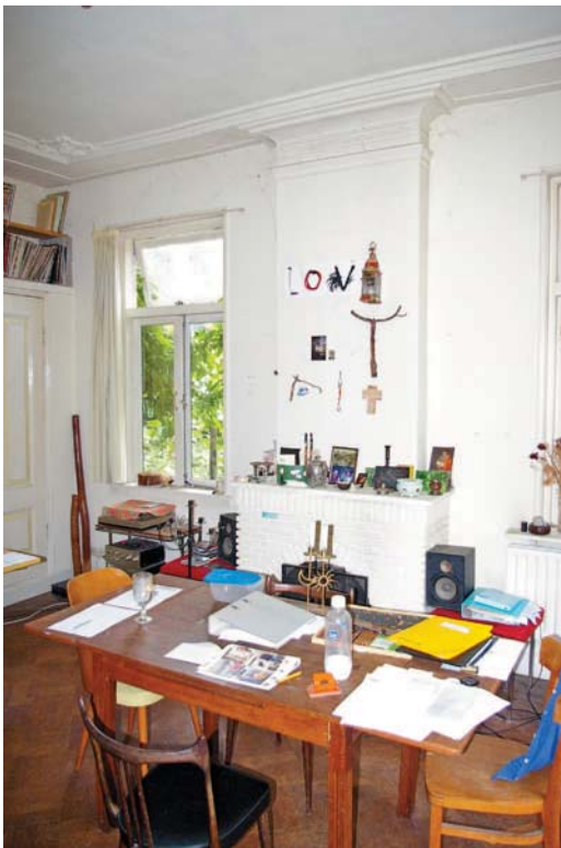
Afb. 38 Directeurswoning van Wasselij Staatsen. Interieur van de voorkamer, voorheen kantoor (deel van kamers en suite) met decoratief stucwerkplafond en parketvloer uit de bouwtijd. De originele stookplaats tegen de zuidgevel is gemoderniseerd. Ook de flankerende vensters zijn later toegevoegd.
