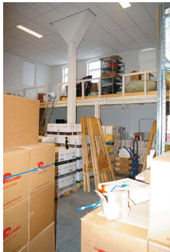
Afb. 25 Het gebouw Ondix (Rotsoord 13). Interieur van het tweelaags hoge magazijn links van de hal, waarmee het oorspronkelijk in open verbinding stond. De houten kolommen (standvinken) zijn ook hier omtimmerd. Het systeemplafond is recent aangebracht.
