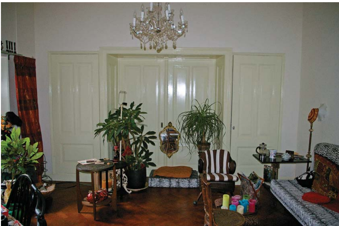
Afb. 36 Directeurswoning van Wasserij Staatsen. Interieur van de achterkamer voorheen woonkamer (deel van de kamers en suite) met kastenwand en paneelschuifdeuren uit de bouwtijd.
