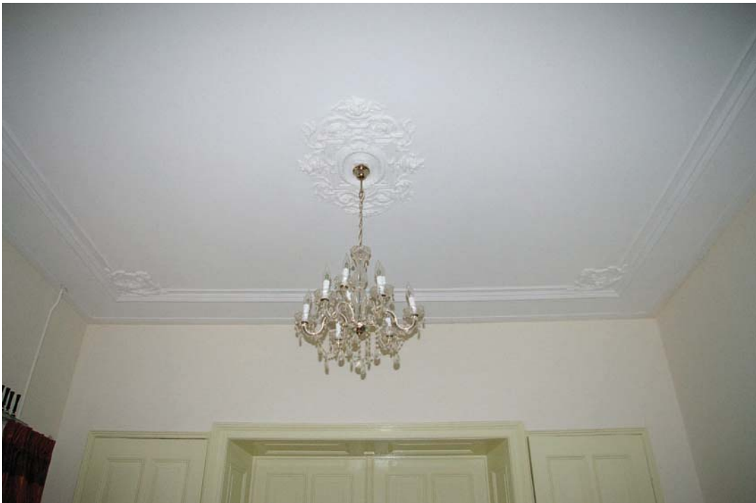
Afb. 35 Directeurswoning van Wasserij Staatsen. Interieur van de achterkamer met stucwerk plafond uit de bouwtijd voorzien van perklijst en decoratieve hoek- en middenrozetten.
