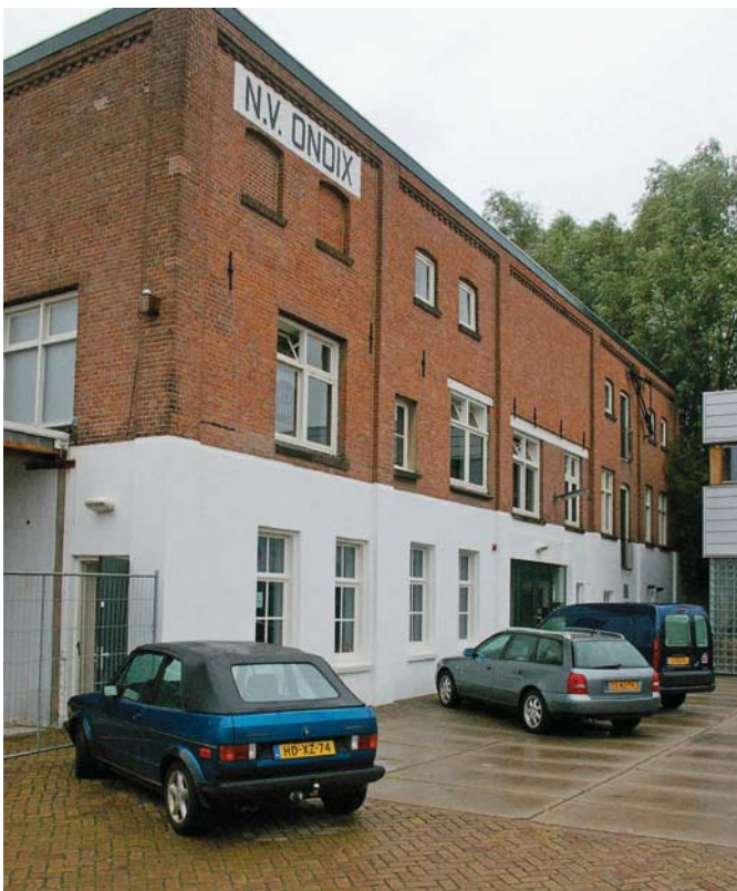
Afb. 18 Het gebouw Ondix (Rotsoord 13) gezien vanuit het zuidoosten met zicht op de voorgevel. Veel van de oorspronkelijke licht getoogde vensters met gietijzeren ramen zijn vervangen door grotere, samengestelde houten ramen. De vensters met zesruits ramen op de begane grond zijn recent als vervanging van (evenmin oorspronkelijke) garagedeuren aangebracht. Links boven op de gevel staat N.V. Ondix vermeld.
