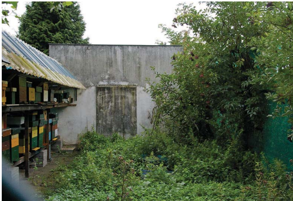
Afb. 47 Restant van een voormalig garagegebouw aan de noordzijde van het wasserijterrein, waarlangs oorspronkelijk de sloot liep waarop de wasserij loosde. In de oostgevel is de aftekening zichtbaar van een brede getoogde ingang. Aan de westzijde is het gebouw met een moderne aanbouw verlengd. Oorspronkelijk was het gebouw voorzien van een zadeldak.
