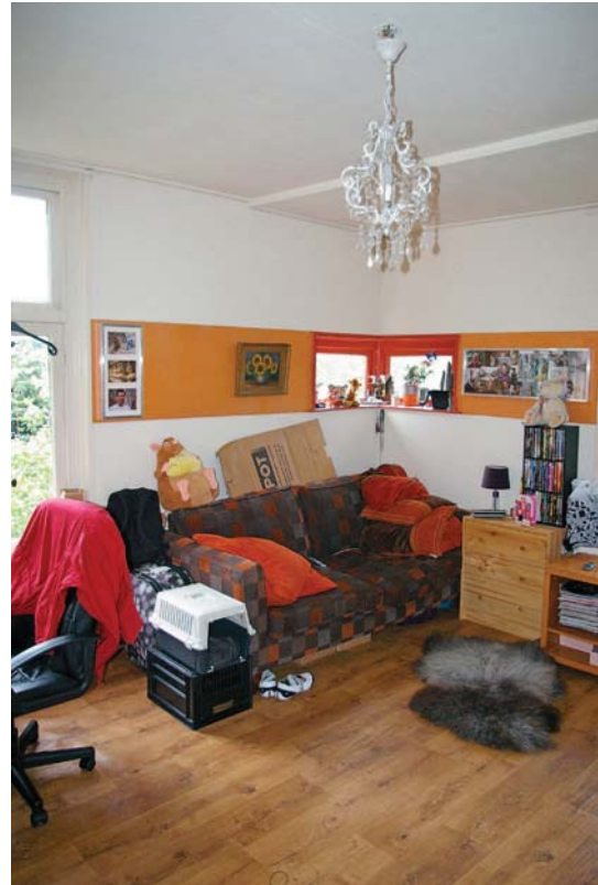
Afb. 42 6209 Directeurswoning van Wasserij Staatsen. Interieur van de voorkamer op de verdieping aan de noordwestzijde met het opvallende hoekvenster. In het plafond is zichtbaar dat het verlengd is. Aanvankelijk liep de kap hier schuin af.
