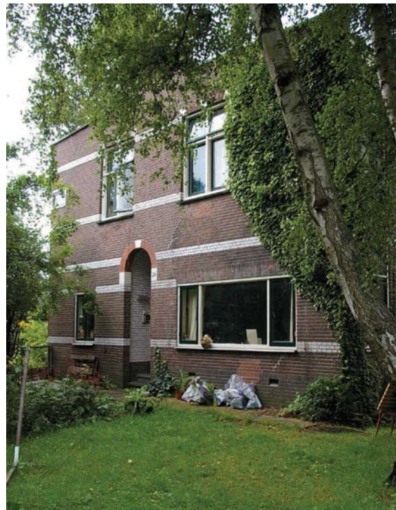
Afb. 31 Directeurswoning van Wasserij Staatsen gezien vanuit het zuidwesten. De voorgevel (westzijde) bevat iets links van het midden een inpandig portiek met de ingang. De vensters op de begane grond zijn gewijzigd. Oorspronkelijk waren er links één en rechts van de ingang twee vensters, waarschijnlijk voorzien van schuiframen, onder een boogveld met decoratief metselwerk zoals thans nog in de noordgevel te zien is. Sporen van de oude toestand zijn in het metselwerk zichtbaar.
