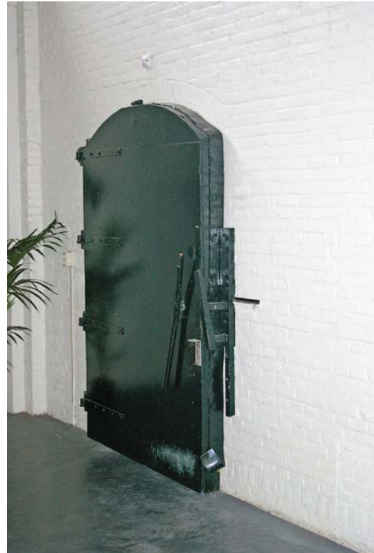
Afb. 24 Het gebouw Ondix (Rotsoord 13). Interieur van de grote middenhal met een zwaar uitgevoerde magazijndeur uit de bouwtijd in de rechter zijmuur.
