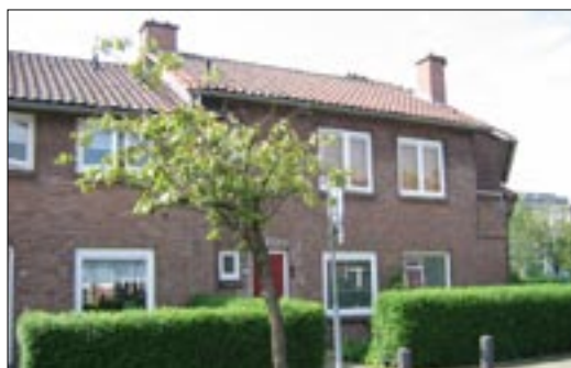
Polderstraat, de fraaie hoekoplossing.
