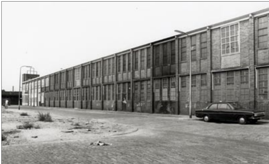
Gezicht op de voorgevel van de batterijenfabriek Herberhold aan de Balkstraat, vanaf de hoek van de Houtstraat.
