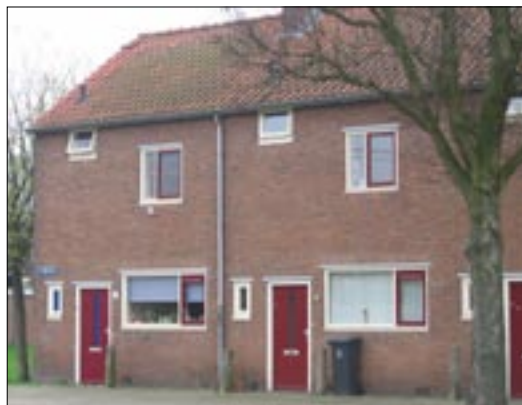
Linkerkolom: Voormalige winkelruimtes op de hoek Van der Steenstraat / Verheulstraat.
