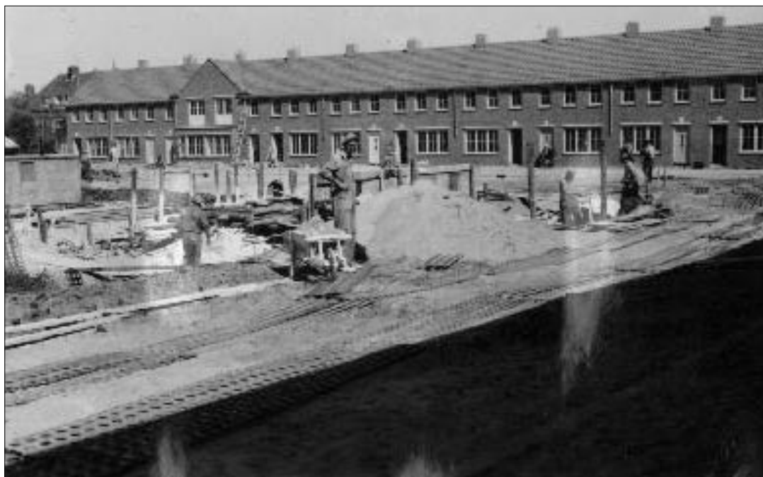
Gezicht op de in aanbouw zijnde huizen aan de Vijgeboomstraat.
