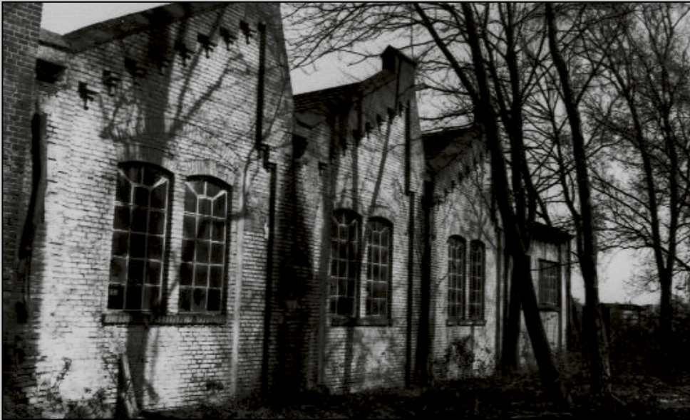
Bijschrift foto: De schuine daken zijn de z.g. sheddaken. Door de lichtinval is dit een unieke locatie voor het horecagedeelte. foto: Guus Wentink
