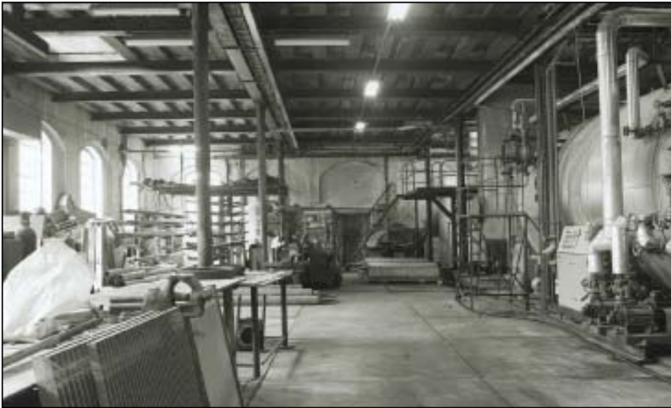
23. Interieur van het eenlaags fabrieksgebouw uit 1908, 2002. (Bron: HUA)
