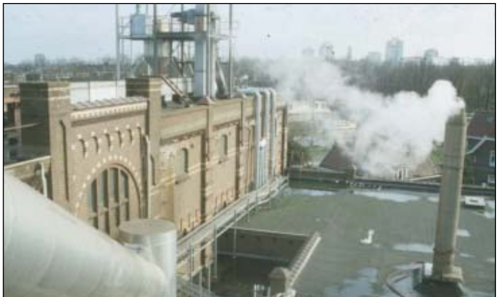
28. (links) De zijgevels aan het binnenterrein zijn deels nog intact, 2002. (Bron: HUA)
