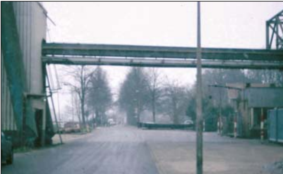
13. Het Merwedekanaal ter hoogte van Cereol met het overkluiste voorterrein, 2001.
