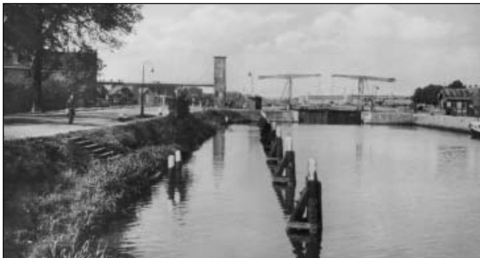
6. Merwedekanaal circa 1935 met zicht op het sluizencomplex en links de SOL met de transportbaan en de zuiginstallatie (Bron: HUA)
