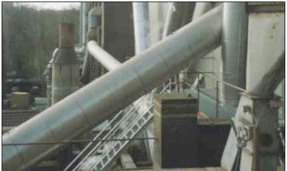
33. De (veelal) milieu- maatregelen hebben het gebouw ook een eigen karakter gegeven, 2002. (Bron: ABC)
