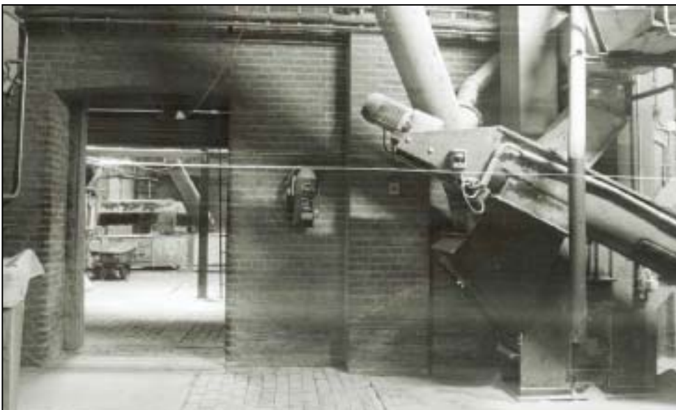
25. De interne overgang van het pakhuis uit 1908 naar het gebouw uit 1909. (Bron: HUA)
