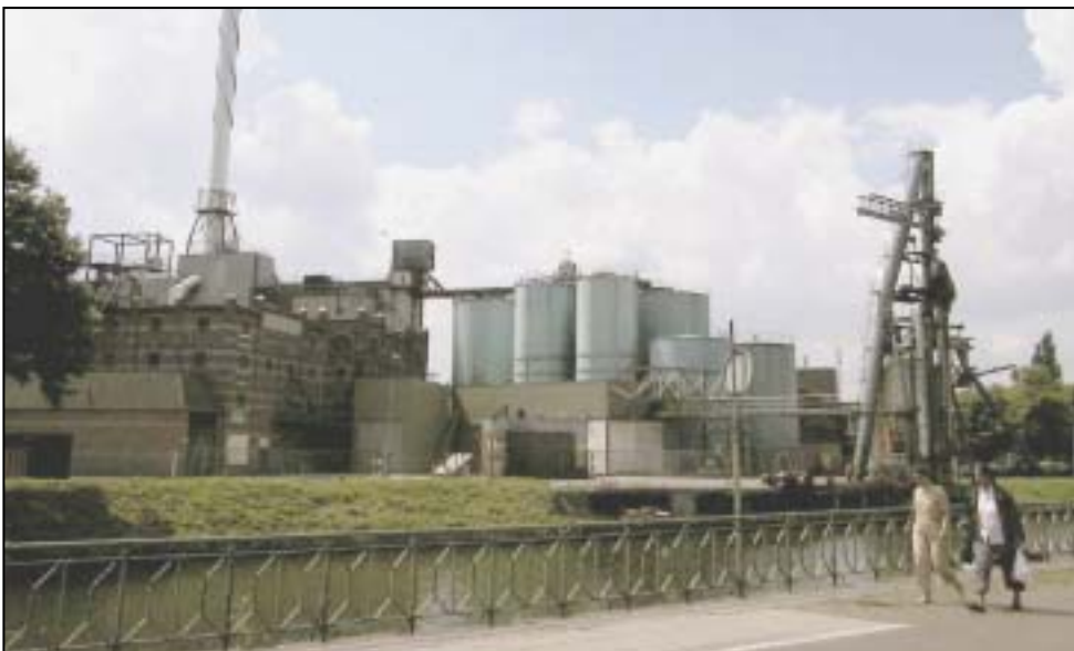
37. Gezicht op de fabriek vanaf het sluisencomplex. (Bron: ABC)
