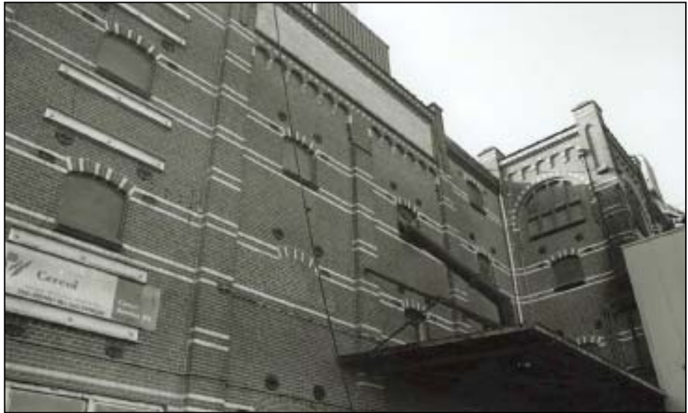
26. (links) De karakteristieke architectuur van de fabrieksgebouwen uit 1908-1909. (Bron: HUA)
