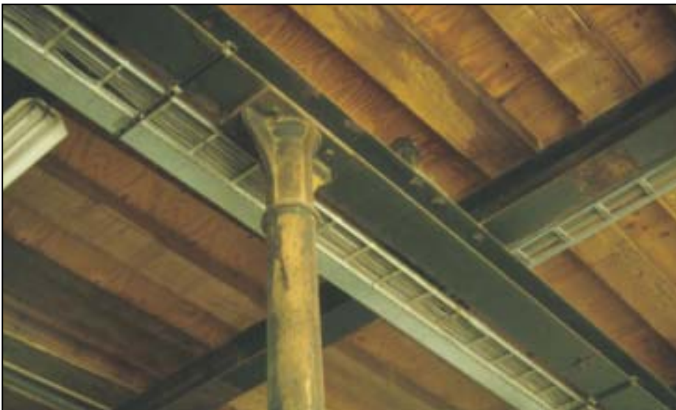
24. Detail van de draagconstructie in het eenlaags gebouw, 2002. (Bron: ABC)
