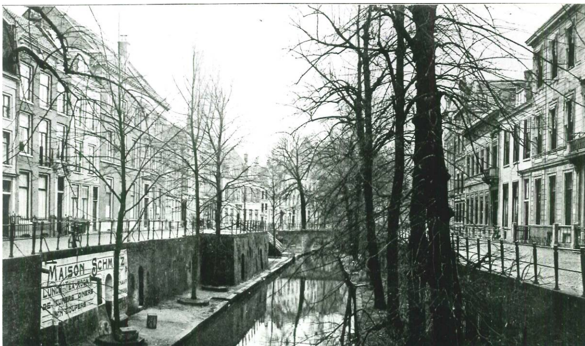
37. Uit de 19e en 20e eeuw zijn diverse voorbeelden bekend van bij het planten van nieuwe bomen toegepaste verhoogde boomkransen in de vorm van (tijdelijke) achthoekige houten bakken, om de bomen betere groeimogelijkheden mee te geven. Na het vergaan van zo'n houten omranding bleef een verhoogde standplaats over, met een groter volume. Deze methode werd tot de 2e wereldoorlog toegepast. Voorbeeld bij Nieuwegracht 41, 1920.
