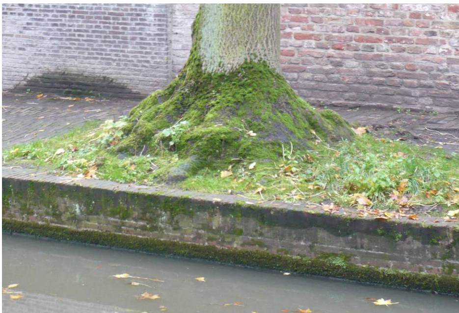
50, 51, 52. Rond 1900 werden dikwijls verhoogde boomkransen met houten randen toegepast om bomen extra doorwortelbaar volume mee te geven. Later bleef hiervan vaak een verhoogde standplaats over.
