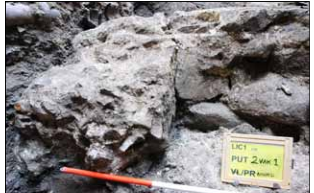
Afb. 2.6 Het bisschoppelijk paleis; duidelijk verschil in de structuur van funderingen B (rechts) en C (links), foto naar het noorden.
