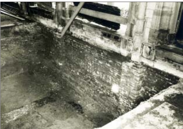
Fig. 2.58 Op dezelfde hoogte als Fig. 2.57 zijn enkele van de funderingen van gebouw 5 in wp 4 te zien (foto 10, vanuit ZW, L. Biegstraaten ROB).
