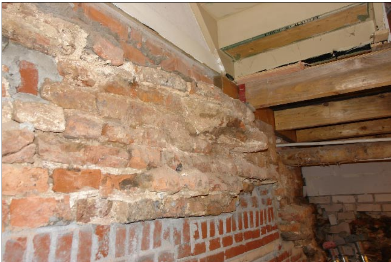
Afb. 4.16 De fundering van de achtergevel met een deels afgehakte verzwareing die aan één zijde een rond verloop vertoont en mogelijk in verband gebracht kan worden met een spiltrap.
