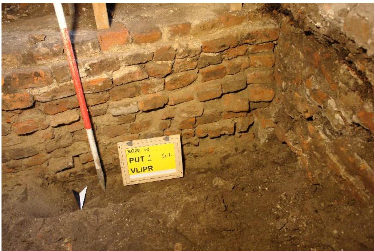
Afb. 4.2 De fundering (spoor 1) en de westelijke gevel (detail), vanuit het noorden gezien.
