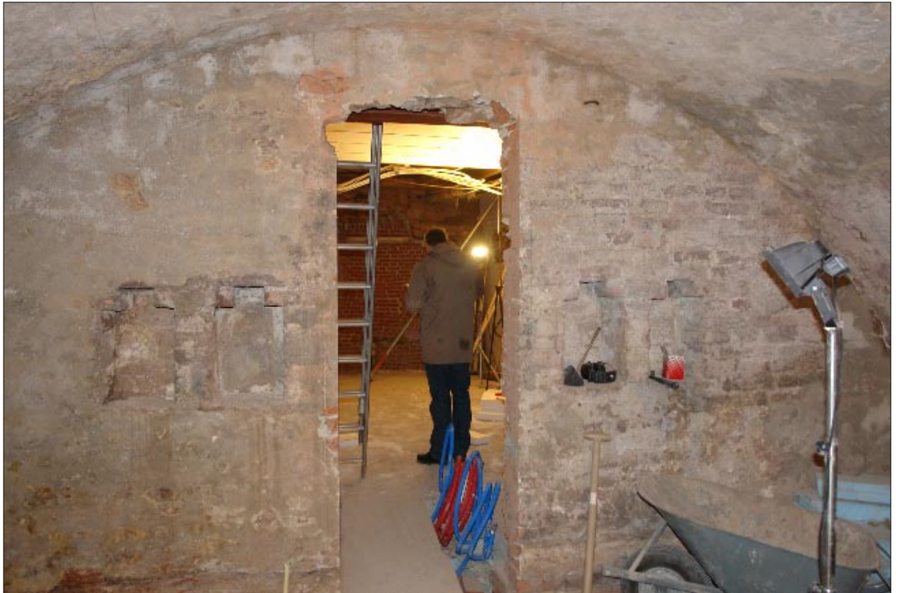
Afb. 4.13 De achtergevel van de noordelijke werkelder met vier kaarsnissen. De deuropening in het midden is recent aangebracht om de nieuwe kelderruimte te verbinden met de werkelder.
