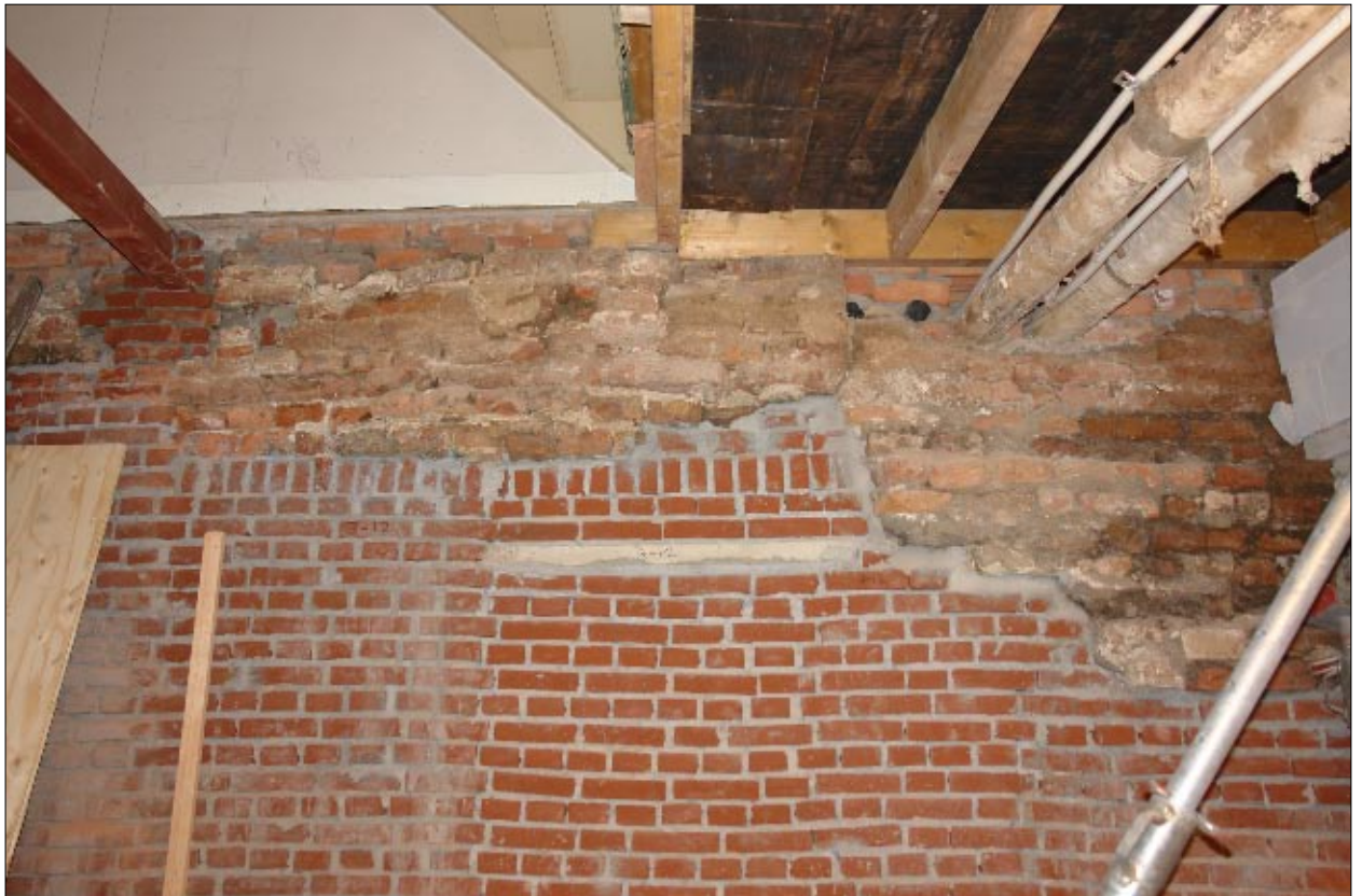
Afb. 4.14 Aansluiting van de gangmuur op de oostelijke gevel.
