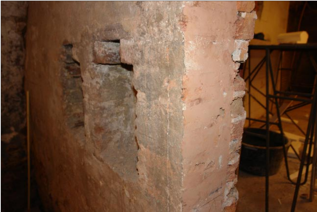
Afb. 4.12 De achtergevel van de noordelijke werfkelder vanuit het noordoosten gezien.
