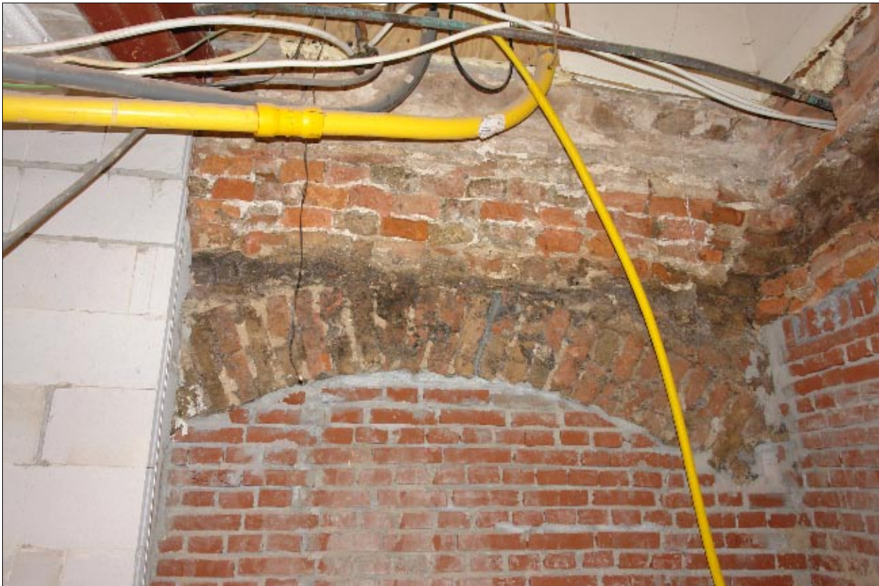
Afb. 4.15 De funderingsboog in de noordelijke zijgevel.
