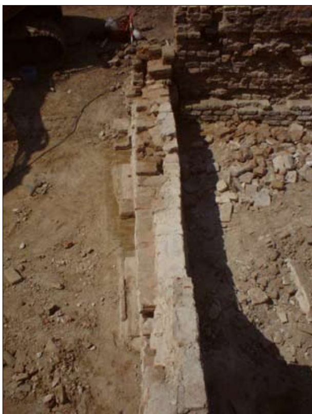
5.28 Scheidingsmuur tussen gebouwen C en D in de zeventiende eeuw (gezien van oost naar west). De linkerzijde wordt gevormd door de oude vijftiende-eeuwse, in leem gemetselde fundering van gebouw C. De rechterhelft, in witte kalkmortel gemetseld, werd bij de aanleg van de kelders in gebouw D rond 1646 toegevoegd.
