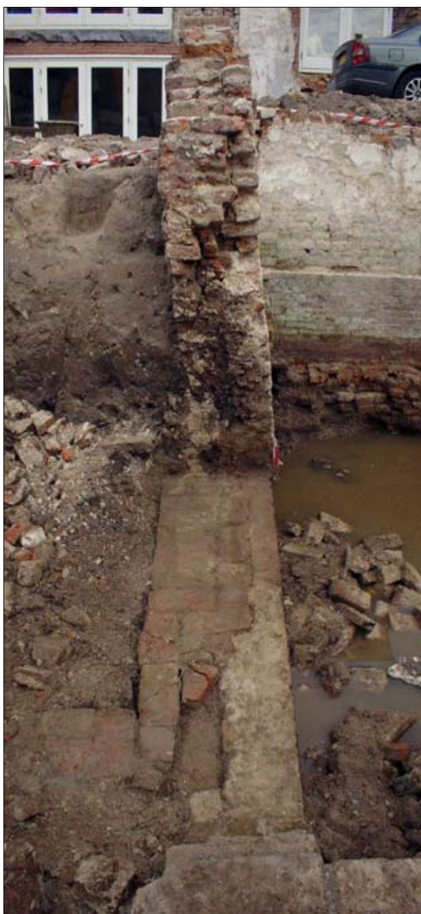
5.16 Aansluiting van de westelijke fundering van gebouw D (rechts) op de oostelijke fundering van gebouw A (links). Bij de bouw van gebouw D werd gebruik gemaakt van het al bestaande gebouw A. De 80 cm brede doorgang tussen beide gebouwen lag op deze plek. Op het moment dat deze foto genomen werd was een groot deel van het muurwerk van gebouw D gesloopt om de verbinding tussen beide gebouwen te kunnen documenteren.
