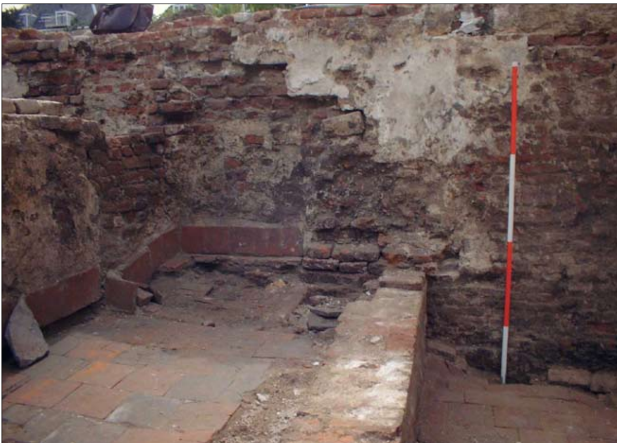
5.31 Aftekening van traptreden bij het stucwerk in kelder 5 in gebouw D (gezien van oost naar west).
