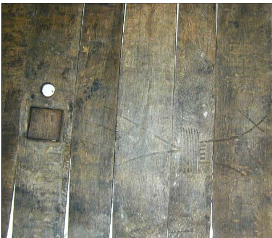
5.10 Detail van enkele duigen van de ton, onderdeel van de laat veertiende-eeuwse waterput op de kreekvulling. Zichtbaar zijn een merkteken, een tapgat en een vierkante opening met plankje.
