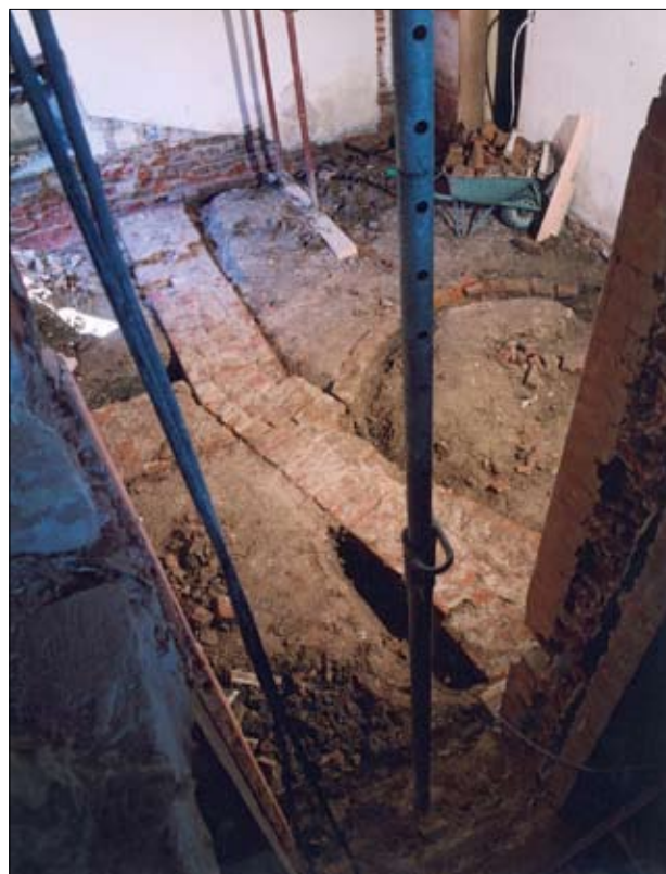
3.1 De koorsluiting van de vijftiende-eeuwse kapel (gezien richting het westen), waargenomen tijdens de archeologische begeleiding van bouwwerkzaamheden in Brigittenstraat 9 in april 2003 (zie afb. 5.20 voor de ligging van de kapel t.o.v. het opgravingsterrein). De muur op de achtergrond is de huidige scheidingmuur tussen Brigittenstraat 7 en 9. Rechts is een zeventiende-eeuwse beerput ingegraven. (Bron: Fotodienst gemeente Utrecht)
