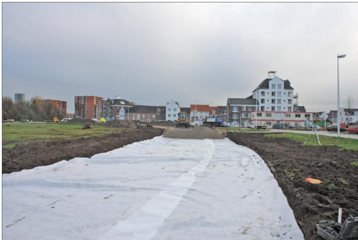
Afb.1.5 Direct na de onderzoeken van de vrijgelegde vlakken en de vrijgekomen stortgrond zijn de ontgraven cunetgedeeltes afgedekt met worteldoek en zand.
