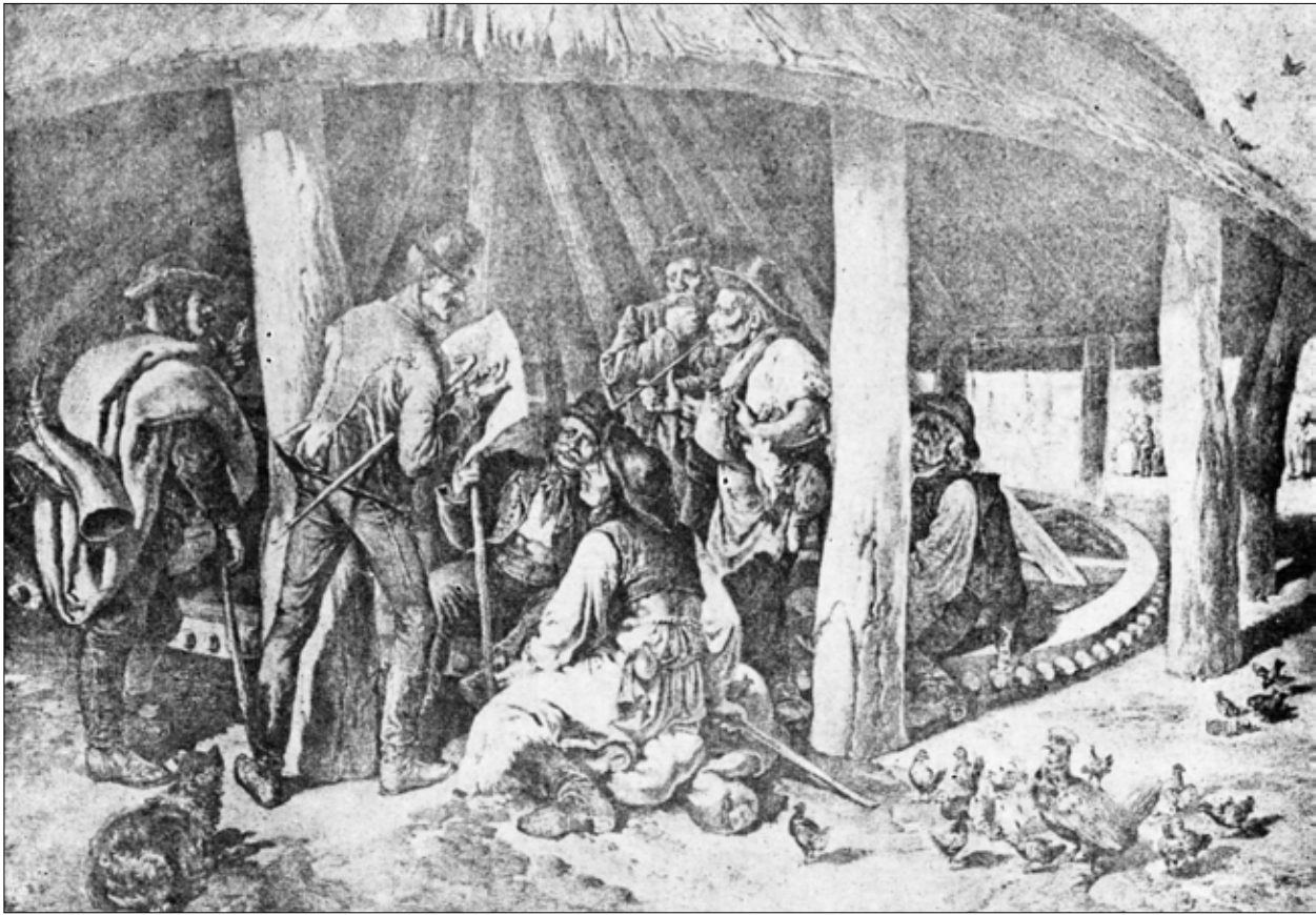
3.6 Schets van een achttiende-eeuwse rosmolen door kunstenaar János Jánko (1833-1896), Hongarije. De stijlen die de kegelvormige kap dragen, bestaan hier uit nauwelijks bewerkte delen boomstam. Op geringe hoogte boven de grond bevindt zich een reusachtig tandwiel waarbinnen één of meer paarden liepen die de molen voorttrokken. (Bron: www.molenbehoud.nl )
