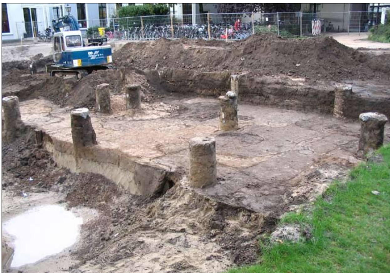
3.1 De werkputten werden één voor één aangelegd. Op de voorgrond de afgewerkte werkput 2. In het midden, vlak 2 van werkput 3 met ingekraste sporen, daarachter het stort op de nog aan te leggen werkput 4. Foto naar het noordwesten genomen.
