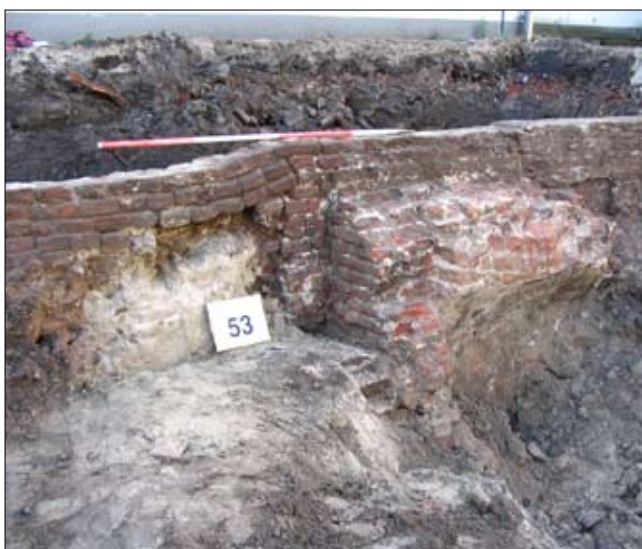
5.18 Aansluiting van perceelsmuur (structuur 2A) op de zuidmuur van het achterhuis (Structuur 2E). De tuinmuur is hier iets verzakt ten opzichte van het achterhuis. Het schone zand achter het foto-bordje is vermoedelijk na de sloopwerkzaamheden in 2005 door de graafmachine in het gat onder de tuinmuur gedrukt. Foto genomen naar ZZW.
