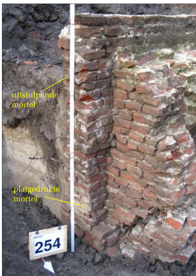
5.18 Aansluiting van perceelsmuur (structuur 2A) op de zuidmuur van het achterhuis (Structuur 2E). De tuinmuur is hier iets verzakt ten opzichte van het achterhuis. Het schone zand achter het foto-bordje is vermoedelijk na de sloopwerkzaamheden in 2005 door de graafmachine in het gat onder de tuinmuur gedrukt. Foto genomen naar ZZW.
