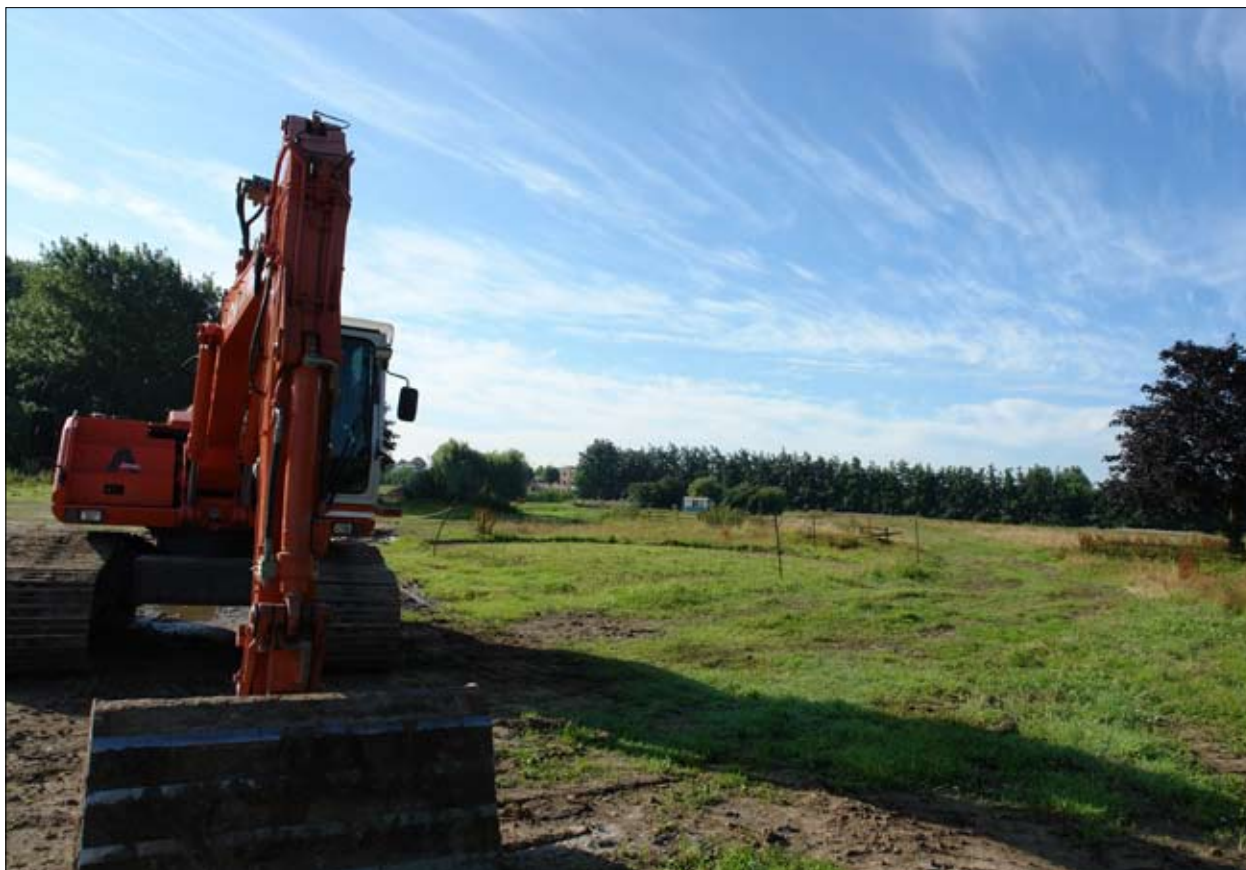
Afb. 1.5 Een impressie van het onderzoeksterrein voor aanvang van de graafwerkzaamheden.
