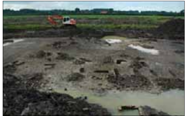
Afb. 5.10 De wandstijlen en gebintpalen aan de oostzijde van de huisplattegrond zijn gecoupeerd. Op de voorgrond in het water (!) het middeleeuwse bakstenen privaatje. Op de achtergrond Haarzuilens.
