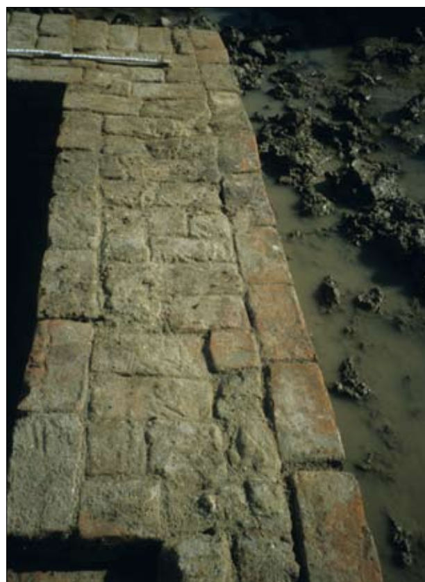
Afb. 5.20 Detail muurwerk middeleeuwse fundering (S-4). De bakstenen zijn primair gebruikt en liggen in 'wild' verband. Om de vastgestelde muurdikte te bereiken is consequent gebruik gemaakt van meer dan twee bakstenen (70 cm). Zo is bijvoorbeeld een laag van twee rijen koppen aan de binnenzijde ingevuld met kleine restanten van stenen, of is de binnenste laag koppen samengesteld uit telkens twee halve stenen.
