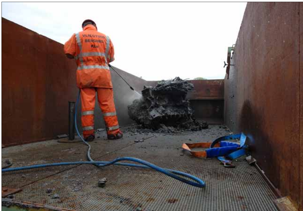
4-7 Alle wrakdelen werden ter plaatste met een hoge drukspuit schoongespoten in een speciaal daarvoor geprepareerde container.
