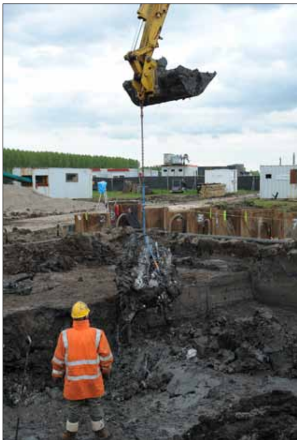
6-5 Het linker motorblok wordt uit de klei getild.
