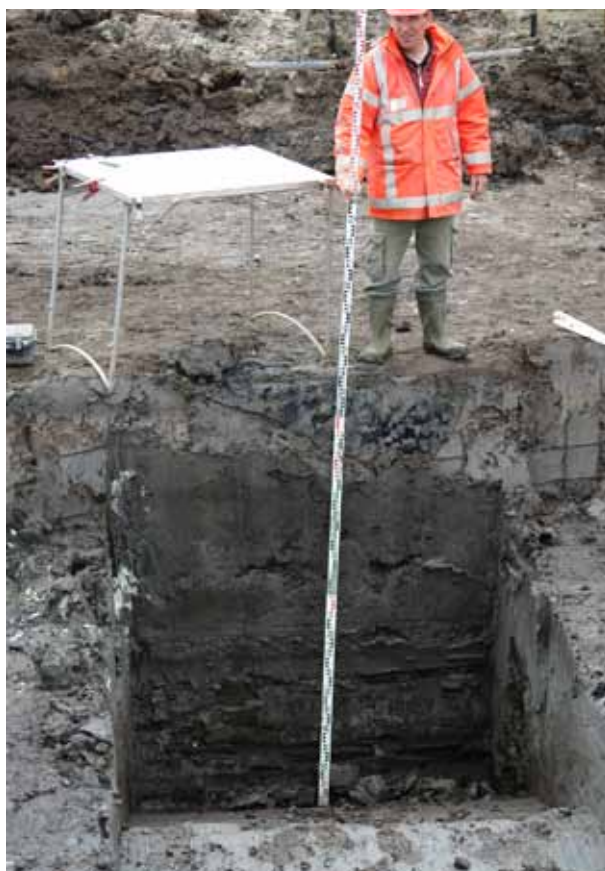
6-1 De bodemopbouw vanaf vlak 2. De onderste ca. 90 cm bestond uit veen, daarboven bevond zich een kleipakket. Bovenin is een restant van de (boven vlak 2 gelegen) laklaag zichtbaar. Dit deel van de laklaag is naar beneden gezakt, nadat het linker motorblok (witte vlek links) onder de laklaag door de kleilaag in is geschoten.
