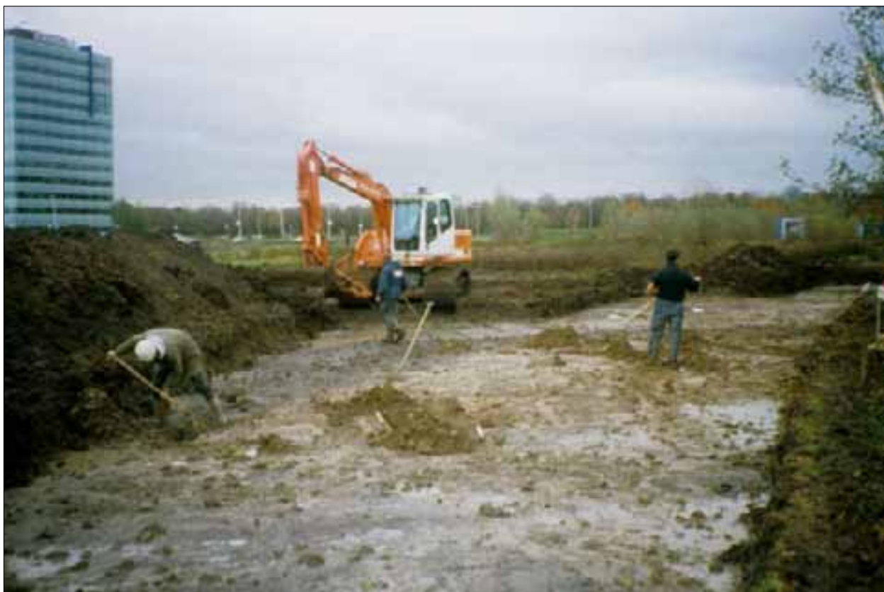
Afb. 1.4 Het opgravingsteam aan het werk in sleuf 13.
