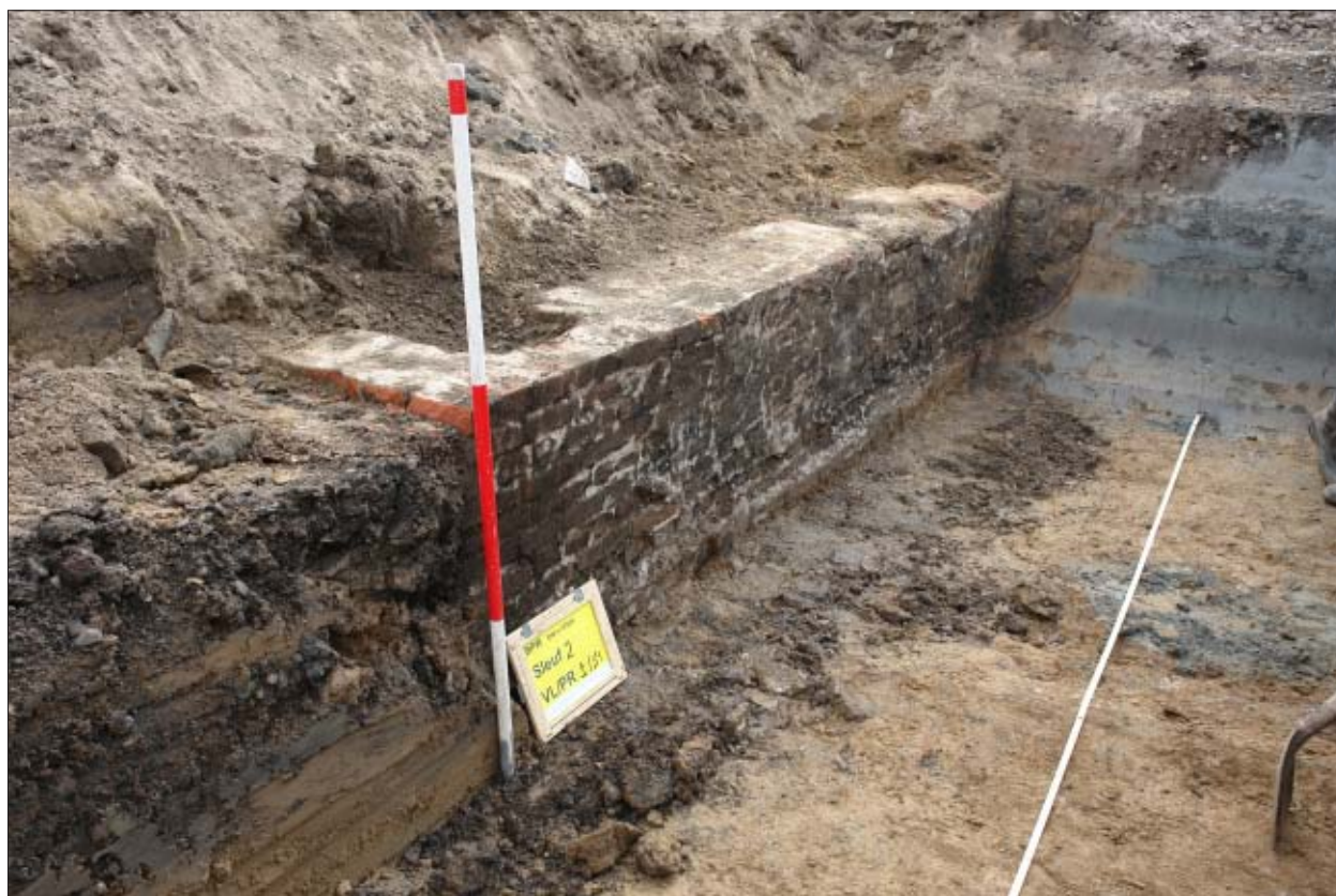
Afb.4.4 Fundering (sleuf 2, spoor 1) vanuit het westen gezien.
