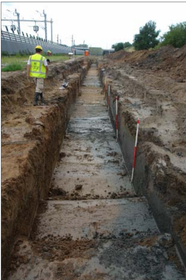
Afb. 3.2 Overzicht sleuf 1, vanuit het westen gezien.
