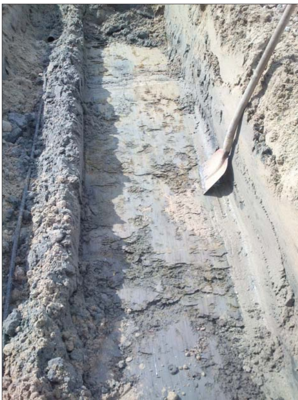
Afb. 1.13 Een van de rioolsleuven van de archeologische begeleiding LR87. De ontgraving raakt het archeologische niveau niet, maar blijft beperkt tot de ophogingslaag.
