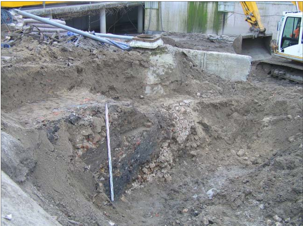
Afb. 4.17: Het profiel van de slotgracht tijdens de werkzaamheden.
