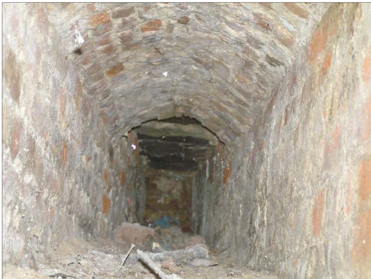
Afb. 4.24: Blik vanuit de uitmonding van het centrale schietgat in de westelijke kijksleuf". Het vrijwel vierkante gat van ca. 50 x 50 cm, dat schuin staat op de wang van de hoofdsleuf, heeft een segmentboogvormig gewelf.
