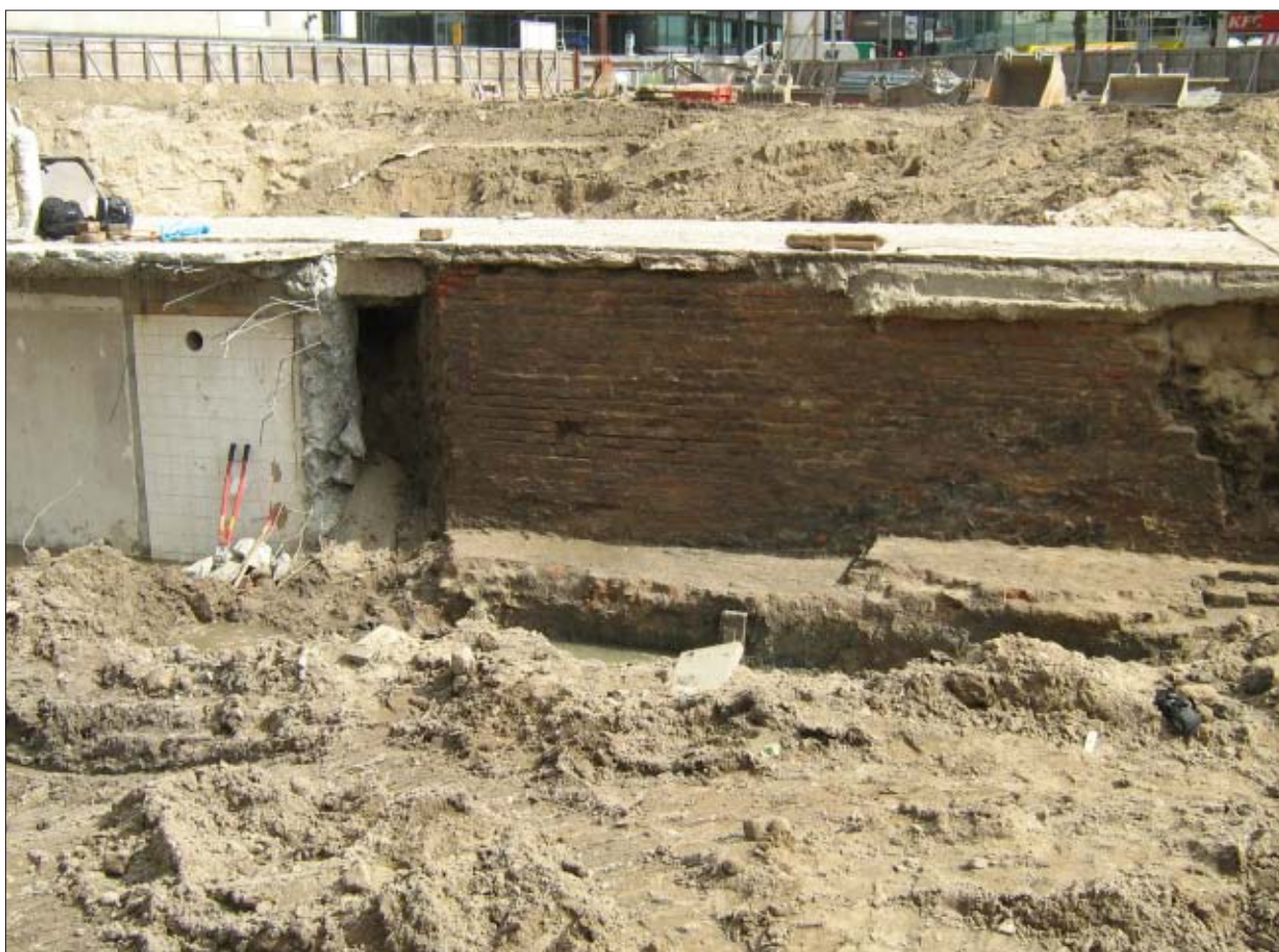
Afb. 4.3: De funderingsvoet van de binnenzijde van de oostelijke buitenschil.
