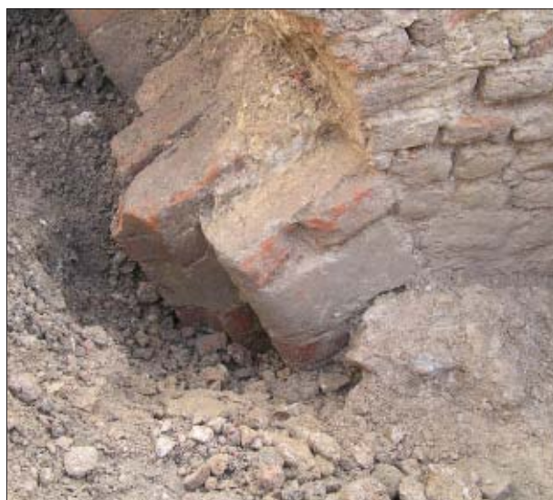
Afb. 4.21: Blik op het secundair aangebrachte gewelf met doorsnede van de rechtse van natuursteen en vormbaksteen vervaardigde gewelfrib. De middelste rib is links zichtbaar. Het gewelf is gezien de verticale naad bijna voor het reeds bestaande schietgat geplaatst.
