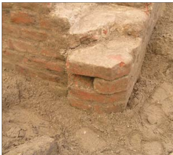
Afb. 5.11: Afgeschuinde vormbakstenen, gebruikt bij de deurpost naar de trap (Vre411).
