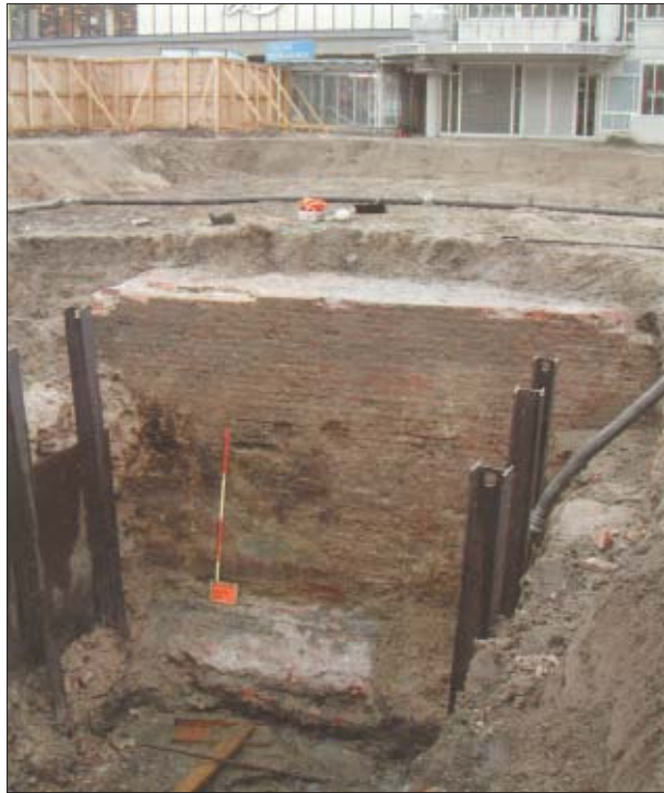
Afb. 1.7: Foto van de vrijgelegde funderingsvoet van de oostelijke buitenmuur aan de grachtzijde. 10
