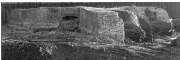
Afb. 1.4: De blootgelegde fundamenten van de zuidoost toren. (Bron: Het Utrechts Archief invnr. 84096)
