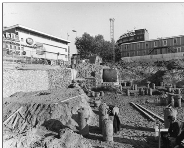
Afb. 3.2: Resten van de noordmuur ten tijde van de bouw van het Muziekcentrum, eind jaren '70 van de twintigste eeuw. De noordmuur bevindt zich aan de linkerkant ter hoogte van het midden. (Bron: Het Utrechts Archief invnr. 46391)
