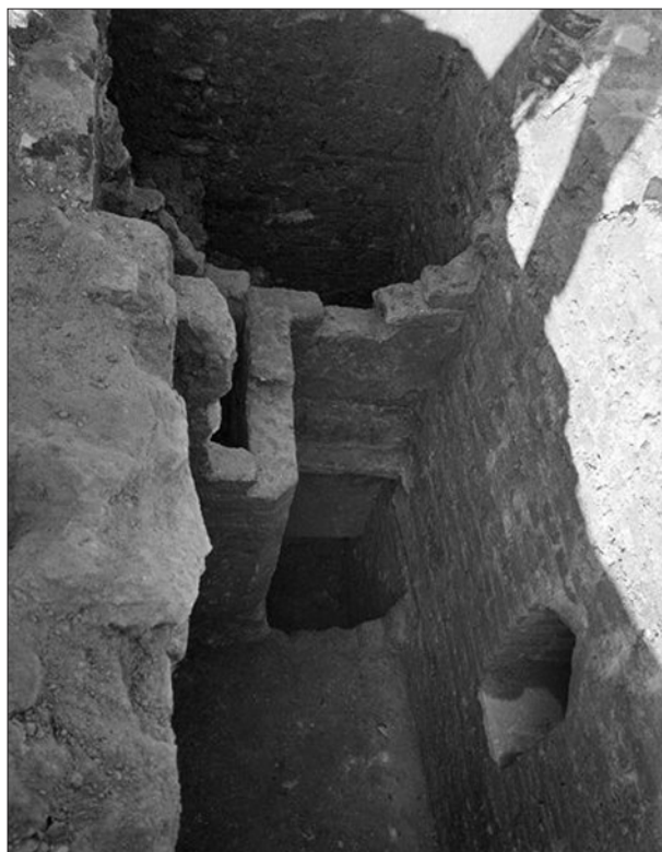
Afb. 1.5: Een deel van de stortkokers voor en één latrine zelf van de zuidoost toren. De noordoost toren had een vergelijkbare constructie. (Bron: Het Utrechts Archief invnr. 84099)
