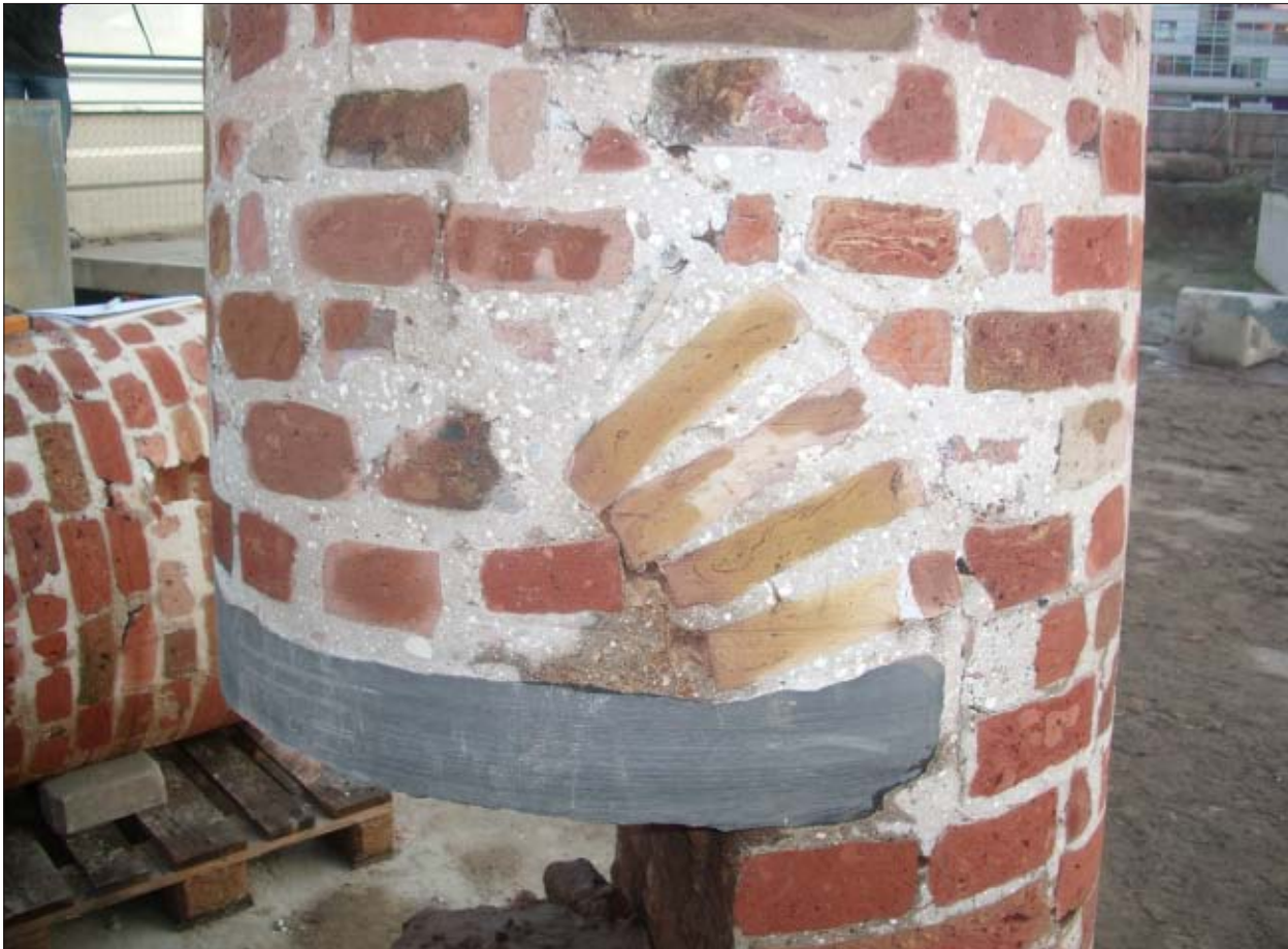
Afb. 4.11: Aanzet van een boog boven de natuurstenen dekplaat.
