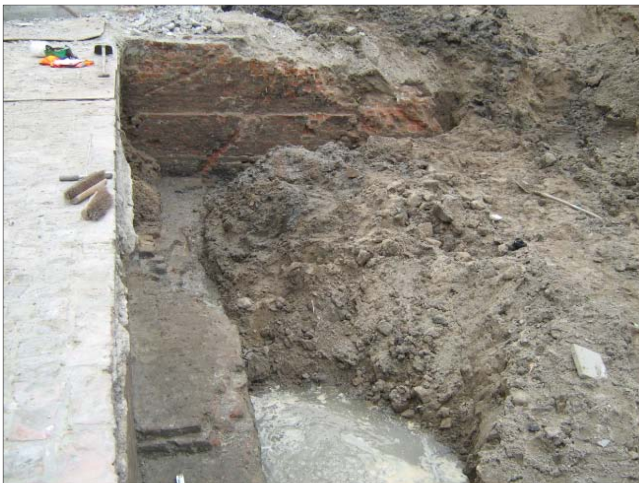
Afb. 4.26: De binnenzijde van de buitenschil van de oostelijke citadelmuur (links). De bovenzijde is het in 1978 hersteld en vlak afgewerkt gereconstrueerde deel. Aan de voet het fundament van ongeveer 1 m breedte. De muur is aan de westzijde niet afgewerkt. In het midden de steunbeer (oost-west) met een geringe versnijding halverwege de hoogte. De muur kon aan de zuidzijde niet worden onderzocht. Evenals de binnenzijde van de buitenschil is de muur niet gevoegd, omdat deze niet in het zicht was, maar met aarde bedekt.
