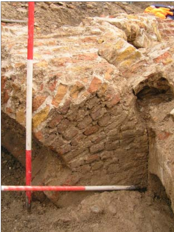
Afb. 4.5: Zichtbare bouwnaad bij de zuidoostelijke gewelfboog.
