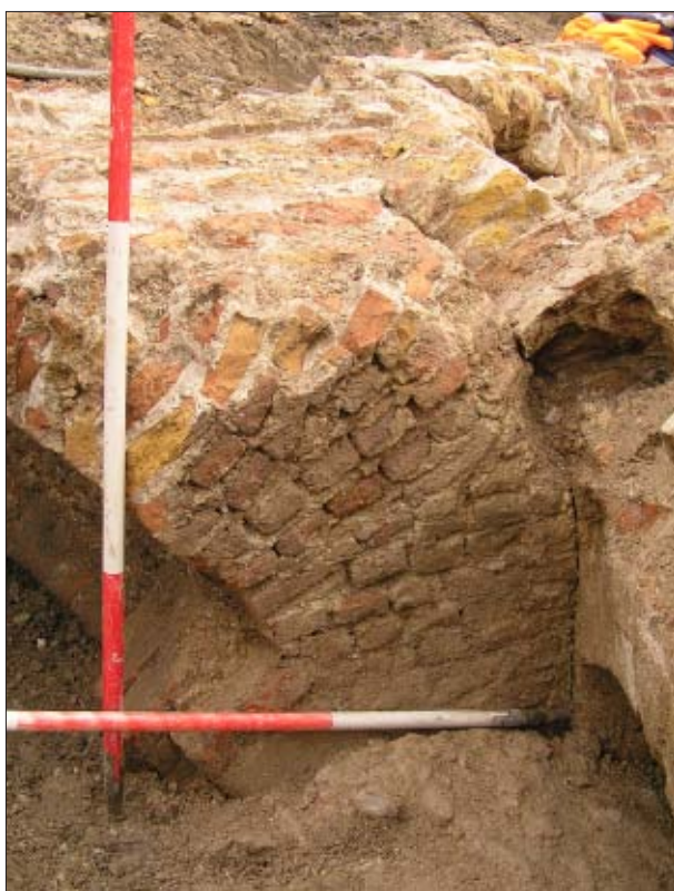
Afb. 4.20: Blik op de mond van het getoogde schietgat met links het secundair aangebrachte gewelf met de middelste gewelfrib.
