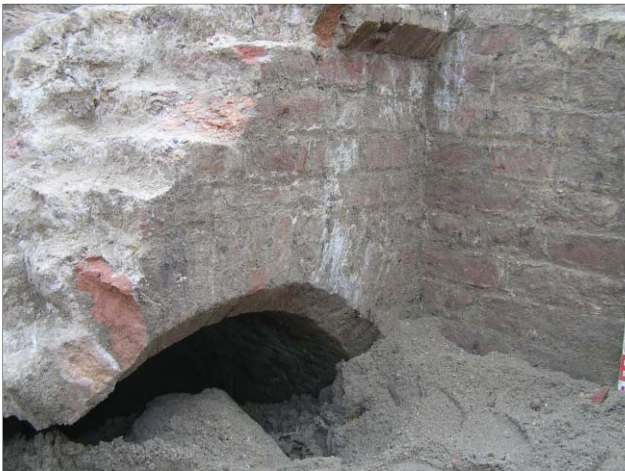
Afb. 5.12: Afgeschuinde vormbakstenen, gebruikt bij de boog van de spaarruimte en het plafond onder de trap.
