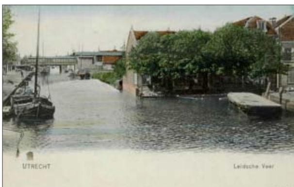
Afb. 6: Situatie in 1904. Aan de linkerkant is de zuidelijke beschoeiing van de Leidschevaart zichtbaar. Een bomerij staat op de locatie waar later een trambaan loopt. Bron Utrechts Archief, catnr. 4334.
