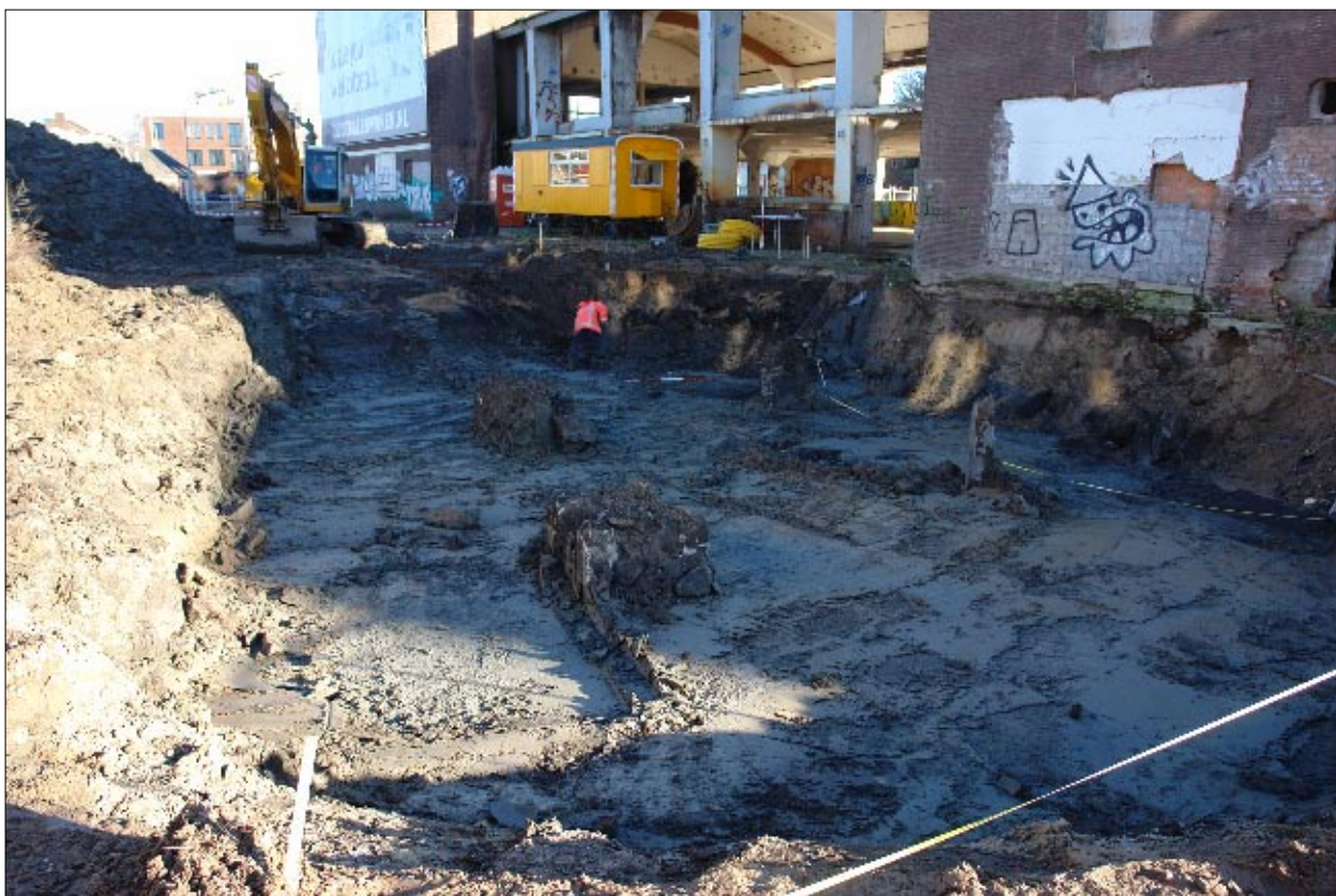
Afb. 1.4 Overzicht sleuf 8 na de sanering (vanuit het westen gezien).
