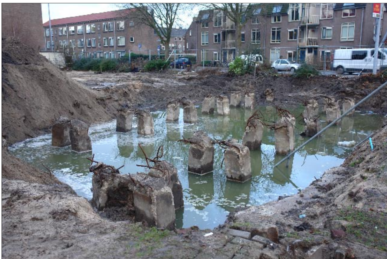
Afb. 1.3 Overzicht sleuf 7 na de sanering (vanuit het zuidoosten gezien).
