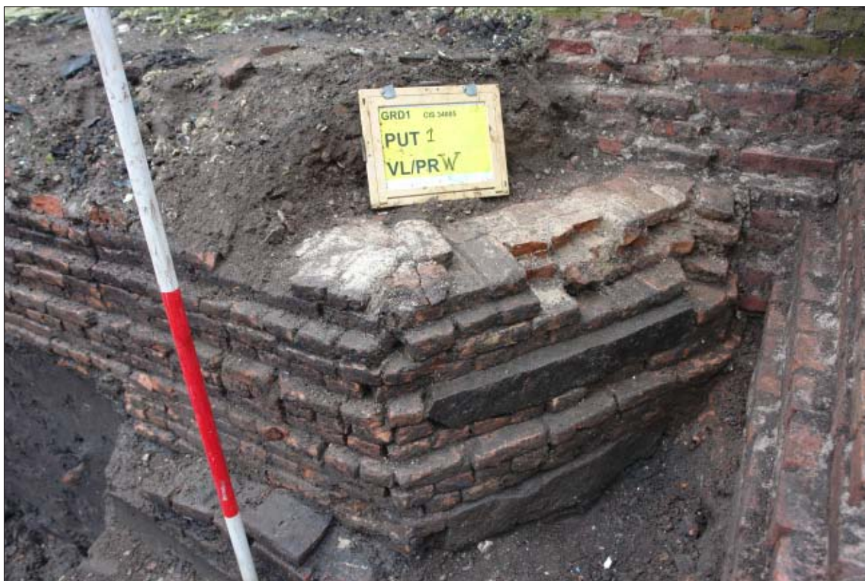
Afb. 5.2 Westprofiel van sleuf 1, met detail bakstenen muurfundering met twee lagen lei/natuursteen (spoornummer 1).
