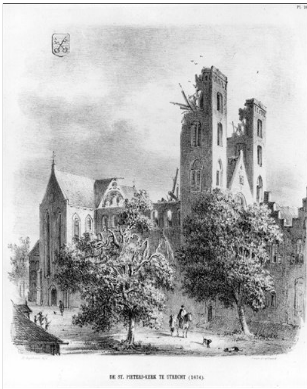
Afb. 5.17 Prent naar tekening van Herman Saftleven uit 1674. Gezicht op de Pieterskerk vanuit het noordwesten. De kerk is zwaar beschadigd door de tornado van 1674.
