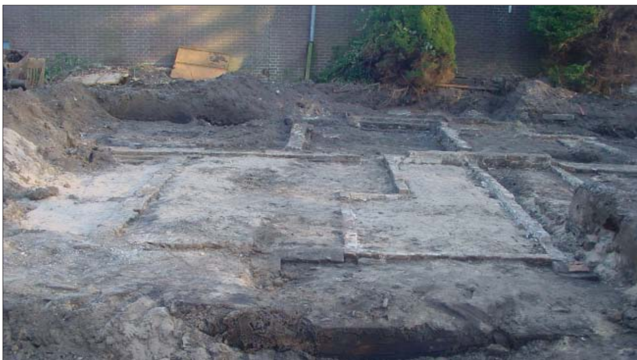
Afb. 2.11 Funderingen van de woningen (vanuit het zuiden gezien).
