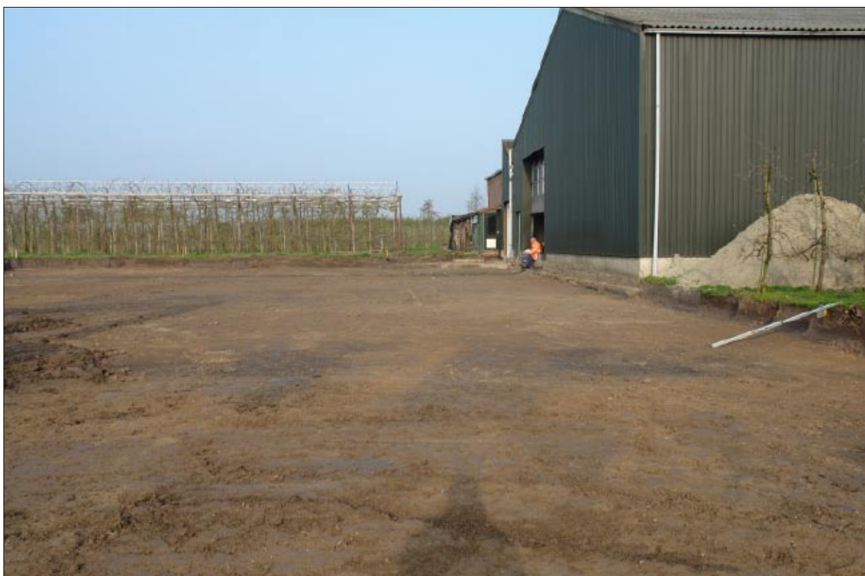
Afb. 1.6 Het ontgraven terrein tijdens de waarneming bij de loods aan de Groenedijk.
