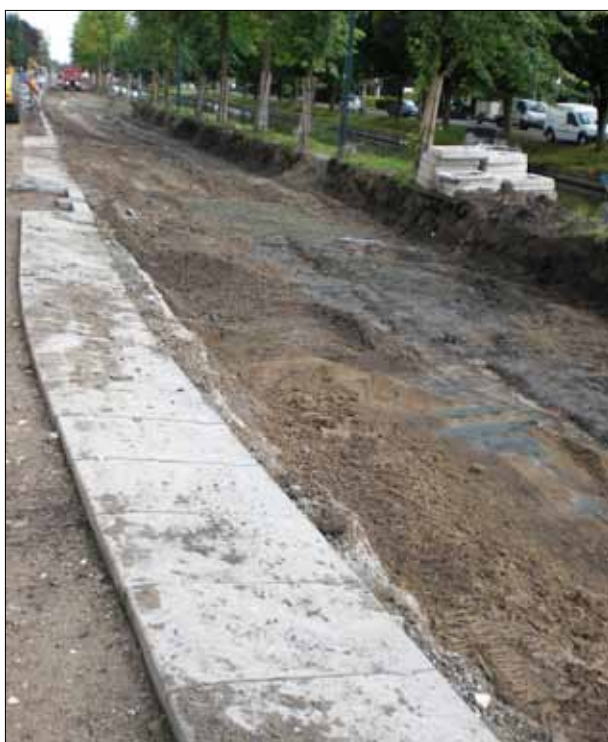
Afb. 3.26: Overzicht van de locatie van onderzoeksfase 9.
