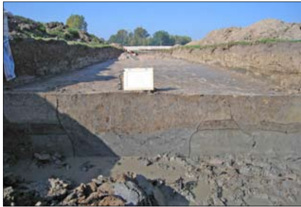
Afb. 3.29 Waterkuil (W-7) in situ.
