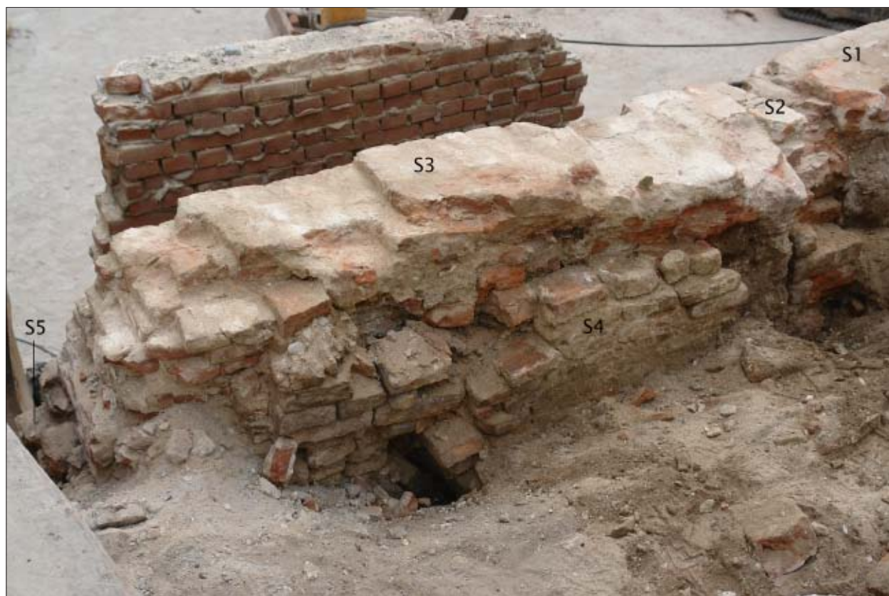
Afb. 4.9 Fundering S3, gezien richting het oosten, met daarvoor de dichtzetting (S4) van de doorgang.
