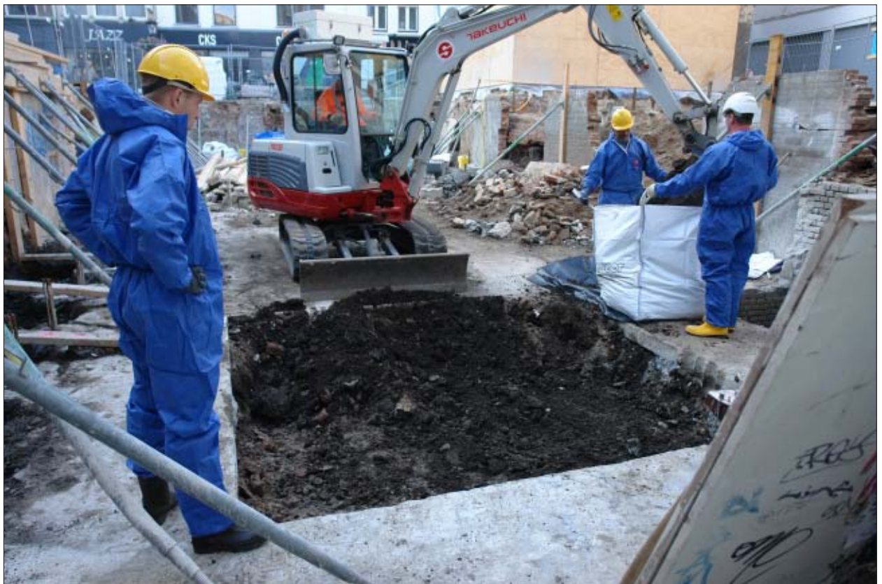
Afb. 3.3 Bij het uitgraven van de liftput diende het bovenste deel van de grond apart gehouden te worden vanwege vervuiling (gezien in zuidelijke richting).
