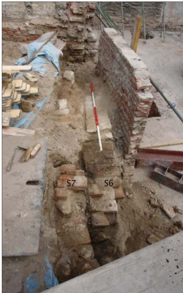
Afb. 4.2 De funderingen S6 (rechts) en S7 (links) op vlakniveau, gezien in noordelijke richting.
