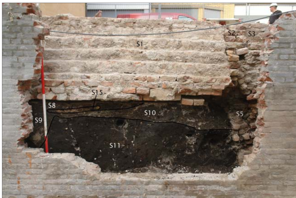
Afb. 4.12 Fundering S1 zoals zichtbaar in het profiel van put 1. Aan de rechterzijde is nog net de middeleeuwse zuidelijke kelderdeur S2 zichtbaar, die aan de bovenzijde in zuidelijke richting is verzakt.
