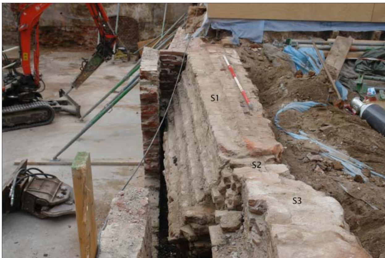
Afb. 4.11 Fundering S3 (voorgrond) en S1 (achtergrond), gezien in zuidelijke richting.
