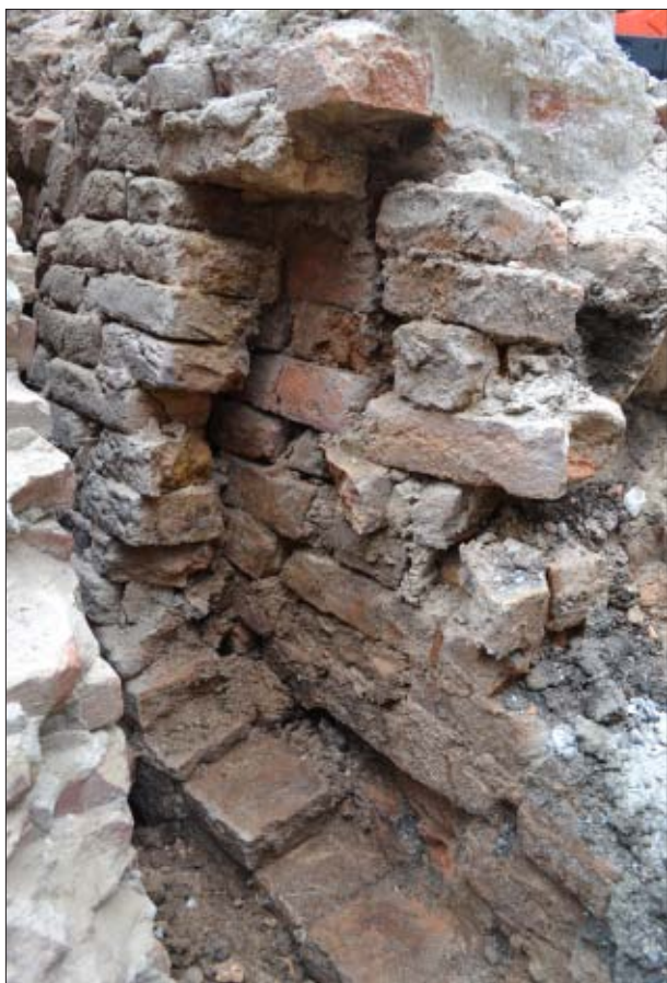
Afb. 4.5 Detail van de middeleeuwse keldermuur S5, gezien in zuidwestelijke richting. Zichtbaar is een afgebroken, dwars geplaatste kloostermop. Aan de linkerkant is te zien dat de binnenste schil van de keldermuur is verzakt.
