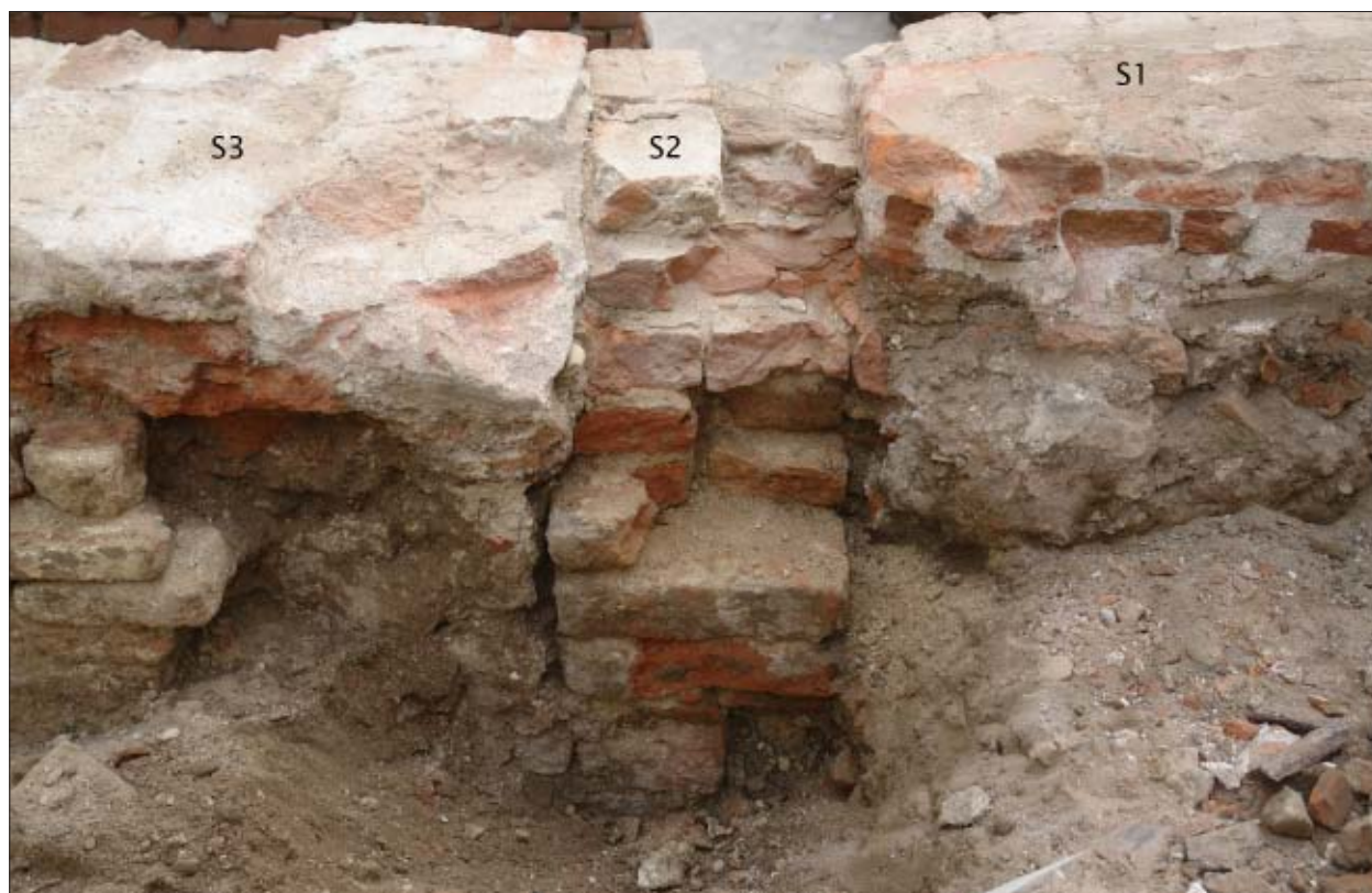
Afb. 4.6 De kopse kant van de zuidelijke middeleeuwse keldermuur, gezien in oostelijke richting.
