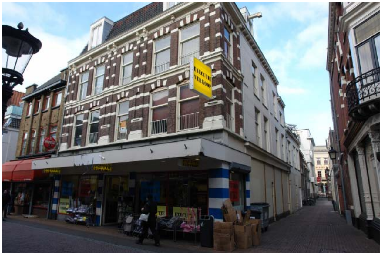
Afb. 1.4 De voorgevel aan de Steenweg en de oostelijke zijgevel aan de Massegast van de te slopen panden op 13 februari 2013, gezien in noordwestelijke richting.
