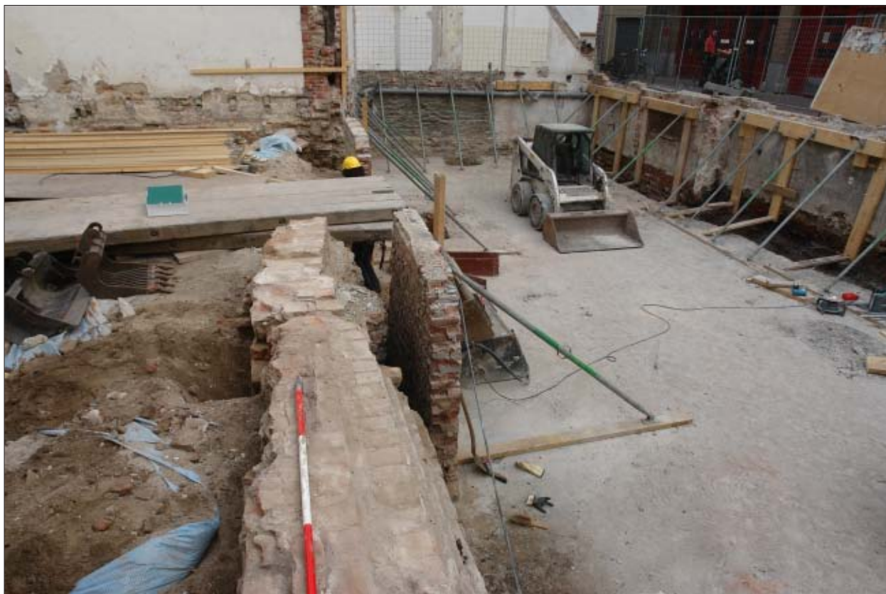
Afb. 3.2 Het plangebied tijdens de eerste waarneming, gezien in noordelijke richting. Boven maaiveld is alles gesloopt en ook de tussenwanden in de kelder zijn verwijderd. In de westelijke, twintigste-eeuwse keldermuur heeft men twee grote gaten aangebracht, waarachter (post)middeleeuws muurwerk zicht werd (onder jalon).
