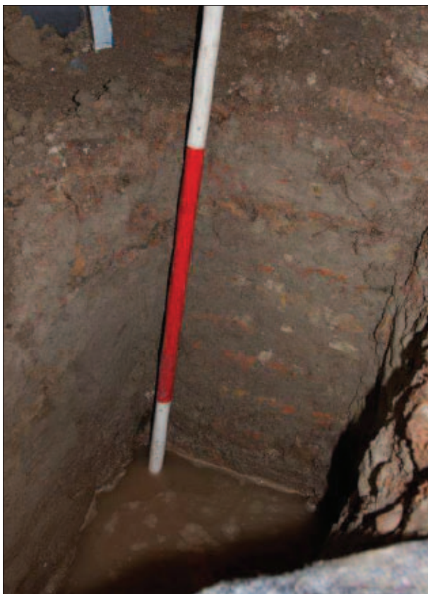
Afb. 4.14 Foto van de coupe bij de noordwestpijler vanaf het diepste vlak naar de onderzijde van de fundering van de pijler. Het grondwater is duidelijk waarneembaar en staat ca. 0,6 meter beneden het vlak.
