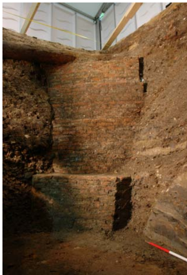
Afb. 3.15 Gotische pijlerfundering met insteken in het noordprofiel.
