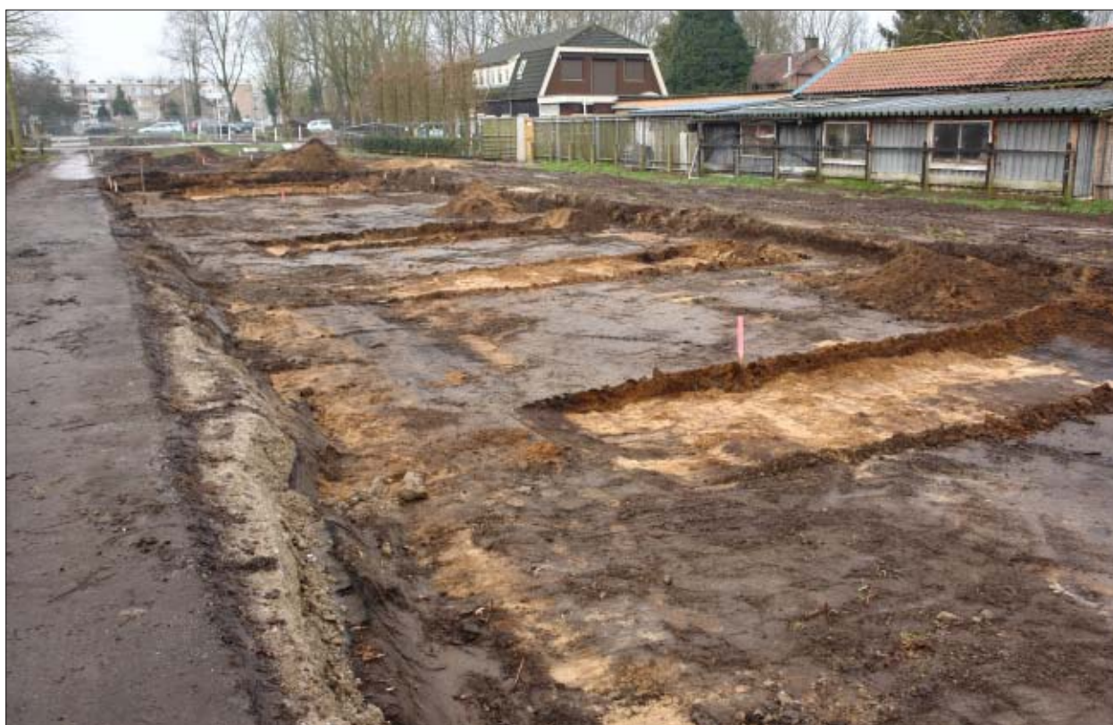
Afb. 2.2 Een overzicht van de proefputten over de locatie van de aanlanding. Foto richting zuid.
