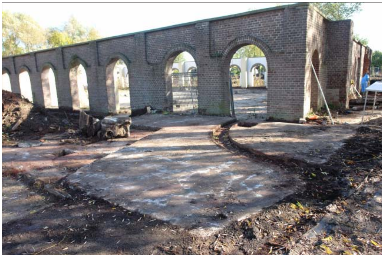
Afb. 2.30 Het betonnen platform, gezien vanuit het zuidwesten.
