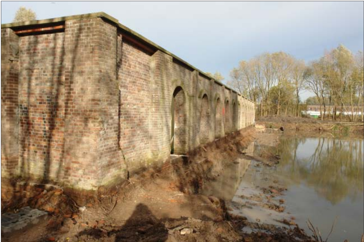
Afb. 2.22 Overzicht ontgraving aan de oostzijde van de voormalige steenfabriek, gezien vanuit het zuiden.
