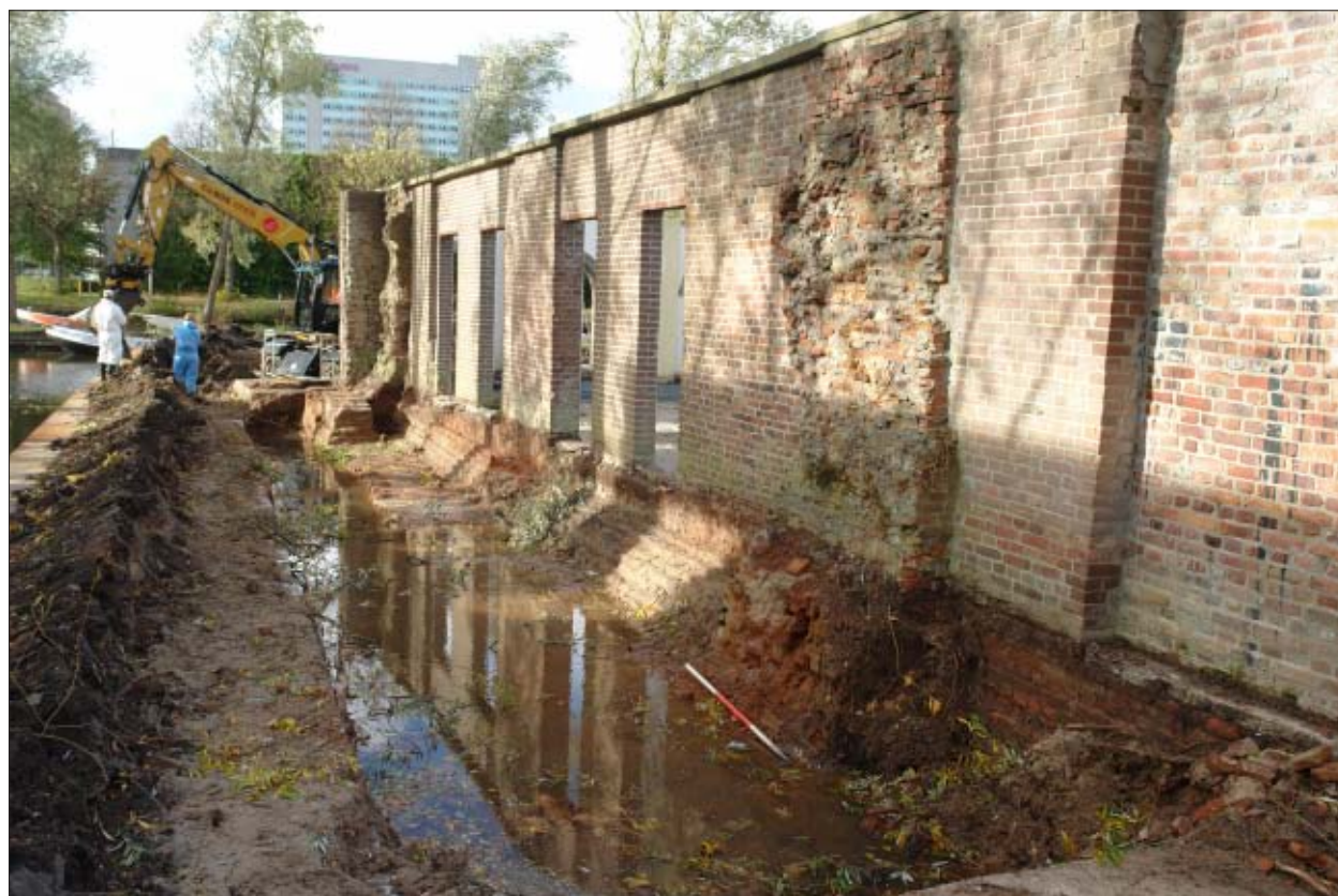
Afb. 2.19 Fundering aan de zuidzijde van de voormalige steenfabriek, gezien vanuit het zuidoosten.
