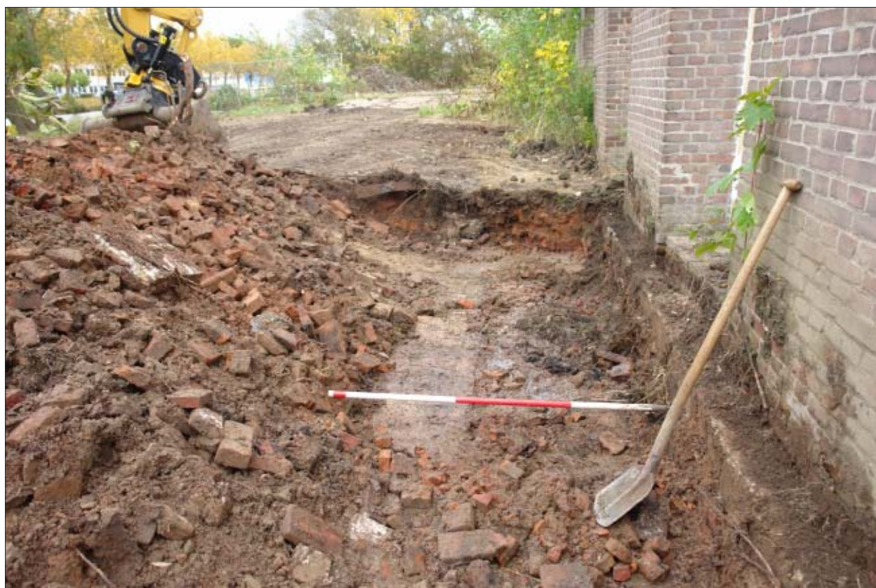
Afb. 2.18 Aanleg sleuf 1, ten westen van de voormalige steenfabriek, gezien vanuit het zuiden.
