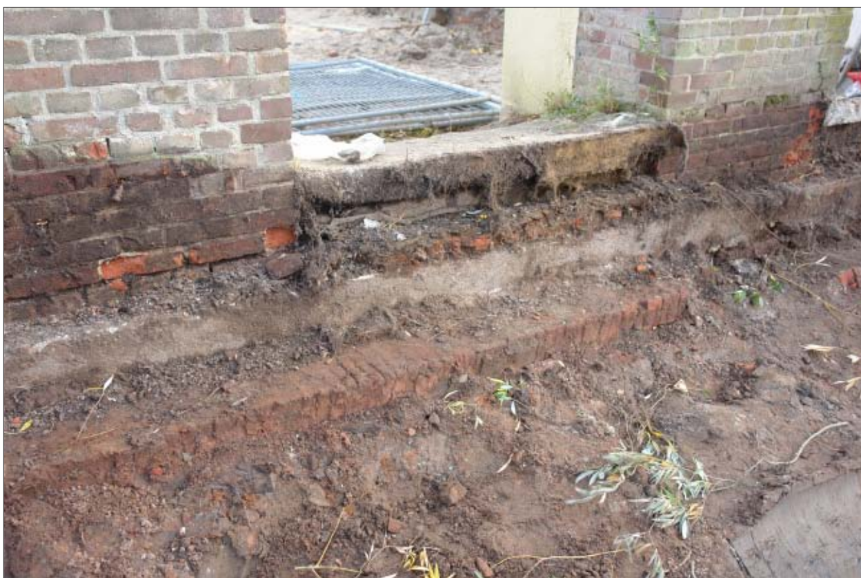
Afb. 2.24 De fundering aan de westzijde van de voormalige steenfabriek, gezien vanuit het noordwesten.
