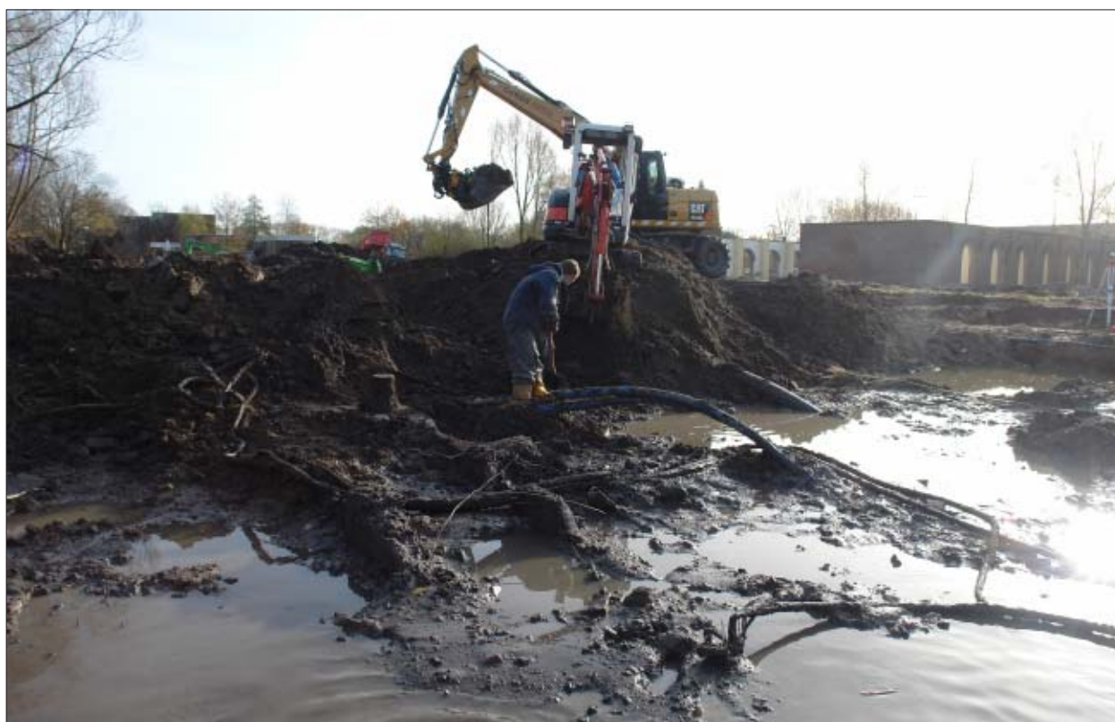
Afb. 2.1 Aanleg sleuf 2, gezien vanuit het noordwesten.
