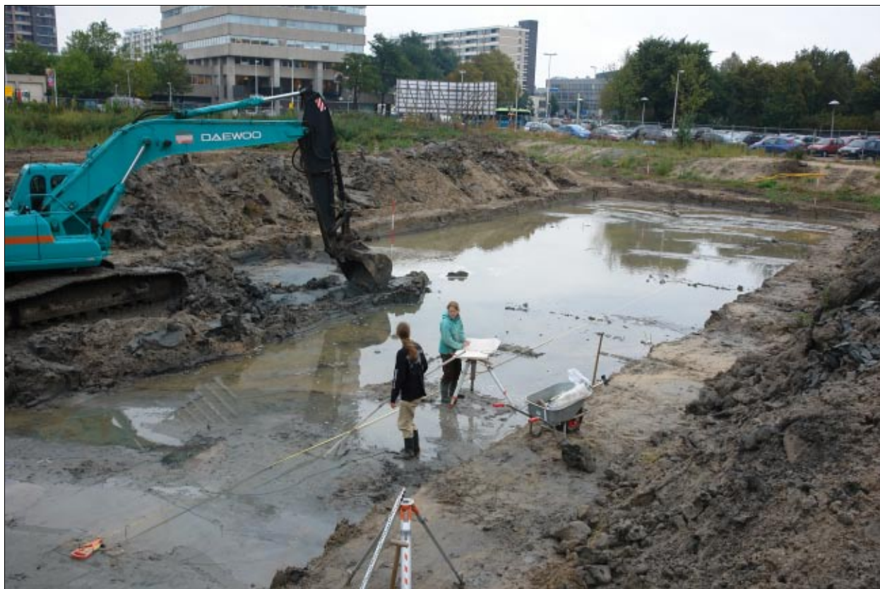
Afb. 3.4 De aanleg van vlak 2 in put 2 in volle gang. In het merendeel van de putten stond het tweede vlak reeds kort na te zijn gedocumenteerd grotendeels onder water als gevolg van de hoge grondwaterstand.
