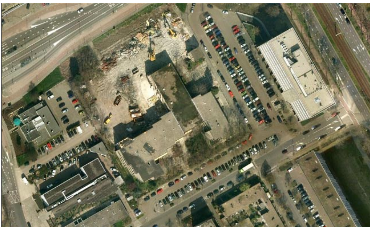
Afb. 3.2 Luchtfoto van het huidige plangebied voorafgaand aan de sloop van het Niels Stensen College (bron: Googlemaps).
