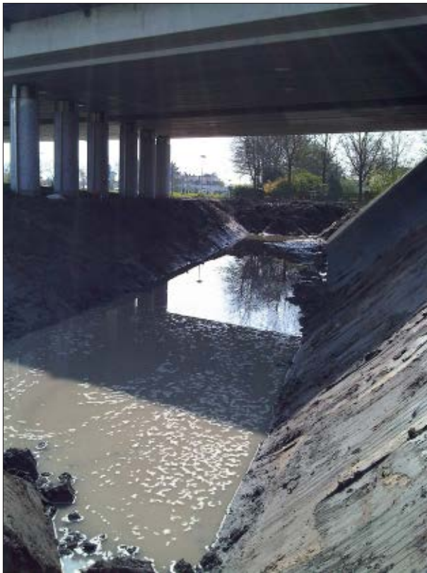
Afb. 6.4 De hier veel smallere Vikingrijn onder het spoorviaduct, gezien richting het zuiden.
