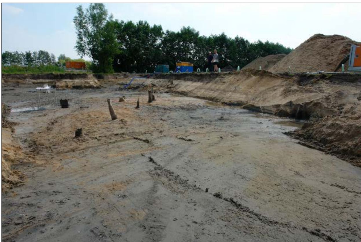
Afb. 4.4 Vlak 2 van werkput 1, gezien richting het oosten.
