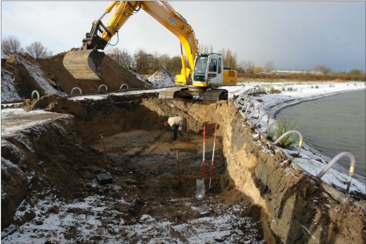
Afb. 1.11 Overzichtsfoto van werkput 4, gezien richting het westen.
