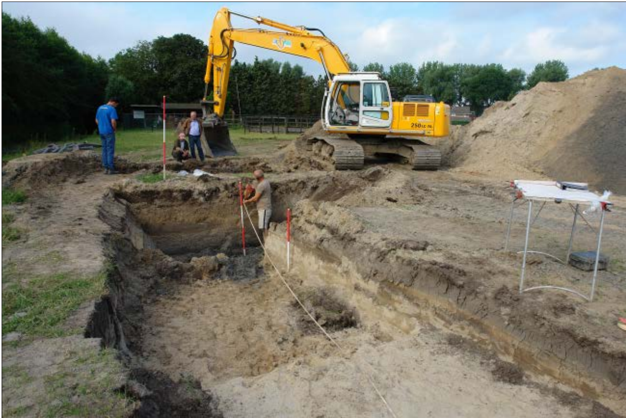
Afb. 4.35 Op de voorgrond de uitbreiding van werkput 1. In de smalle sleuf daarachter, bij de graafmachine, was het schip niet aanwezig.
