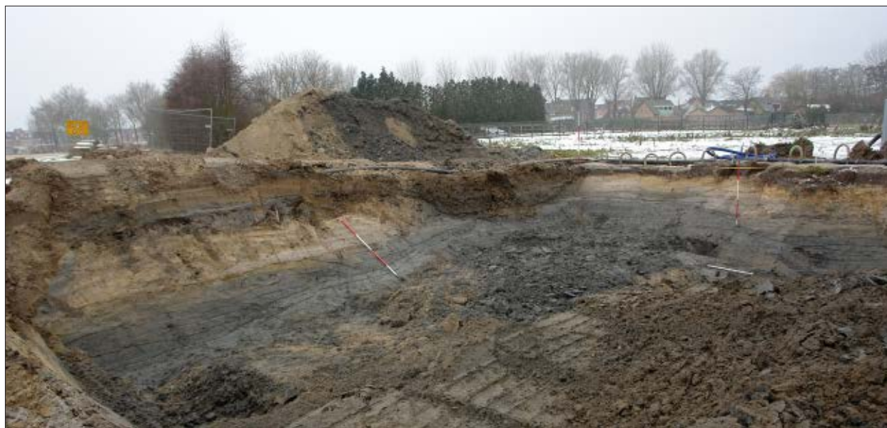
Afb. 4.11 Gelaagde rivierafzettingen in de profielen van werkput 3. Onder de overstromingsafzettingen liggen oudere kronkelwaardgeul of restgeulafzettingen. Foto richting het zuidwesten.
