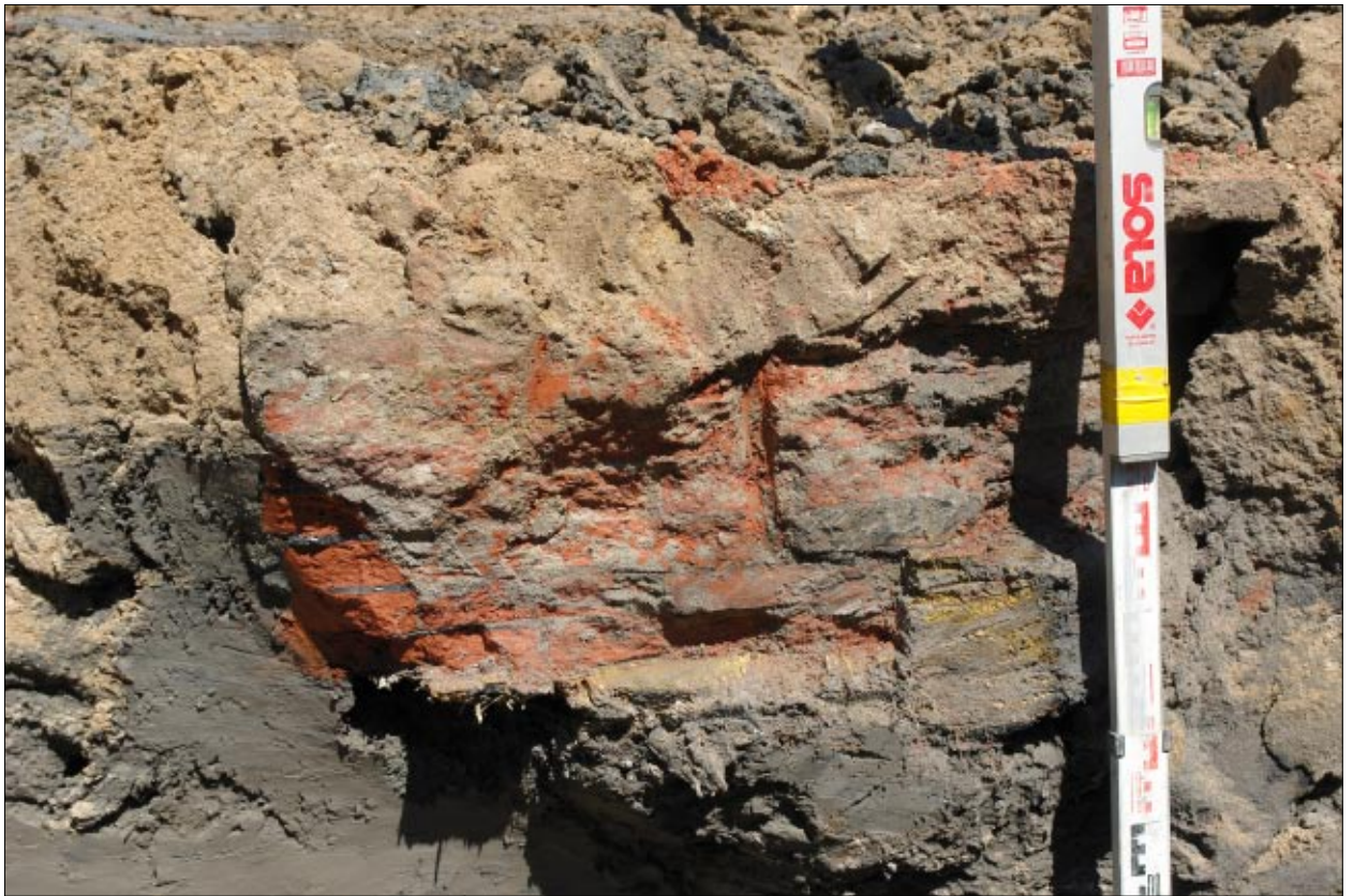
Afb. 5.5 De fundering van de brug.
