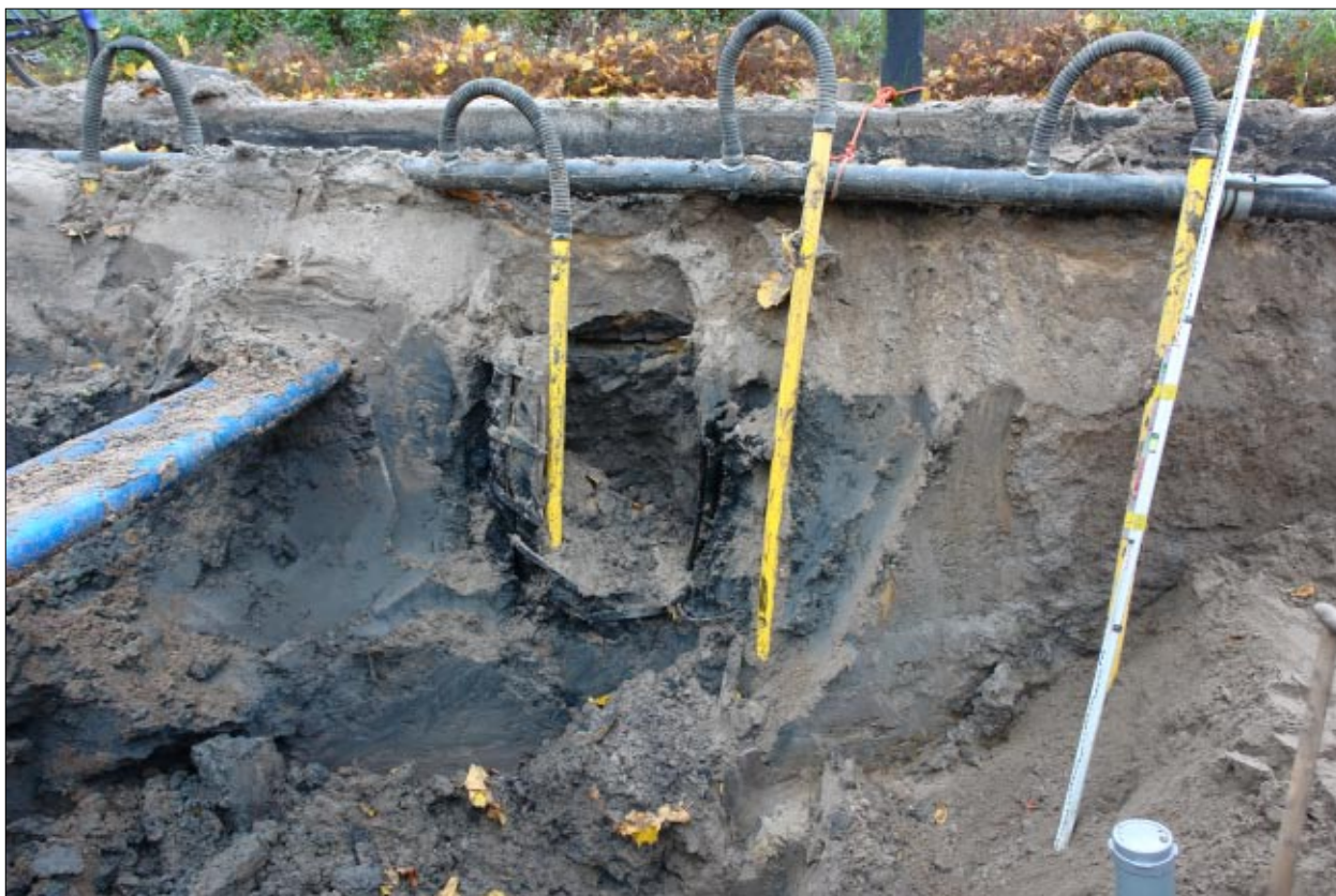
Afb. 5.12 De ton in het profiel, nadat de recente puinvulling eruit gevallen was.
