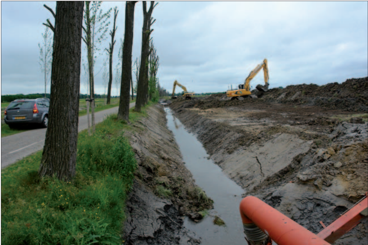
Afb. 3.2 Graafwerkzaamheden ten behoeven van de slootverbreding van de VINEX-watergang in het zuidelijke gedeelte van het plangebied, oostelijk zijde van de Joostenlaan.
