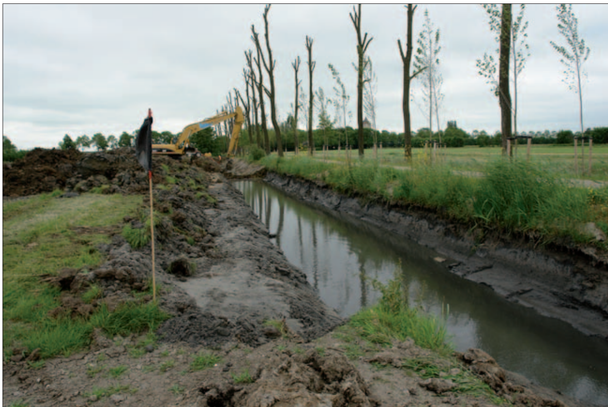
Afb. 3.1 Verbreding van de sloot aan de oostzijde van de Joostenlaan (VINEX-watgang).
