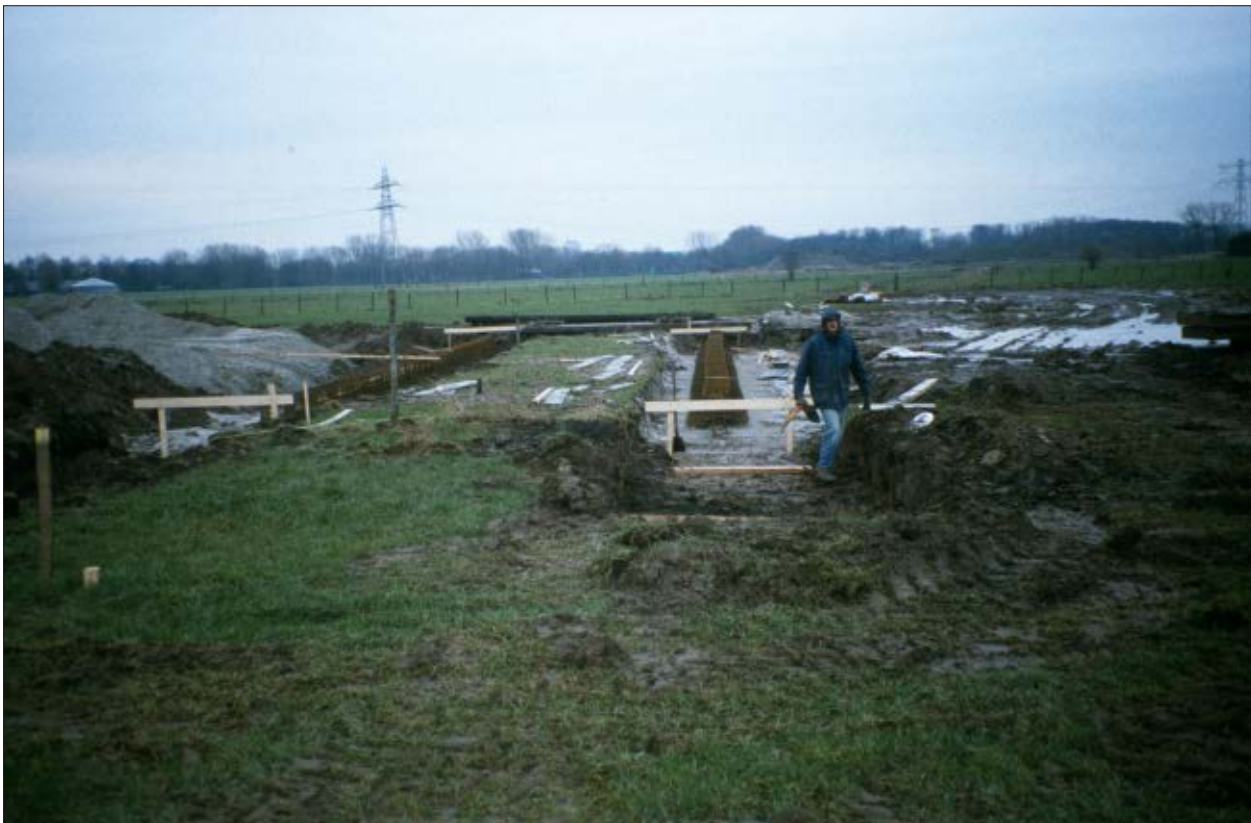
Afb. 1.3 De twee smalle sleuven voor de aanleg van de betonnen overkluizing tijdens de RKW-waarneming, gezien richting het zuiden.
