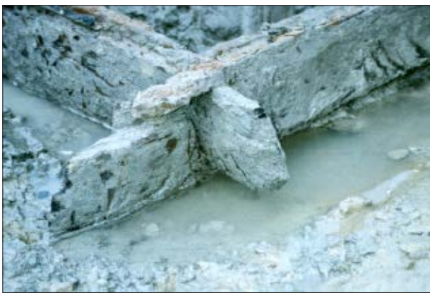
Afb. 5.29c Detailfoto van de oosthoek van de bekisting van waterput WPC.
