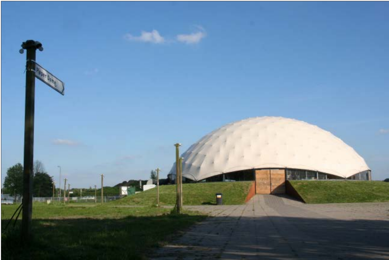
Afb. 1.2 Het theatergebouw Paperdome langs de Hogeweide, gezien richting het zuiden.
