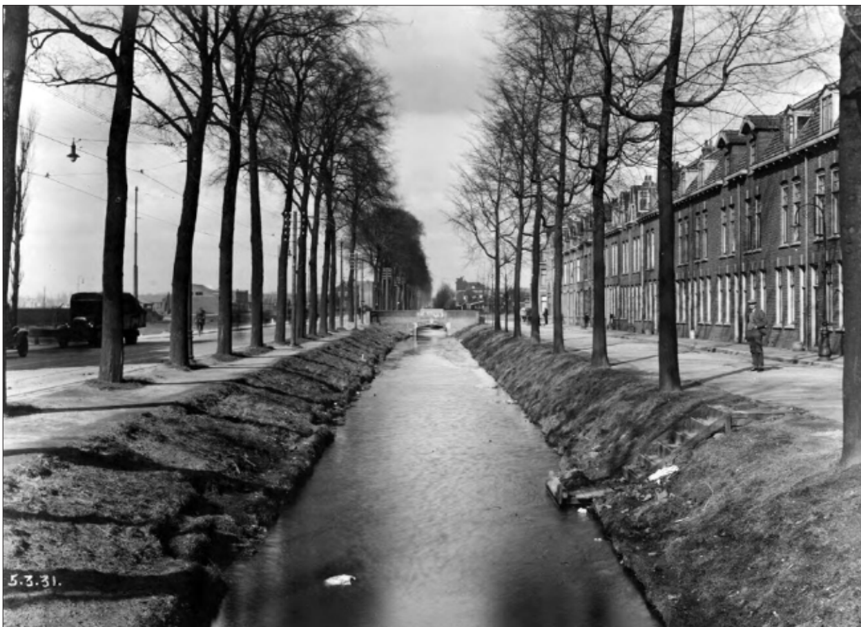
Afb. 2.13a Het zuidelijke deel van de Croeselaan (links) en de Vondelkade (rechts) met daartussen de Blekers- of Moesgracht in 1931, gezien richting het noorden. Het onderzoeksgebied ligt enige honderden meters noordelijker (bron: Het Utrechts Archief, inv.nr. 41816).
