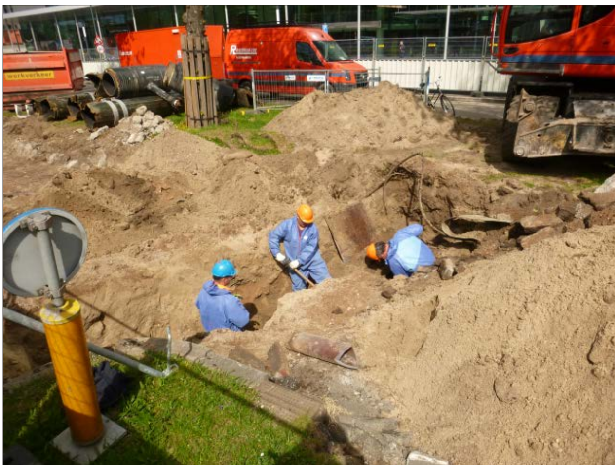
Afb. 1.4 Een van de proefsleufjes die gegraven zijn om de ligging van kabels en leidingen te controleren, gezien richting het noorden. De ondergrond bleek geheel uit (deels geroerde) recente ophogingspakketten van scherp zand en dempingszand van de Blekersgracht te bestaan.
