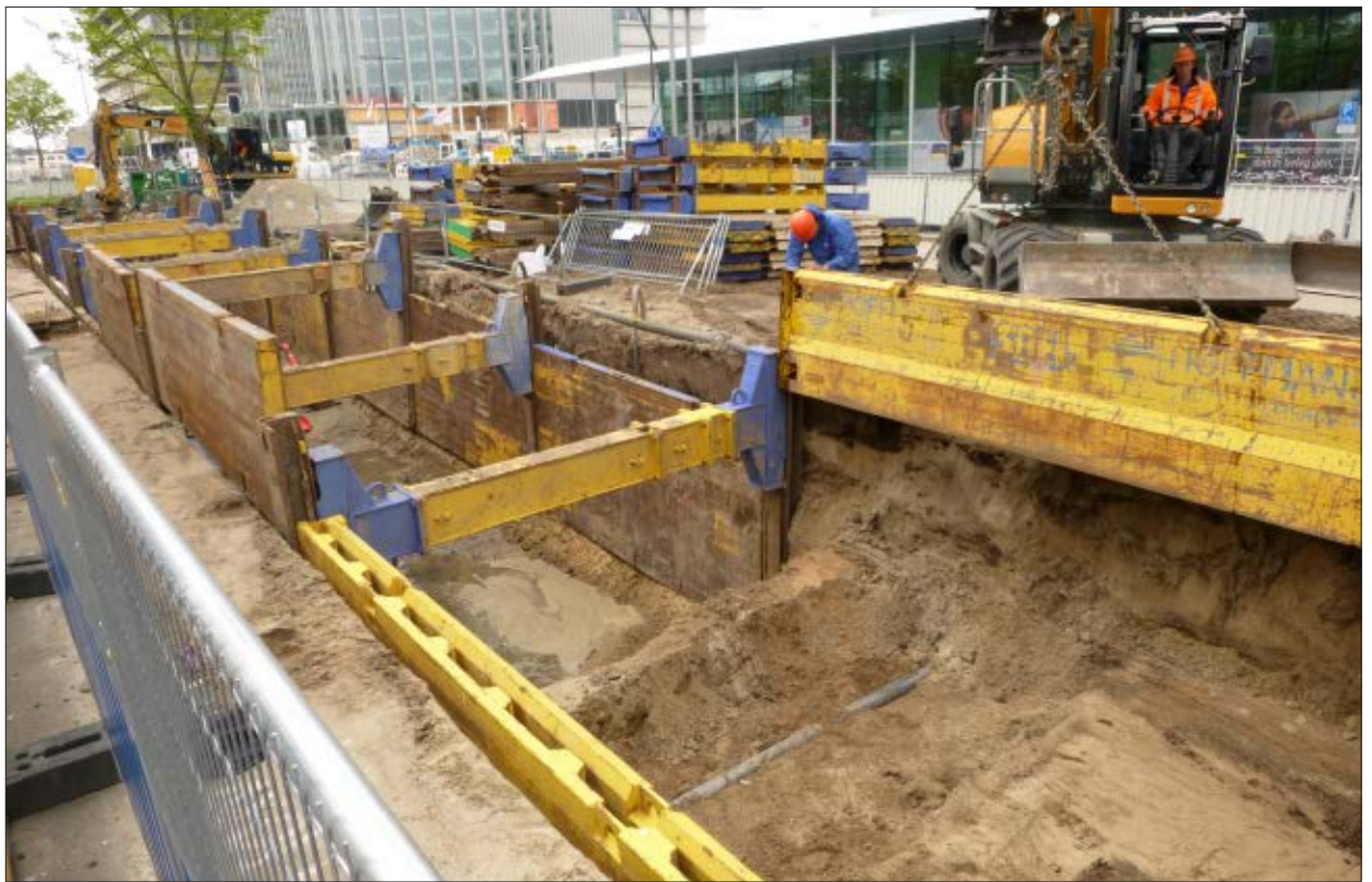
Afb. 1.5b In de diepste delen van de sleuf worden er dwarsbalken tussen de schotten geplaatst om de gronddruk om te vangen, gezien richting het noorden.
