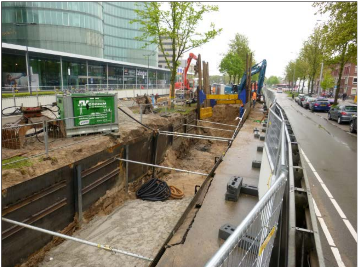
Afb. 1.5c Onderin de sleuf wordt een laagje schoon zand aangebracht, gezien richting het zuidoosten.
