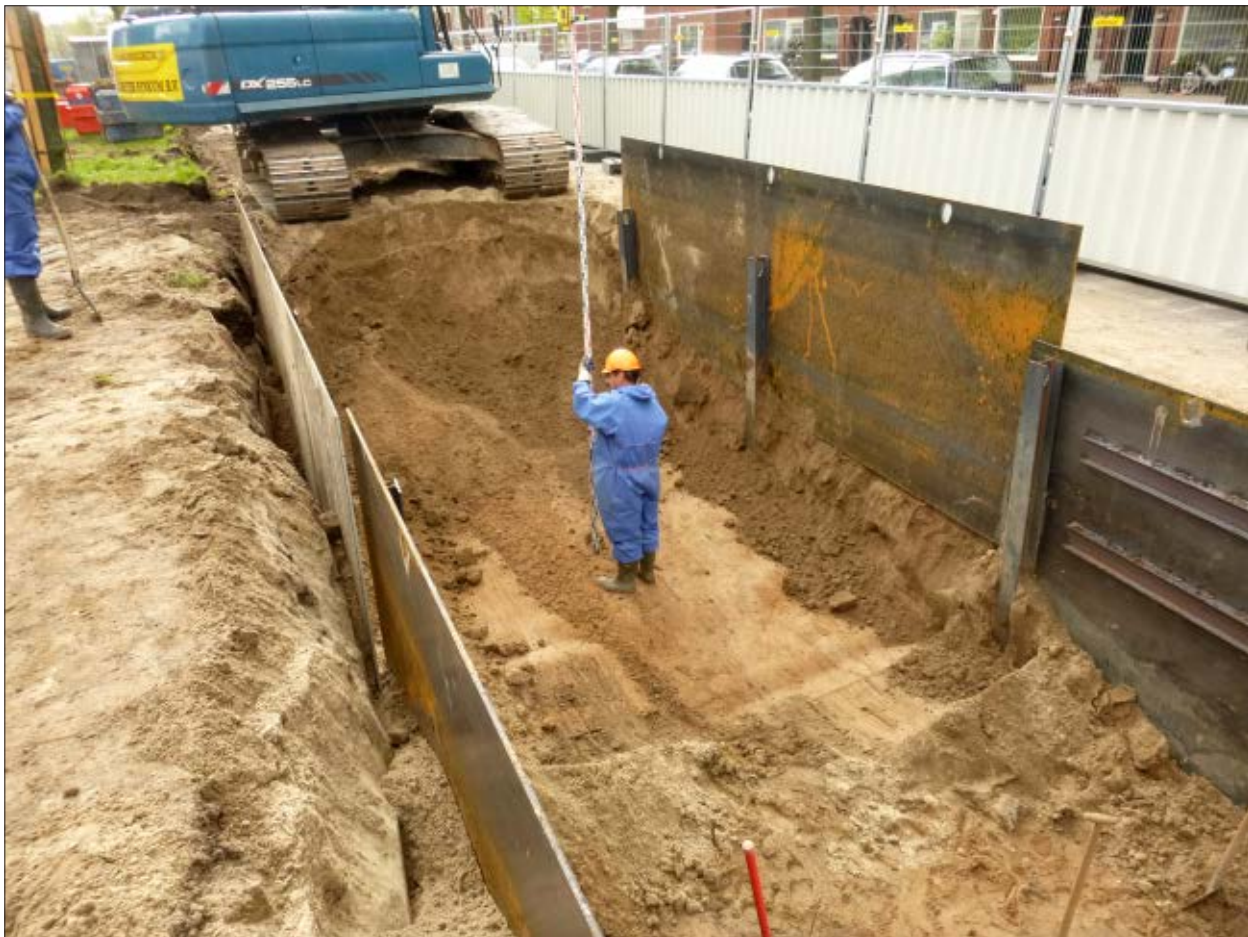
Afb. 1.5a Het uitgraven van de sleuf tussen schotten. Op de bodem is slechts scherp zand te zien, gezien richting het zuidoosten.
