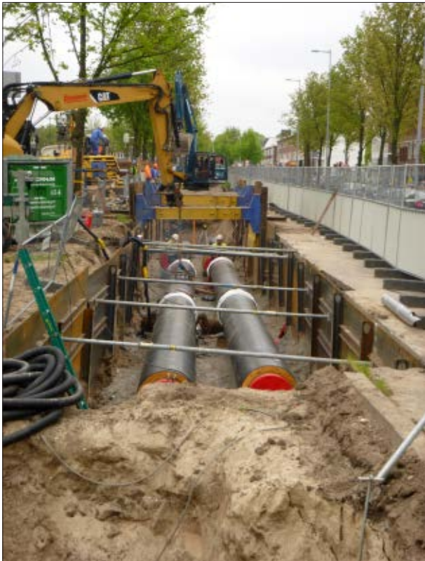
Afb. 1.5d De nieuwe buizen in het cunet, gezien richting het zuidoosten.
