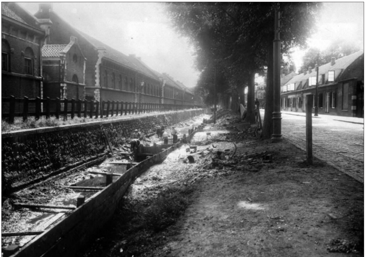
Afb. 2.13c Het aanleggen van een riool ter plaatse van de gedempte gracht langs de Croeselaan in 1931-1932, gezien richting het zuiden. Links de gebouwen van de Van Sypesteynkazerne (Kazerne der Veldartillerie). Het onderzoeksgebied ligt iets naar het zuiden (bron: Het Utrechts Archief, inv.nr. 41810).
