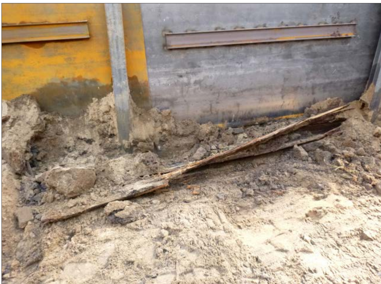
Afb. 3.10 De beschoeiingsplanken op de bodem van de sleuf, gezien richting het oosten.
