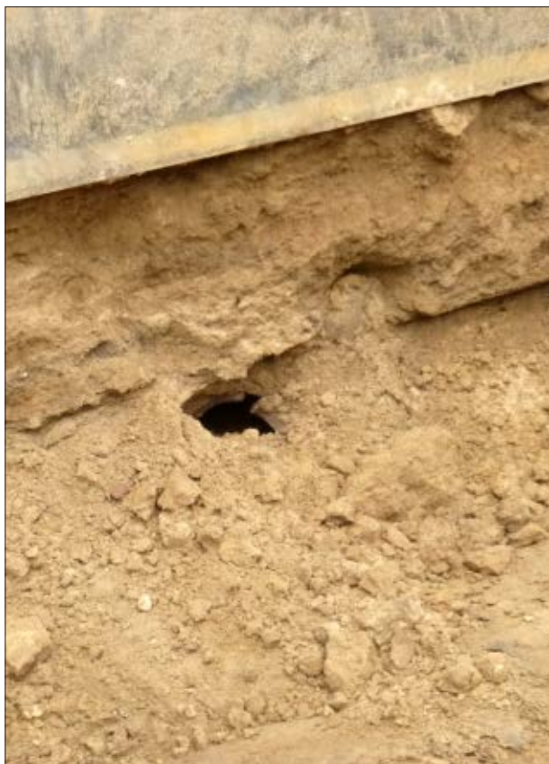
Afb. 3.2 Een gresbuis van een huisaansluiting in de westelijke profielwand. Deze buis sloot ooit aan op een allang verdwenen hoofdriool, dat (iets noordelijker) op afb. 3.3 nog te zien is. Mogelijk is dit hetzelfde riool dat op afb. 2.14c te zien is.
