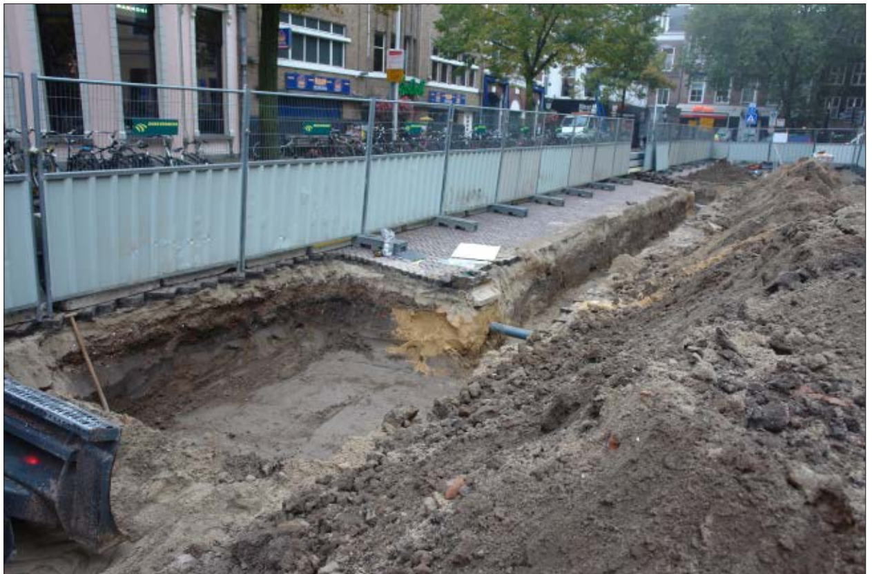
Afb. 4.3 Overzichtsfoto van de werkzaamheden tijdens het onderzoek MP2, waarop te zien is dat de ontgravingsdiepte tijdens dit onderzoek veel groter was. Afbeelding uit het rapport MP2 (bron: Van der Kamp 2016).
