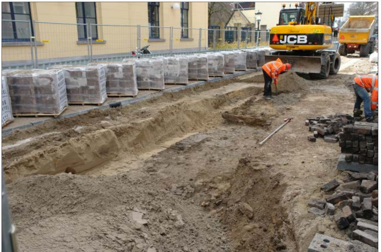
Afb. 4.2 Overzichtsfoto van de werkzaamheden, waarop de vaak geringe ontgravingsdiepte goed te zien is. De top van de postmiddeleeuwse laag komt net in het zicht.
