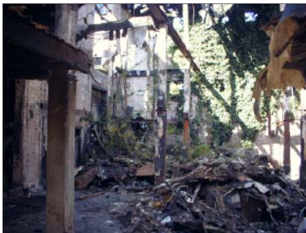
Afb. 3.2 Het interieur van Wittevrouwenstraat 10. De vier stalen staanders op de rechterhelft van de foto stonden op bakstenen poeren. De verstoringen door deze grote structuren zijn op alle archeologische niveaus teruggevonden (fasecode 4A, spoor 13, 14, 18, 36, 157 en 170; zie kaartbijlagen 1 t/m 6).
