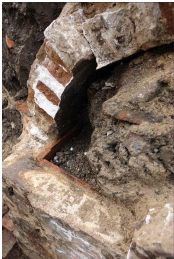
Afb. 4.25 Detailfoto van de waterkelder. Aan de binnenzijde is de kelder bekleed met roodbakkerd plavuizen.
