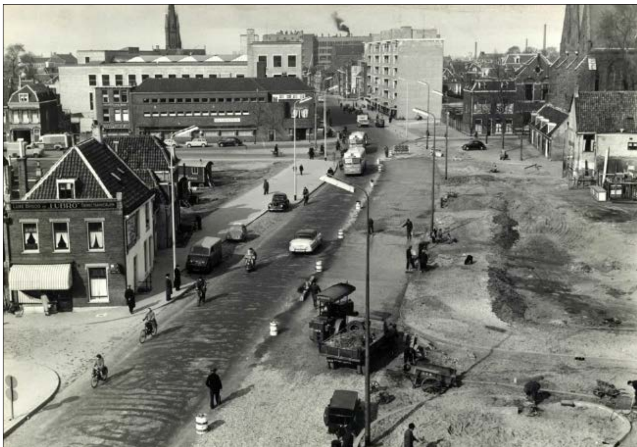
Afb. 3.6b Foto uit 1955 of 1956, richting het noorden. Links de Jacobikerk, op de achtergrond de in 1977 gesloopte Sint-Monikakerk. De deels nog smalle tweebaans Sint Jacobsstraat ligt over de voormalige Florastraat en het Jacobikerkhof. De laatste huizen aan de Florastraat zijn nog niet gesloopt (links). Bron: Het Utrechts Archief, cat.nr 401036.
