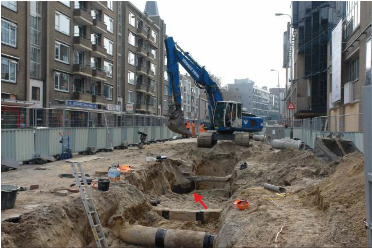
Afb. 1.4 Een diepe sleuf voor het vervangen van het riool in de Sint Jacobsstraat, gezien richting het zuiden. In het profiel is plaatselijk nog de middeleeuwse ophogingslaag (aangegeven met een rode pijl) te zien.
