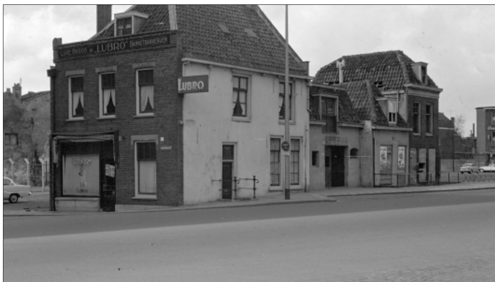
Afb. 4.2 De laatste huizen aan de voormalige Florastraat in 1962, die door de grootschalige sloop aan de Sint Jacobsstraat zijn komen te staan. Duidelijk is te zien dat de nieuwe straat hoger ligt. Bron: Het Utrechts Archief, cat.nr. 20034.
