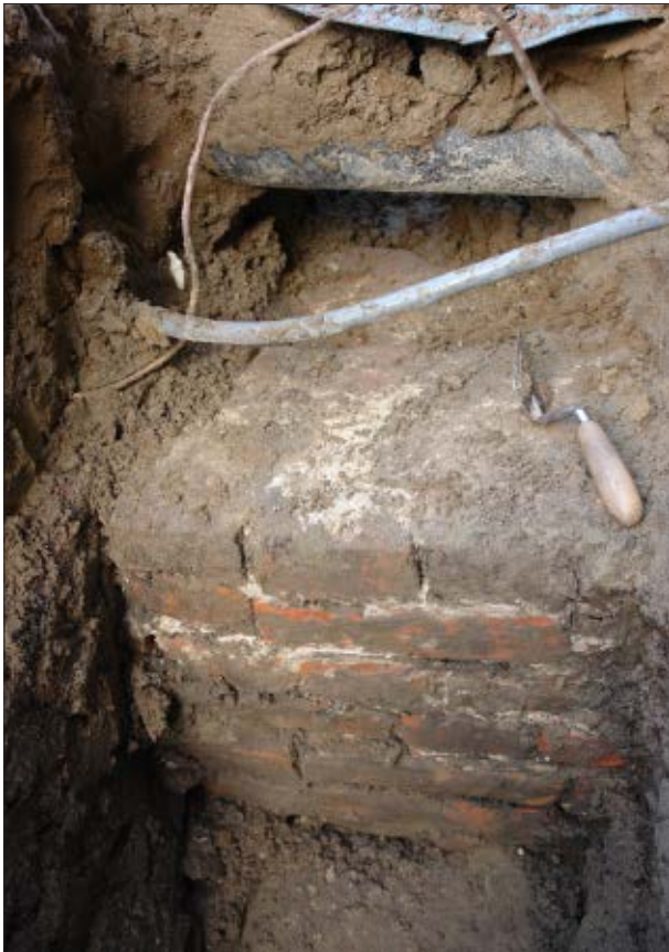
Afb. 4.15 Muur 5 ligt nu onder het oostelijke trottoir van de Sint Jacobsstraat, maar hoorde bij een huis aan de verdwenen Groenesteeg. Gezien richting het noorden.
