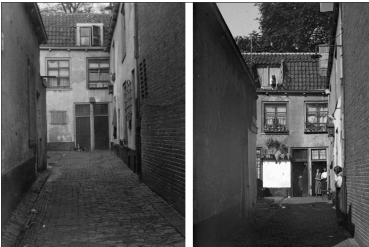
Afb. 4.5b Twee foto's van de Wijnpoort, in westelijke richting genomen vanuit de Groenesteeg. Links in 1924, rechts in 1934. De dakkapel is naar het linker huis verplaatst en er is een grote schoorsteen geplaatst op het rechter huis. Bron: Het Utrechts Archief, cat. nrs. 74368 en 74369.
