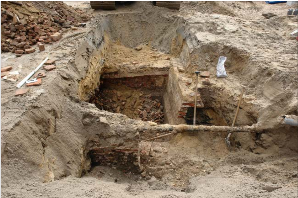
Afb. 4.8 Kelder 2 en muur 4, gezien in zuidelijke richting.
