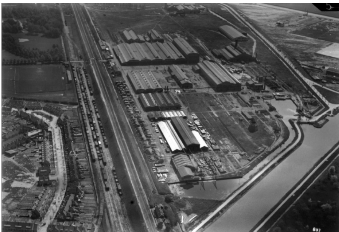
Afb. 2.3 Overzicht van het terrein van Werkspoor rond 1923 met bebouwing (woonhuis), haveninham en fabriekssloot (bron: Het Utrechts Archief, catalogusnummer 120008).
