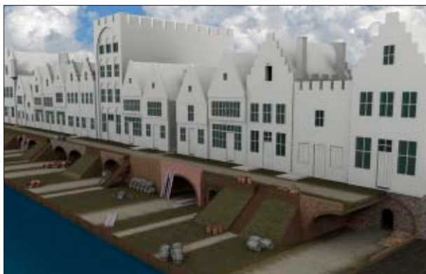
Afb. 2.2c Tunnels en werfkelders (1200-1300)
