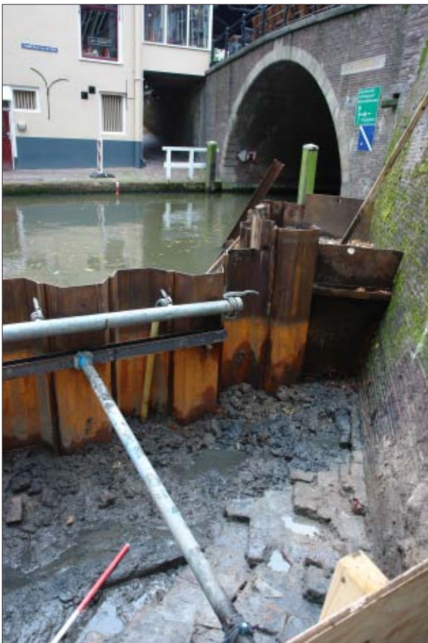
Afb. 5.5 De dertiende-eeuwse fundering van de werfmuur net naast de Bijlhouwersbrug op vlak 2, na het verwijderen van de lage walmuur.
