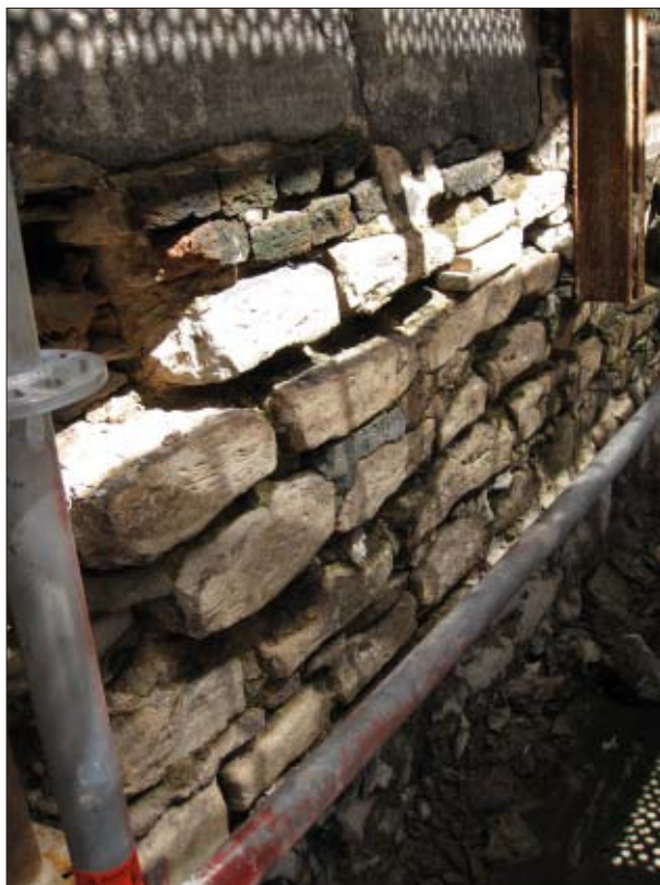
Afb. 4.7 Detail van de kluismuur van huis Leeuwenstein met zicht op het stukje aangetroffen metselwerk van ledesteen (opname: H. Hundertmark 2011).
