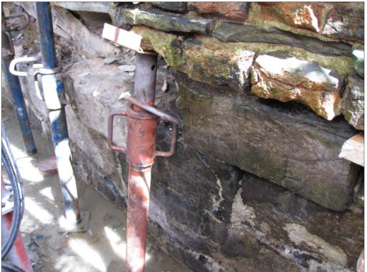
Afb. 4.5 Detail van de kluismuur van huis De Ster met zicht op een stuk van het metselwerk van Doornikse steen (foto: H. Hundertmark 2011).
