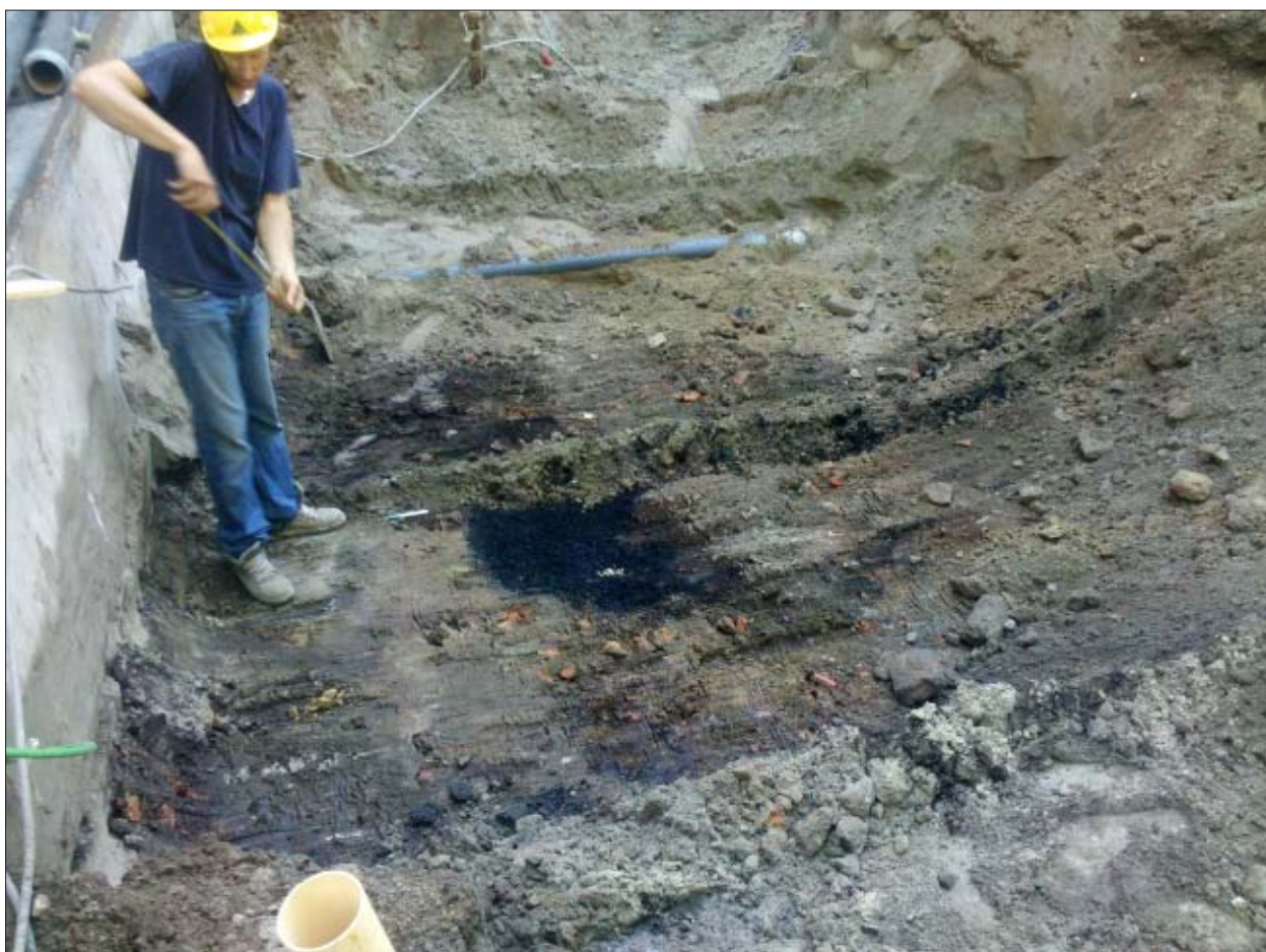
Afb. 2.1 De ontgraving van het talud in de eerste fase. De ondergrond bestaat voornamelijk uit verrommeld scherp zand met bouwpuin, mogelijk afkomstig uit de periode van de bouw van de Stadsschouwburg.
