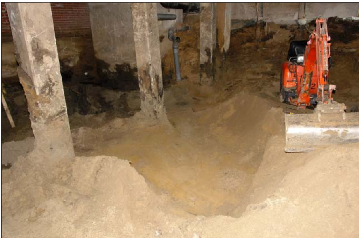
Afb. 2.2 De ontgraving van het kelderniveau in de tweede fase. Ook het diepste ontgravingsniveau bestaat nog uit opgebracht scherp zand.
