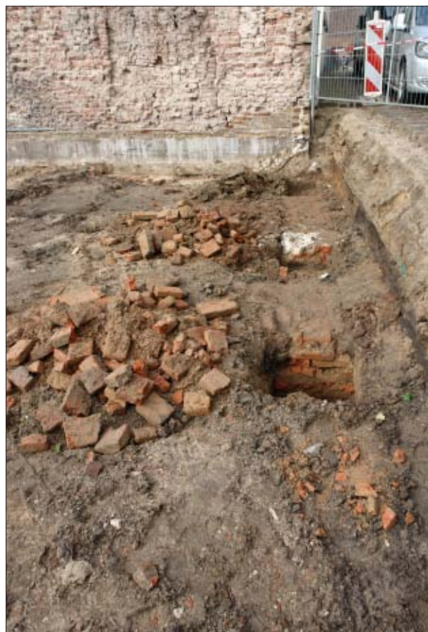
Afb. 3.3 Het slopen van een deel van de fundering S25 ter plekke van de nog te boren funderingspalen, gezien in westelijke richting.
