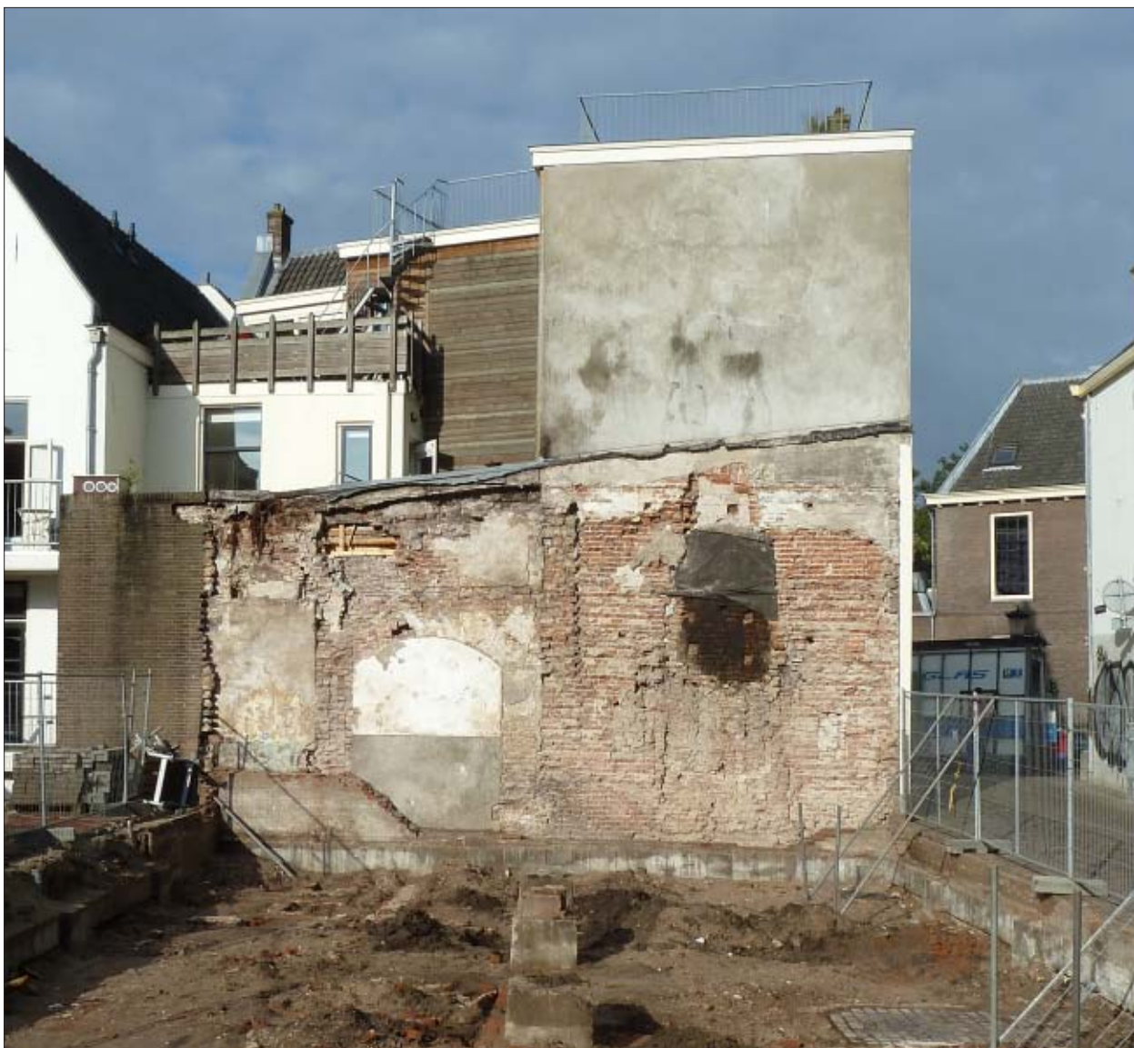
Afb. 4.7 Foto van het aanzicht van de van oorsprong gemeenschappelijke gevel tussen Molenstraat 3 en Plompentorengracht 13 en de zijgevel van de achternleugel van Molenstraat 3 (foto: H. Hundertmark).
