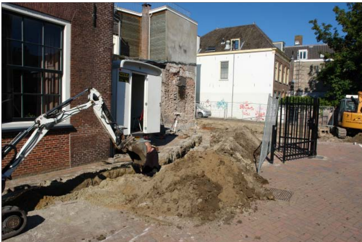
Afb. 3.6 Sleuf 2, gezien in noordelijke richting.
