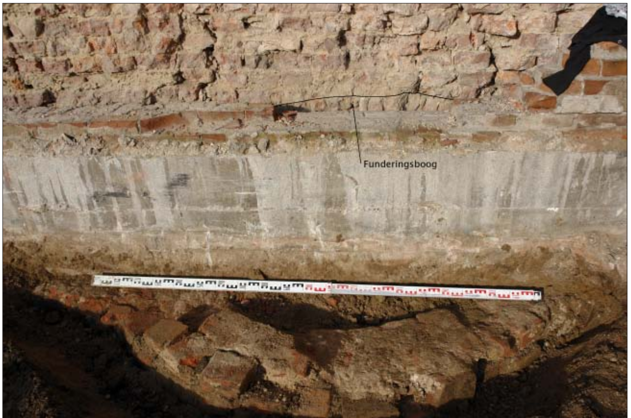
Afb. 5.5 De beerput onder de achtergevel van het pand Plompetorengracht 13, gezien in westelijke richting. Boven de betonnen fundering van het schoolgebouw uit 1936 is nog net de bovenkant van de boog te zien die onderdeel van de beerputkoepel vormde.
