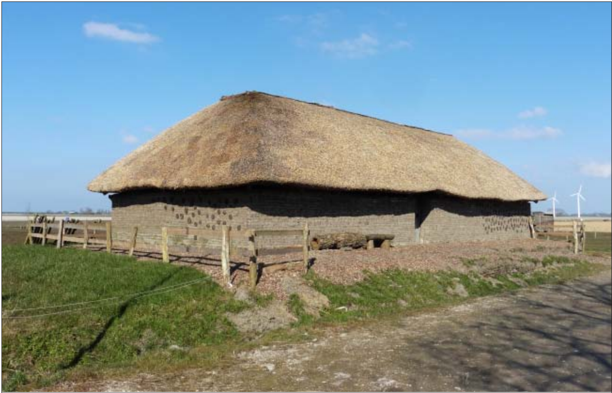
Afb. 8.9 De reconstructie van een zodenwandhuis in Firdgum, gebouwd door het Yeb Hettinga Museum in samenwerking met de Rijksuniversiteit Groningen (RUG) (Foto: H.L. Wynia).
