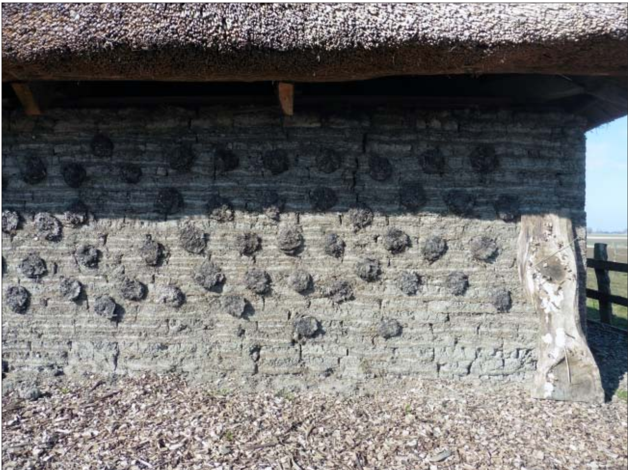
Afb. 8.10 Op de wand zijn schijven mest aangebracht, die daar te drogen hangen. Eenmaal gedroogd vallen zij naar beneden, en zijn dan klaar voor gebruik als brandstof (Foto: H.L. Wynia).
