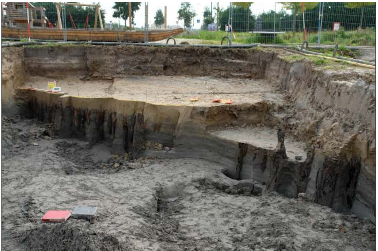
Afb. 3.4 Een deel van de beschoeiing A1/A12 van LR62 uit 2008 in dwarsdoorsnede richting het zuidoosten. Het hekwerk op de achtergrond geeft de grens met het onderzoeksgebied van LR78 aan.
