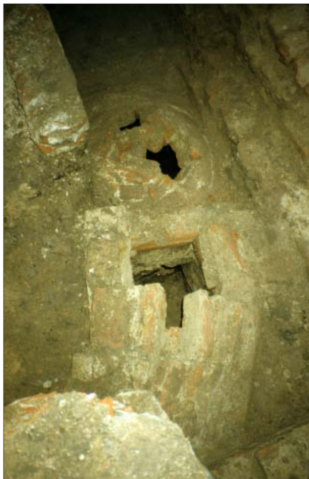
Afb. 5.24 BP-A met de glijgoot, gezien in oostelijke richting.
