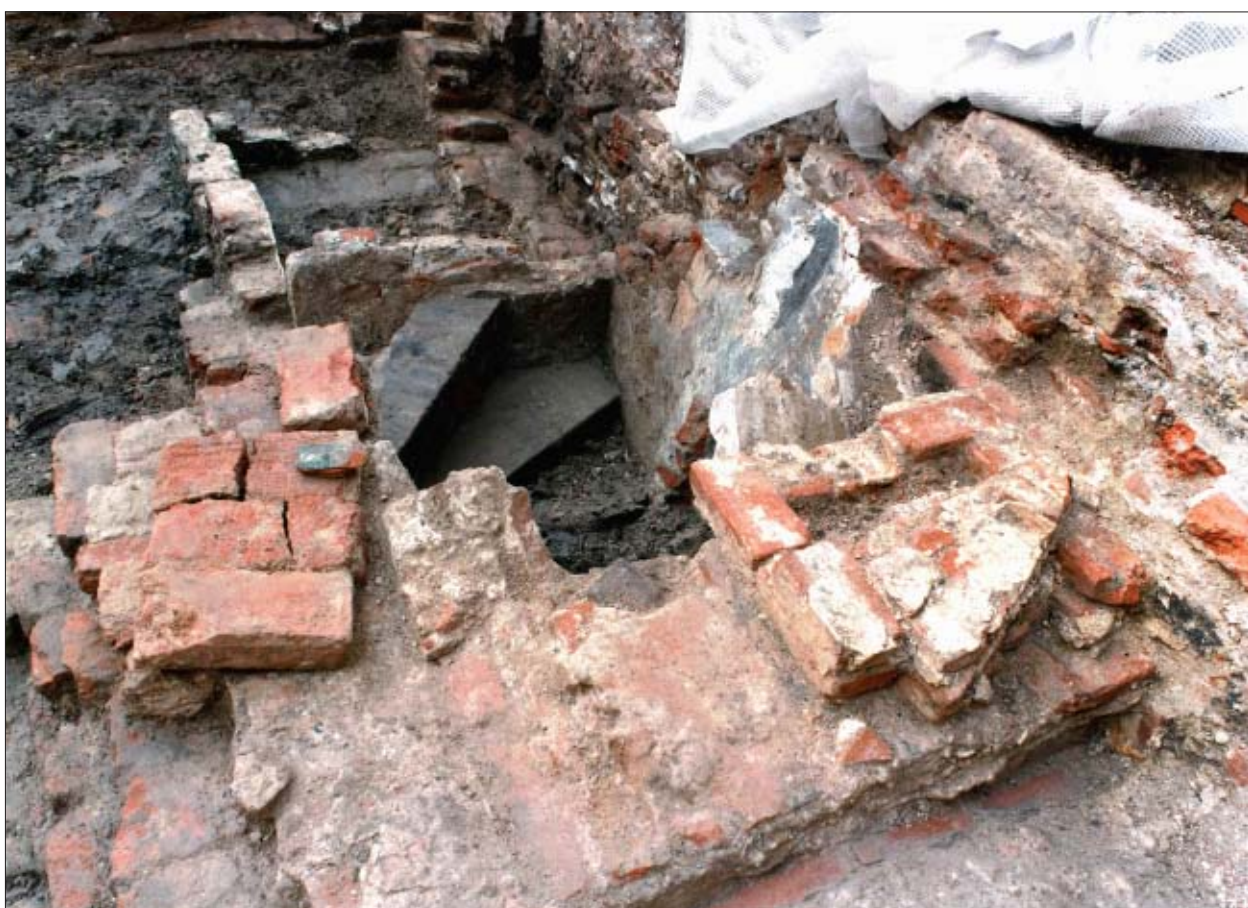
Afb. 5.7 De (oorspronkelijke) kelderingang met zeventiende- en negentiende-eeuwse traptreden, gezien in noordwestelijke richting. Bron: Het Utrechts Archief.
