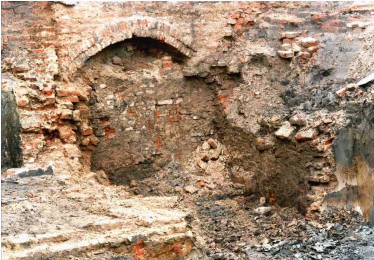
Afb. 5.12 Kelder S165 gezien in zuidoostelijke richting. Bron: Het Utrechts Archief.
