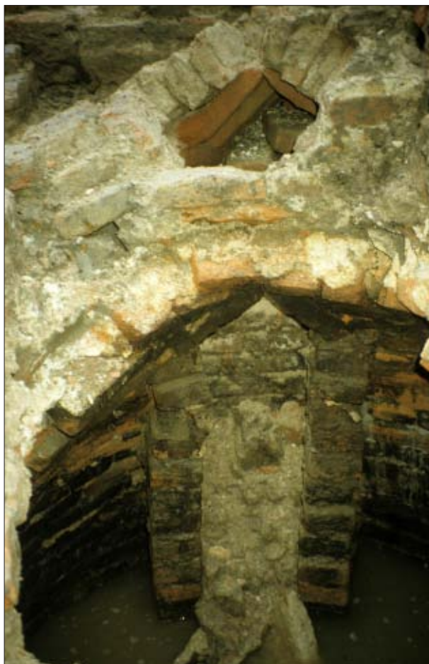
5.22 De binnenkant van BP-A met stortkoker, gezien in westelijk richting.
