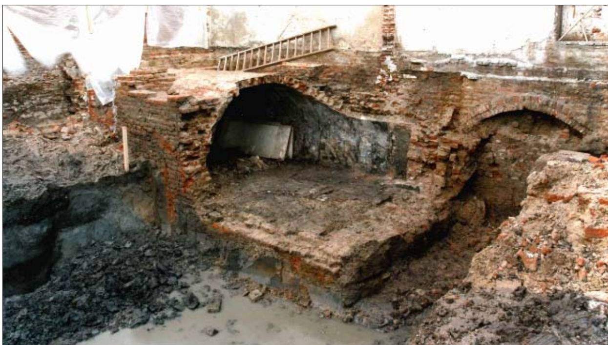
Afb. 5.13 Links kelder S180 en rechts het restant van kelder S165, gezien in noordoostelijke richting. Bron: Het Utrechts Archief.
