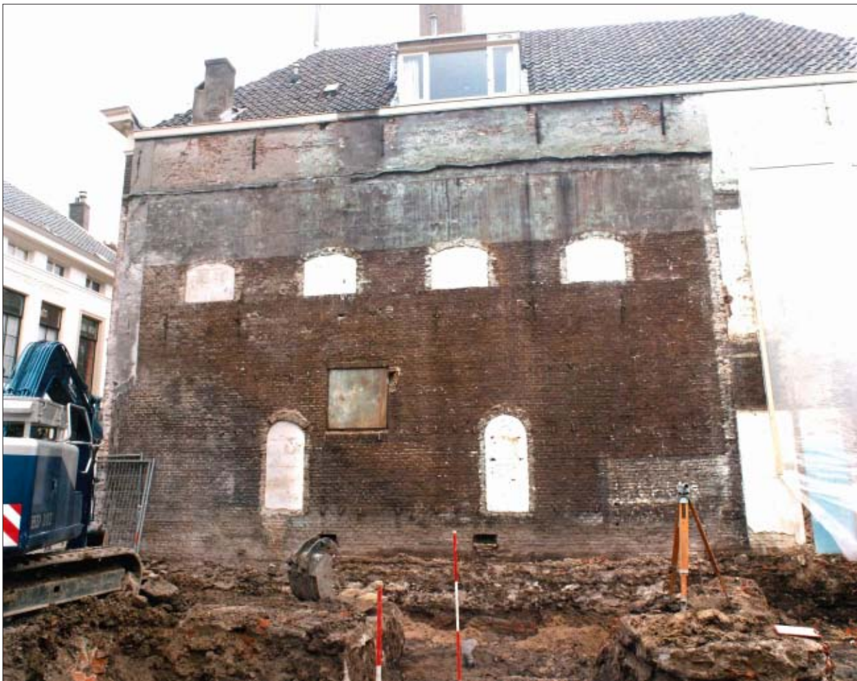
Afb. 15.18 De zijmuur van het belendende pand van Ambachtstraat nummer 3. Op de eerste etage werden vier nissen uitgehakt bij de bouw van de boekbinderij in 1900, gezien richting het noorden.
