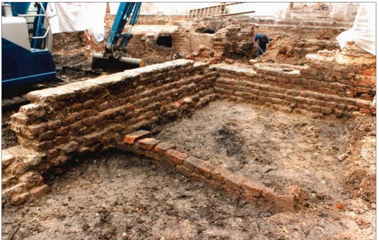
Afb. 5.16 De veertiende-eeuwse muur S210 gezien in noordoostelijke richting. Bron: Het Utrechts Archief.
